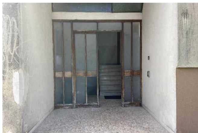
Vista dell'ingresso al vano scala comune
