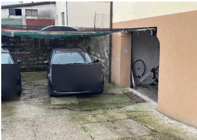
Vista dell'ingresso all'autorimessa indivisa
