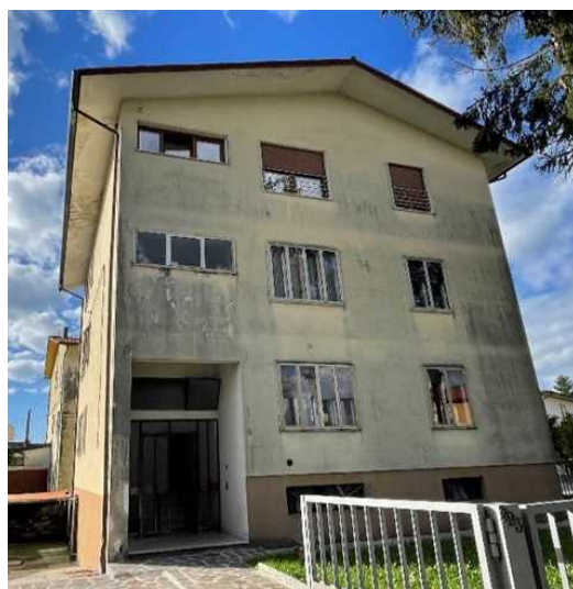
Vista del fabbricato da Sud-Ovest
