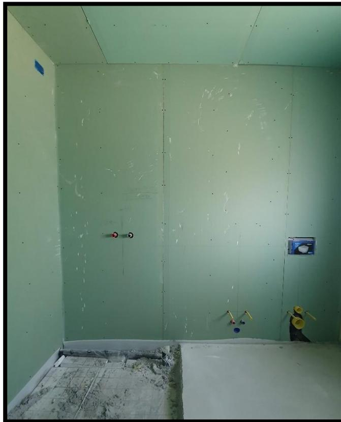
*Foto: Esempio pareti cartongesso del tipo idrorepellente*
