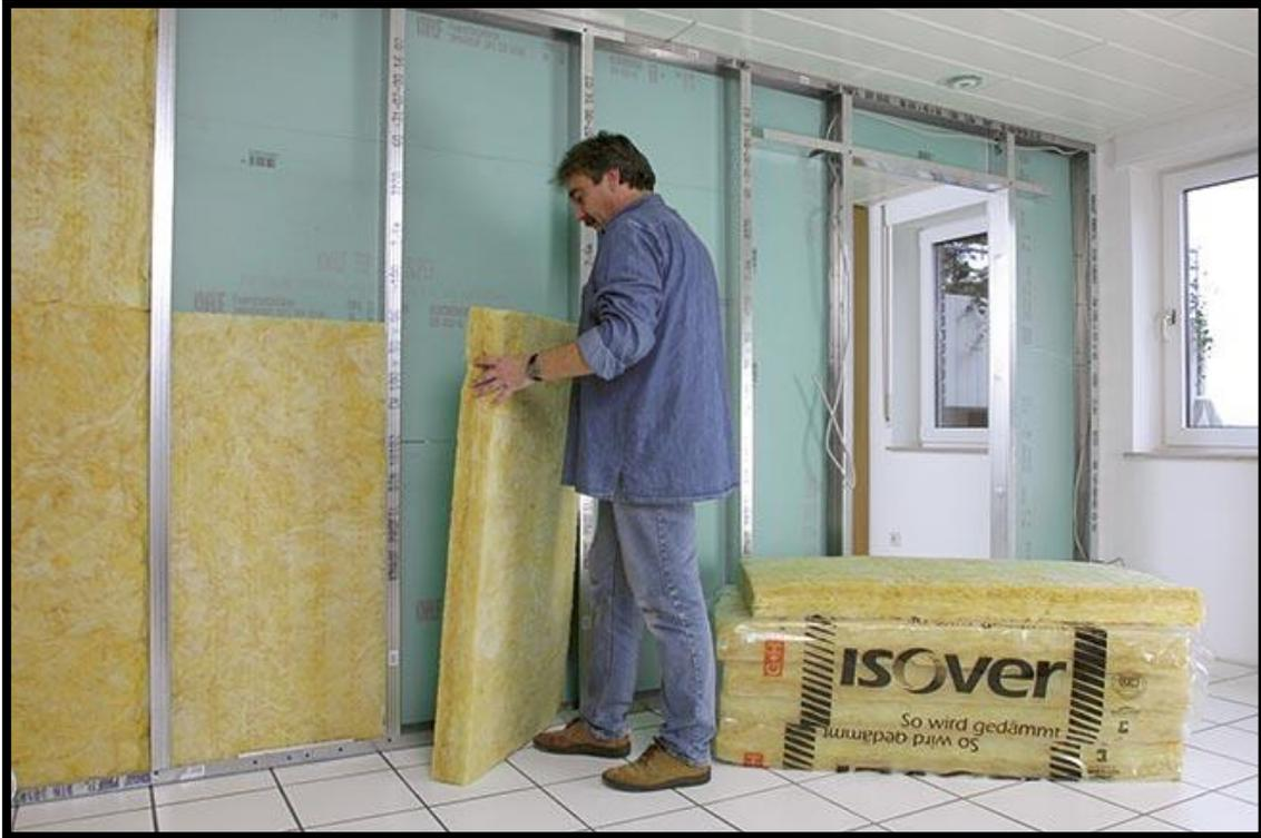
*Foto: Esempio di posa isolamento pareti cartongesso*
