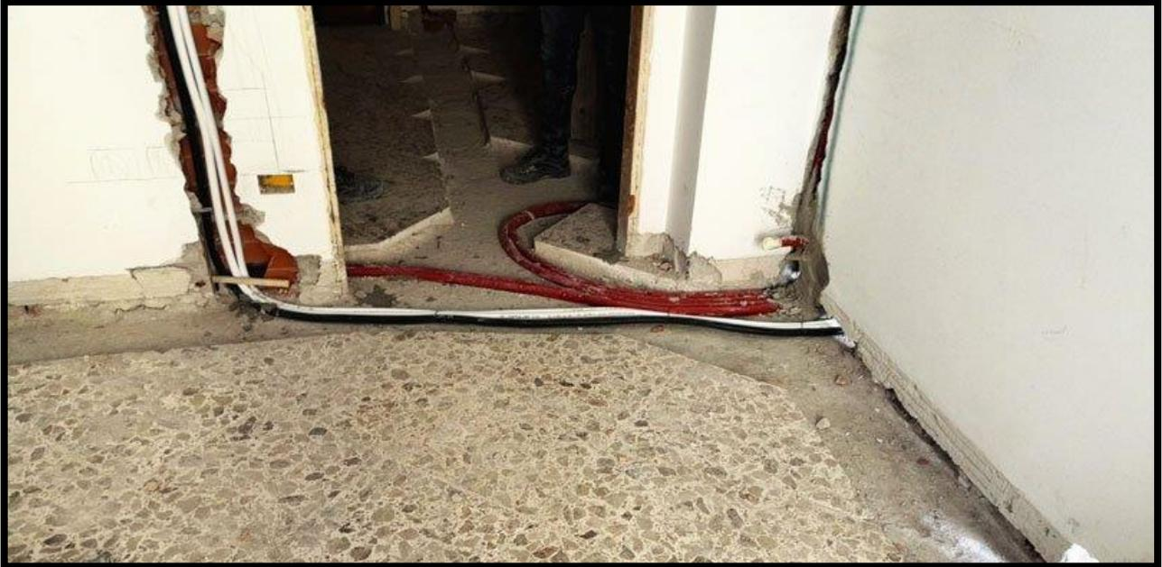
*Foto: Esempio di posa nuove linee nel pavimento esistente*
