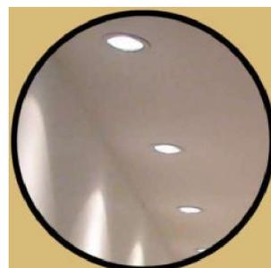
*Verranno creati nuovi **controsoffitti** con lastre di cartongesso con struttura metallica in profilati di lamiera zincata.*
