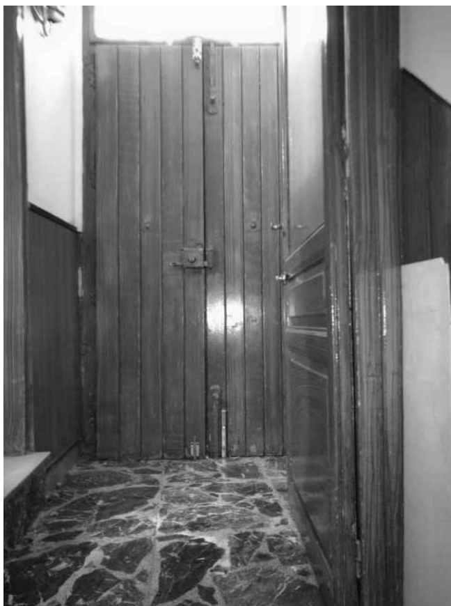
FOTO 12 – VANO 8 (VANO SCALA)
