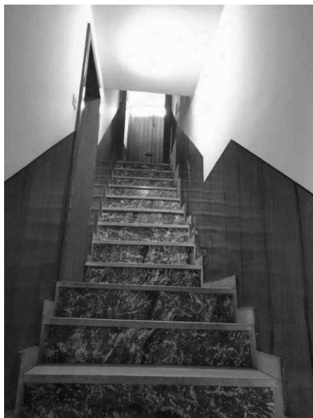
FOTO 7 – VANO 5 (VANO SCALA)
