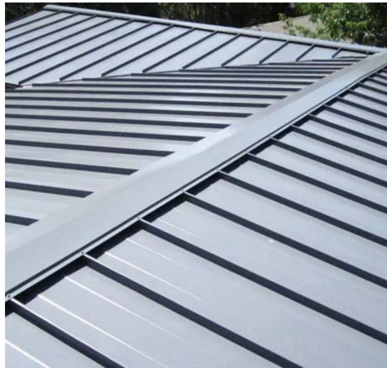
COPERTURA CON LAMIERA GRECATA
