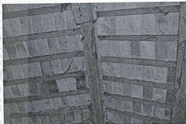
8 – Copertura del granaio. Dove il tetto superiore insiste sul locale catastalmente denominato "granaio", l'ordito abbandona il tavolato ad assi alterne e passa al laterizio tra un conventino e l'altro. Tra il pavimento della soffitta e il tetto in foto c'è lo stesso interpiano misurabile nell'attigua Legnaia, inframmezzato però dal solaio di cui alla foto n. 9.
