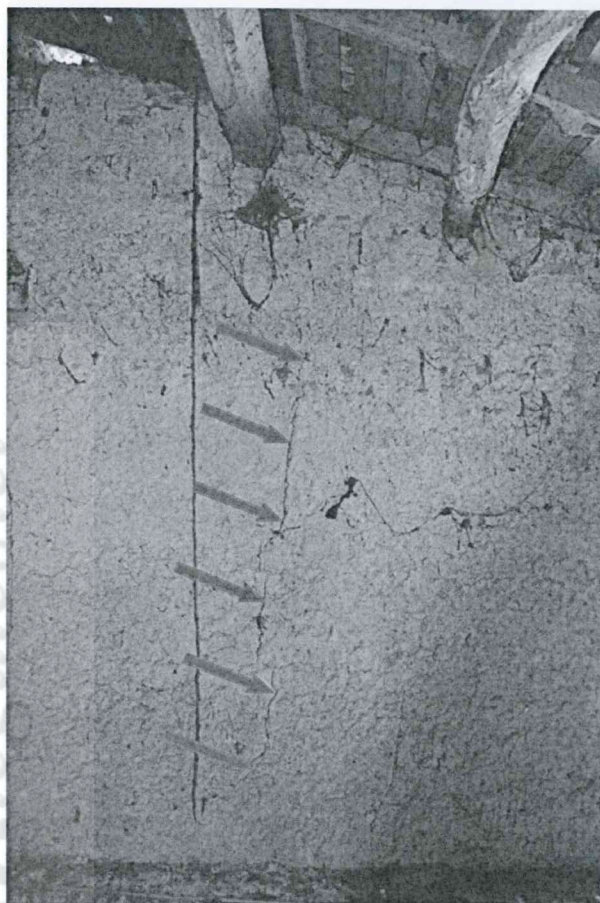
2 – Legnaia al primo piano. Il muro di spina che separa il locale dalla soffitta presenta una spaccatura verticale a tutto spessore di paramento (vedi frecce blu).
