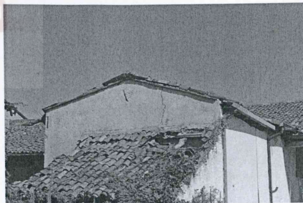
20 – Anche il timpano del brolo esibisce una spaccatura verticale a tutta altezza.
