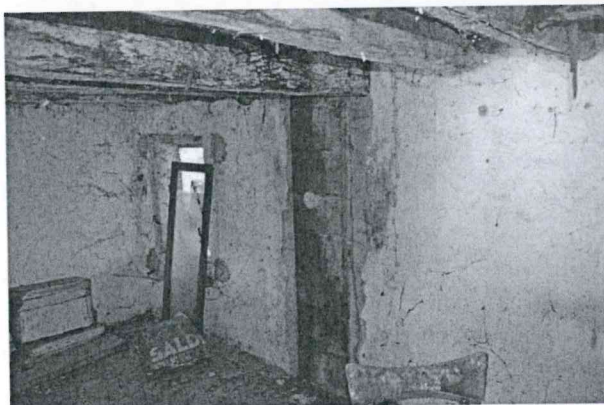
9 – Soffitta. Al locale si accede attraversando la breccia in foto n. 5. Il muro nord è interrotto a tutta altezza da una canna fumaria. Il locale ha altezza utile circa 1,85/1,90m.
