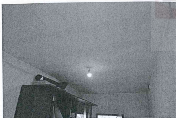
19 – Interno abitazione. Anche le "bruciature" di condensa intradossali depongono a favore dell'ipotesi di solaio in laterocemento tra pianterreno (abitazione) e primo piano (legnaia).
