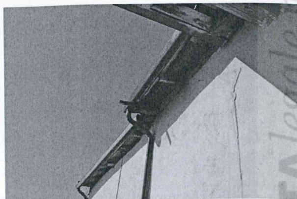
17 – Brolo mm.nn. 113/149. I legni di gronda mostrano elevato deterioramento da vetustà.
