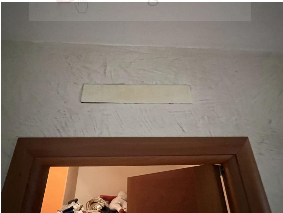
Foto 22 - predisposizione per l'impianto di condizionamento
