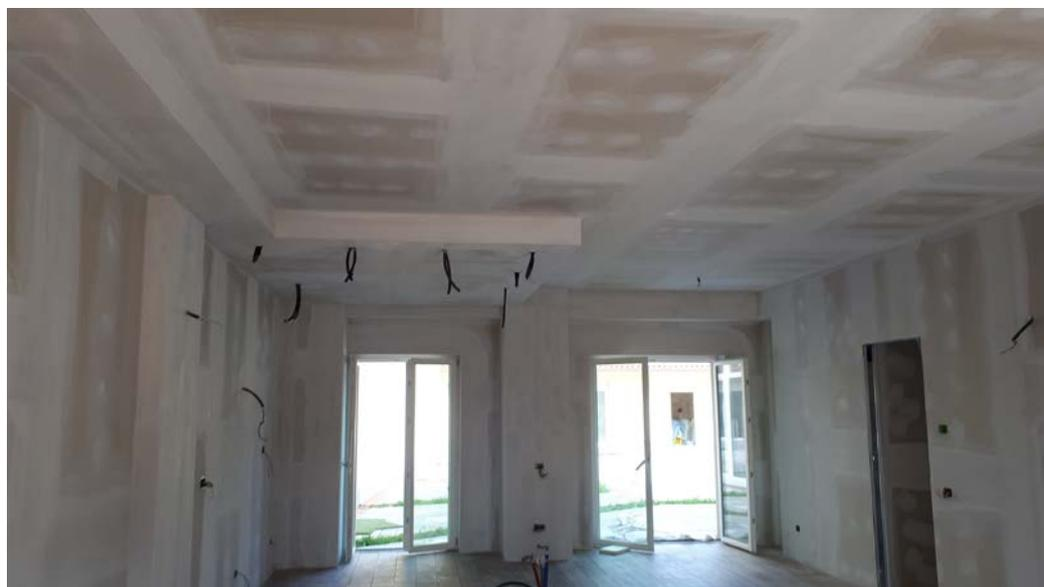
I divisori interni di separazione tra i diversi locali (fig. 3 e fig.4) saranno realizzati con struttura metallica e rivestiti in entrambi i lati con doppia lastra in gesso rivestito (1) e isolante termoacustico in lana di roccia (2) nell'intercapedine della struttura.
