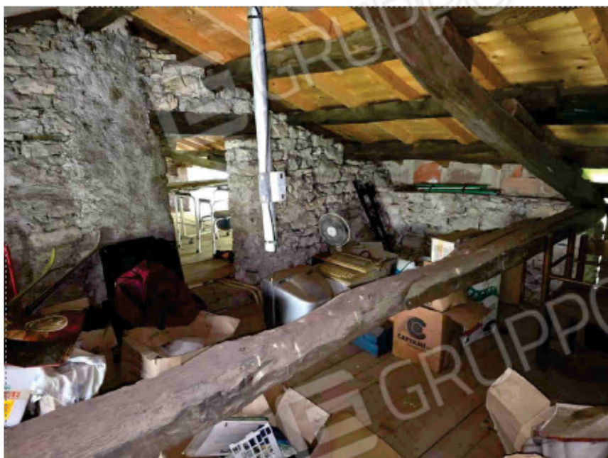
Foto n. 11 - C.F. Fg. 81 mapp. 524 - Piano secondo, soffitta
