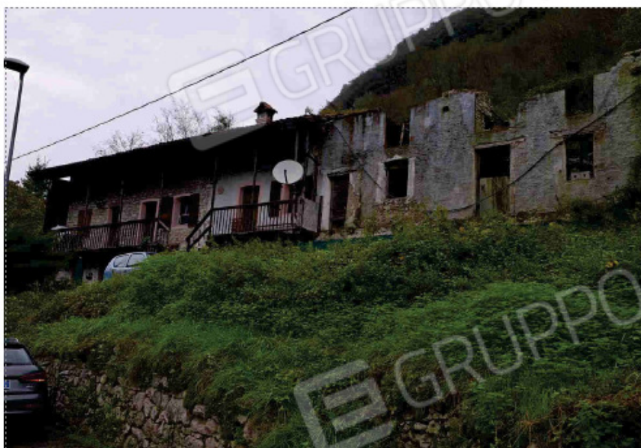
Foto n. 1 C.F. Pg. 81 mapp. 524 Fabbricato vista da sud-ovest
