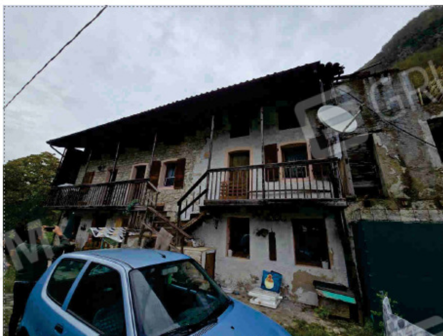
Foto n. 2 C.F. Pg. 81 mapp. 524 Fabbricato vista da sud-ovest
