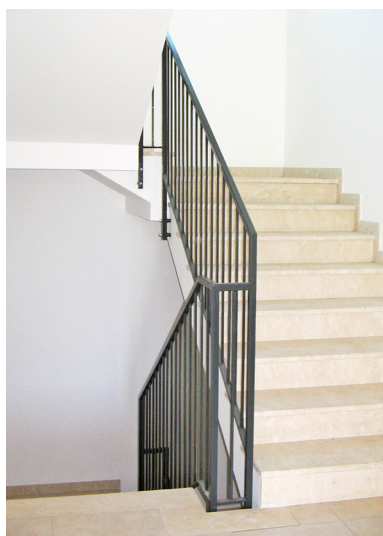
F _ Scala interna
