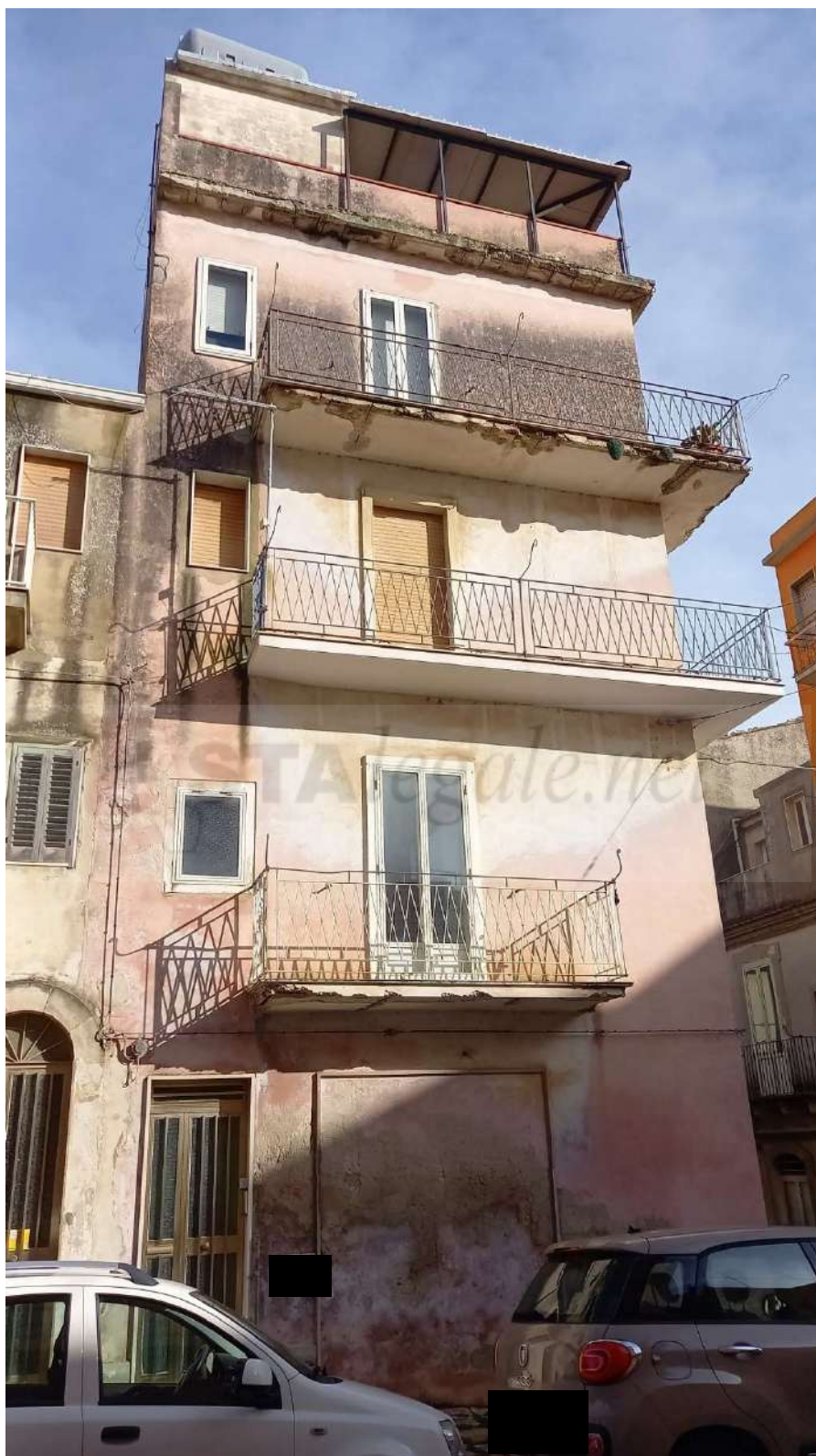
FOTO N. 1 - prospetto su via Generale Scrofani
