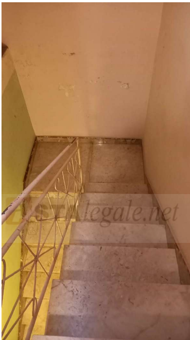
FOTO N. 3 - scala accesso piano terzo
