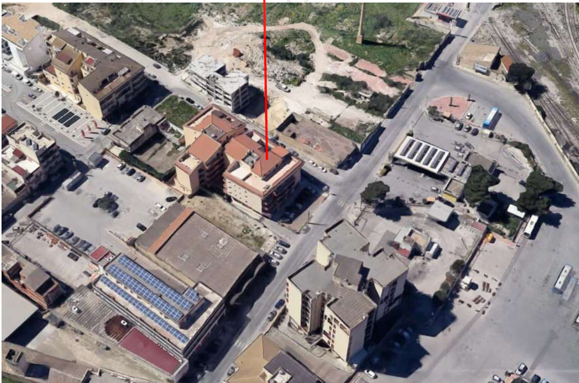
Figura n. 2.6 : Foto satellitare dell'unità immobiliare oggetto di stima
