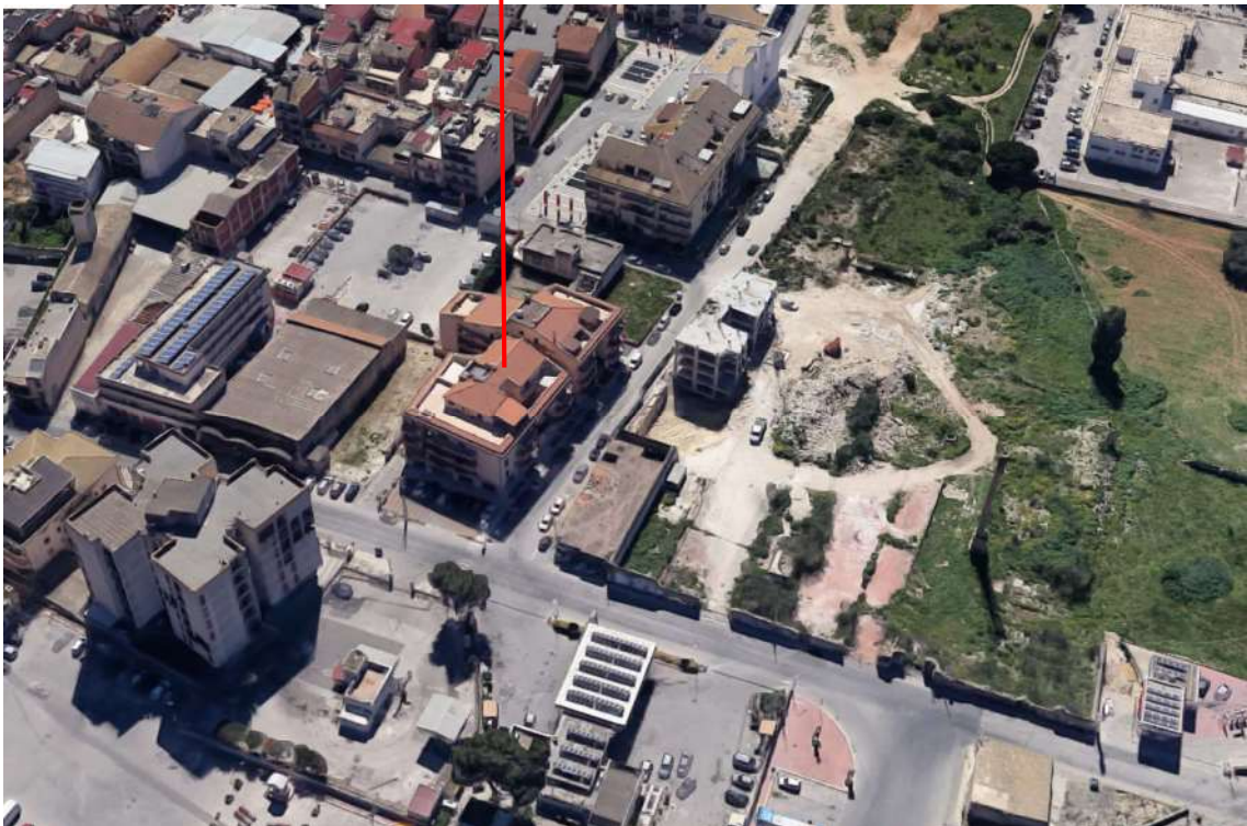
Figura n. 2.5 : Foto satellitare dell'unità immobiliare oggetto di stima
