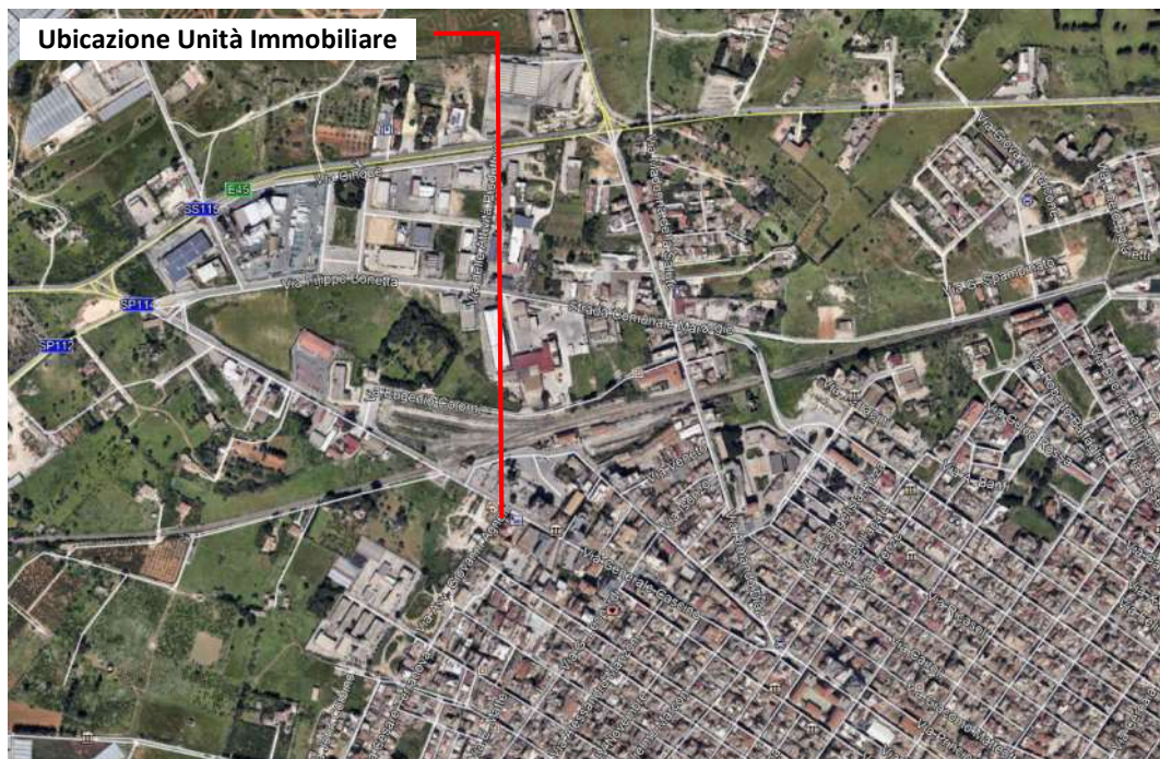
Figura n. 2.2 : Foto satellitare dell'unità immobiliare oggetto di stima
