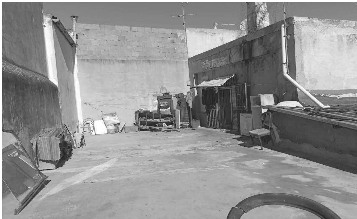
Foto 13 Lotto 2 – Lastrico solare appartamento piano primo
