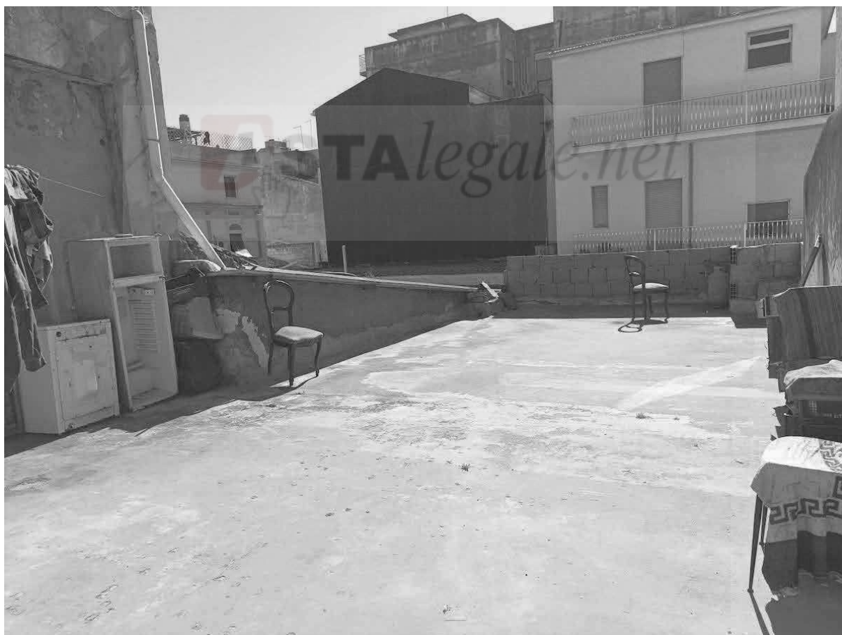
Foto 12 Lotto 2 – Lastrico solare appartamento piano primo
