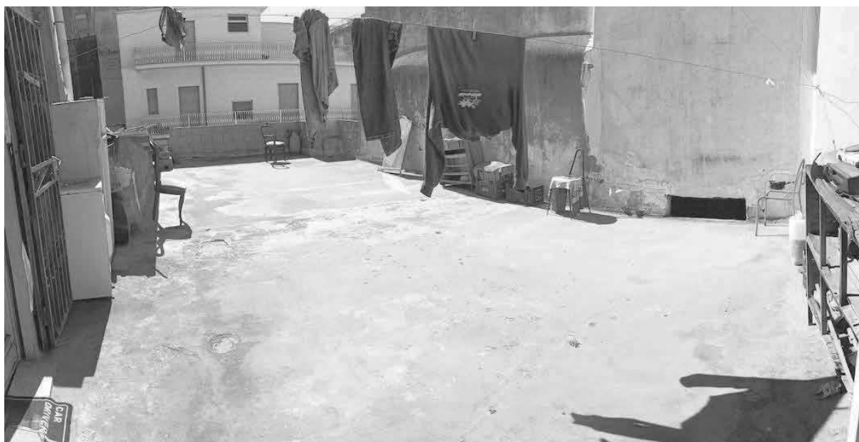
Foto 11 Lotto 2 – Lastrico solare appartamento piano primo
