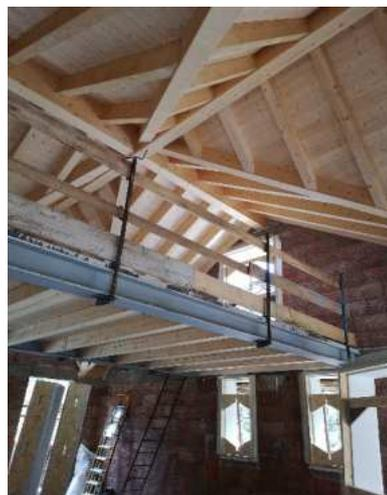
I solai intermedi dei soppalchi saranno realizzati con travetti in legno lamellare dim. cm 12 x 18 sui quali verranno fissati connettori tecnaria tipo CLT base 12/40, intestati su travature in acciaio del tipo HEM 200, con sovrastante assito di finitura, completo di membrana traspirante e getto integrativo con rete elettrosaldata diam. 6 mm – maglia cm 20x20.
