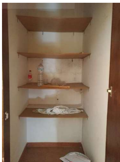
FOTO 26 VANO 11 PIANO SECONDO
