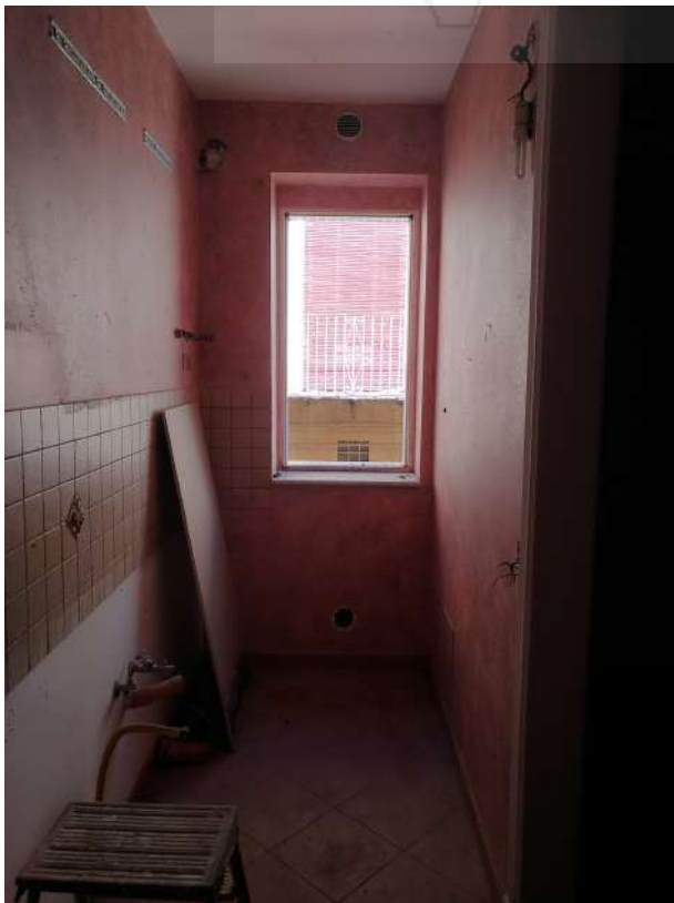
FOTO 20 VANO 7 PIANO PRIMO
