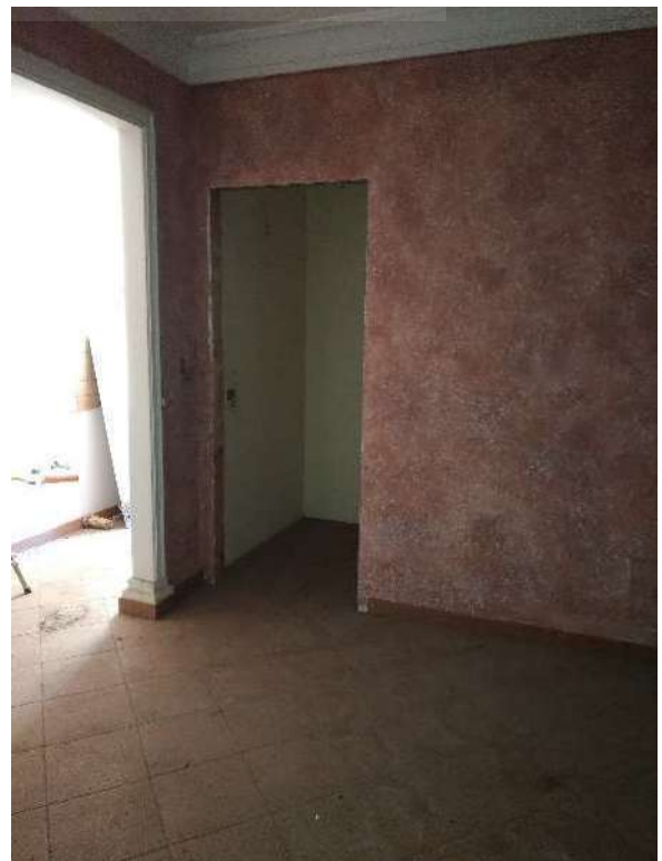
FOTO 14 VANO 6 PIANO PRIMO
