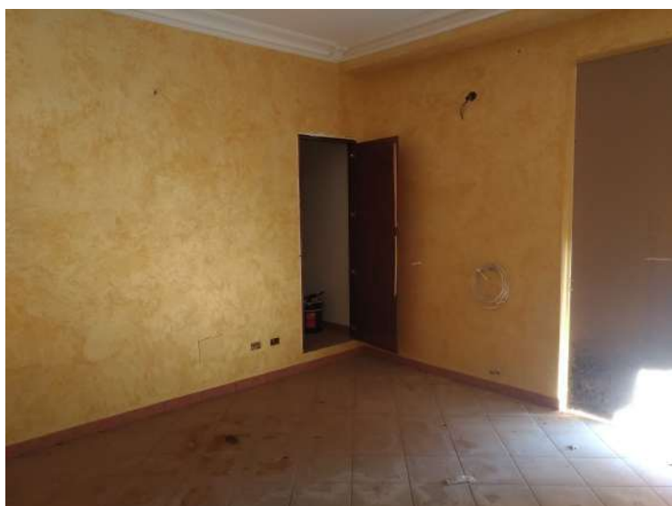
FOTO 25 VANO 10 PIANO SECONDO
