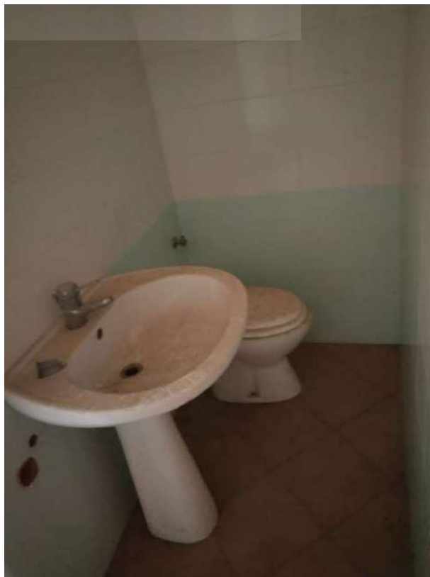
FOTO 21 VANO 8 PIANO PRIMO
