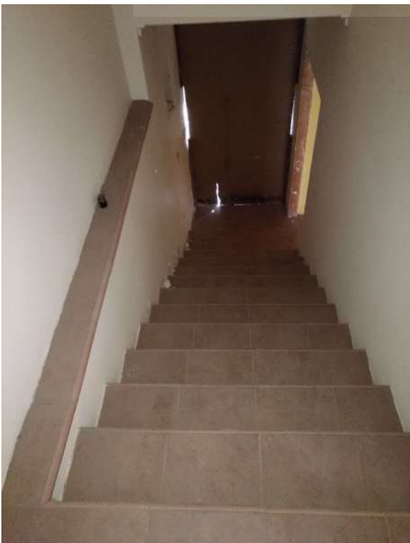
FOTO 13 VANO 5 ( VANO SCALA )
