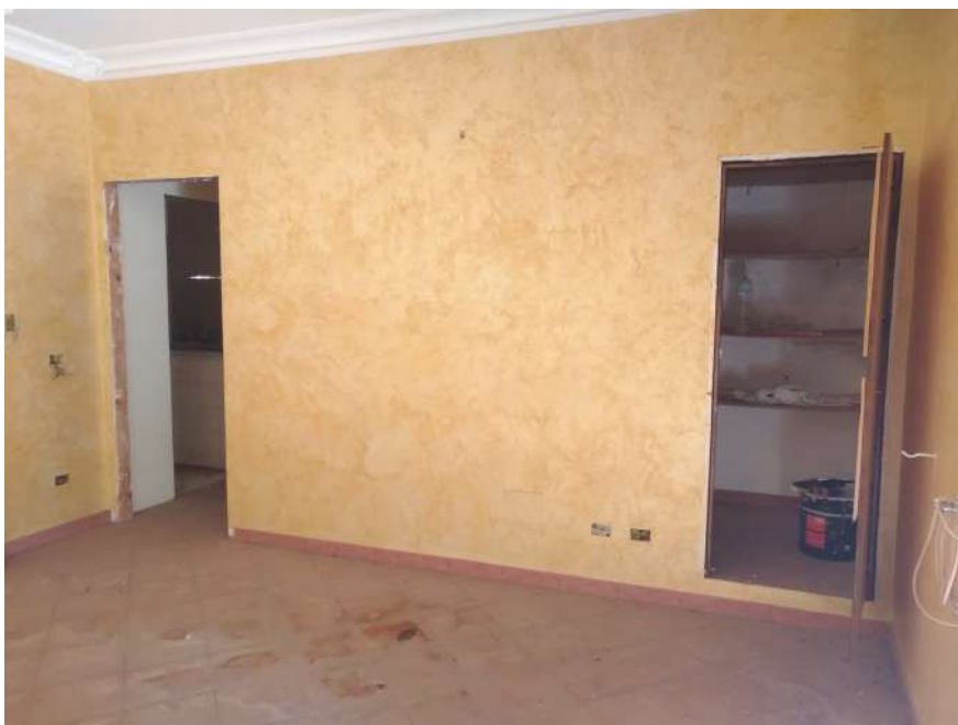
FOTO 24 VANO 10 PIANO SECONDO
