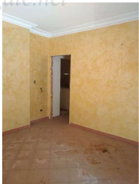
FOTO 23 VANO 10 PIANO SECONDO
