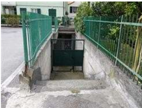
scala accesso ai box interrati mappale 670
