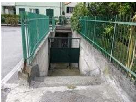
scala accesso ai box interrati mappale 670
