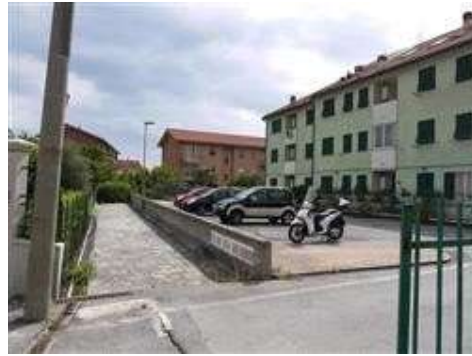
camminamento pedonale lato nord ovest mappale 671
