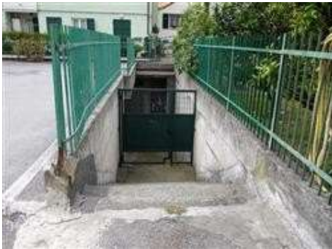
scala accesso ai box interrati mappale 670
