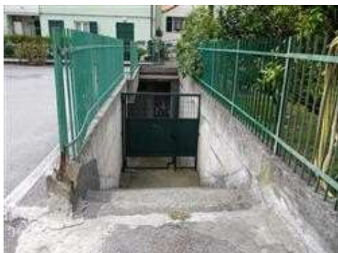
scala accesso ai box interrati mappale 670
