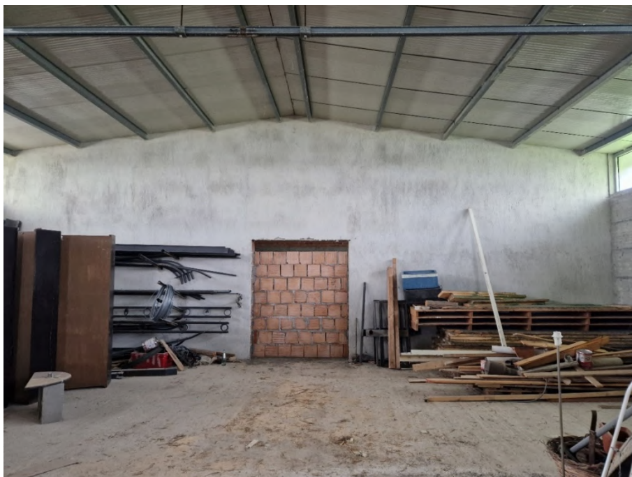
Foto 8 – Parete di divisione tra le due unità/Pavimentazione
