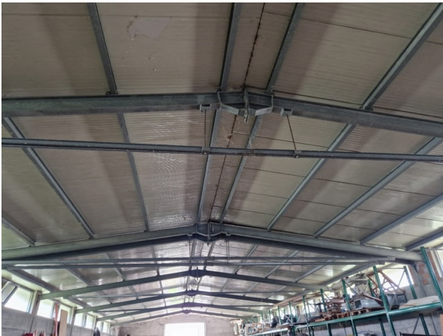
Foto 6 – Struttura e Manto di copertura
