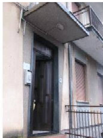
Vista ingresso condominiale (PT)
