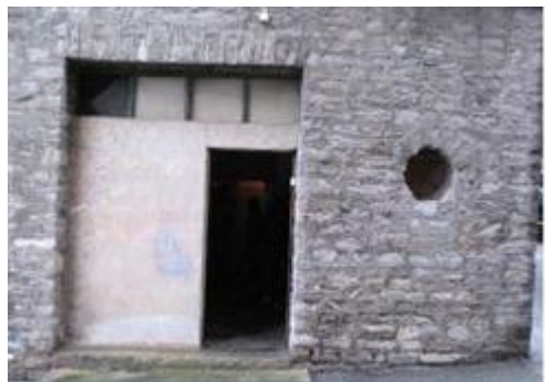
Vista ingresso condominiale (PS1)
