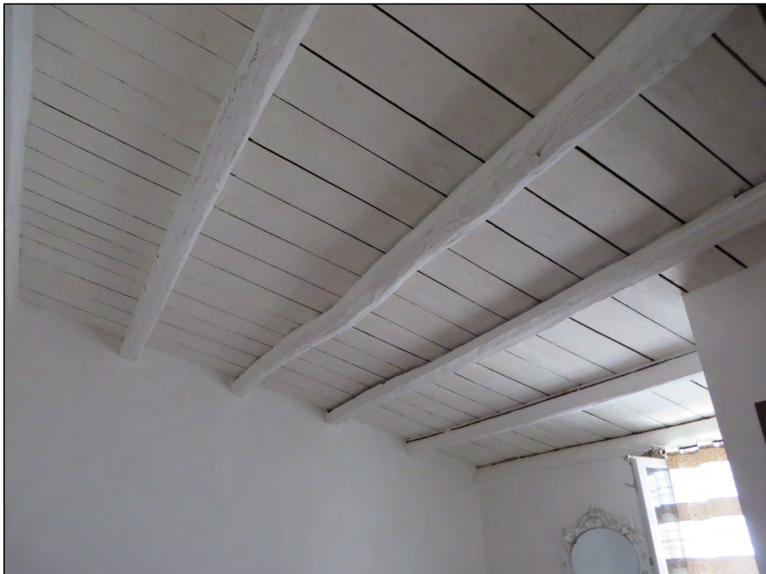
Struttura della copertura
