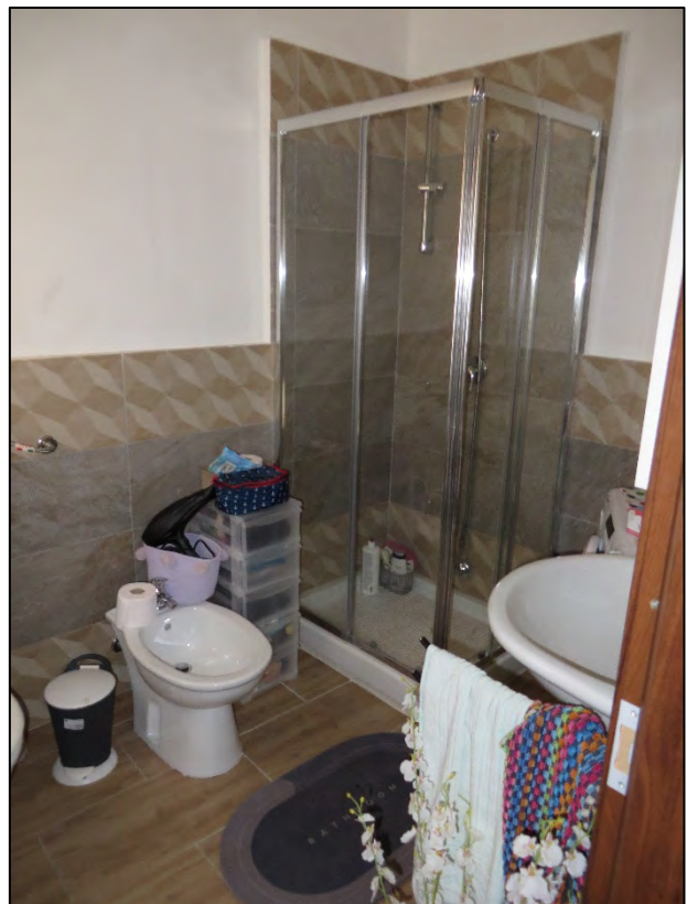
Servizio igienico di primo piano
