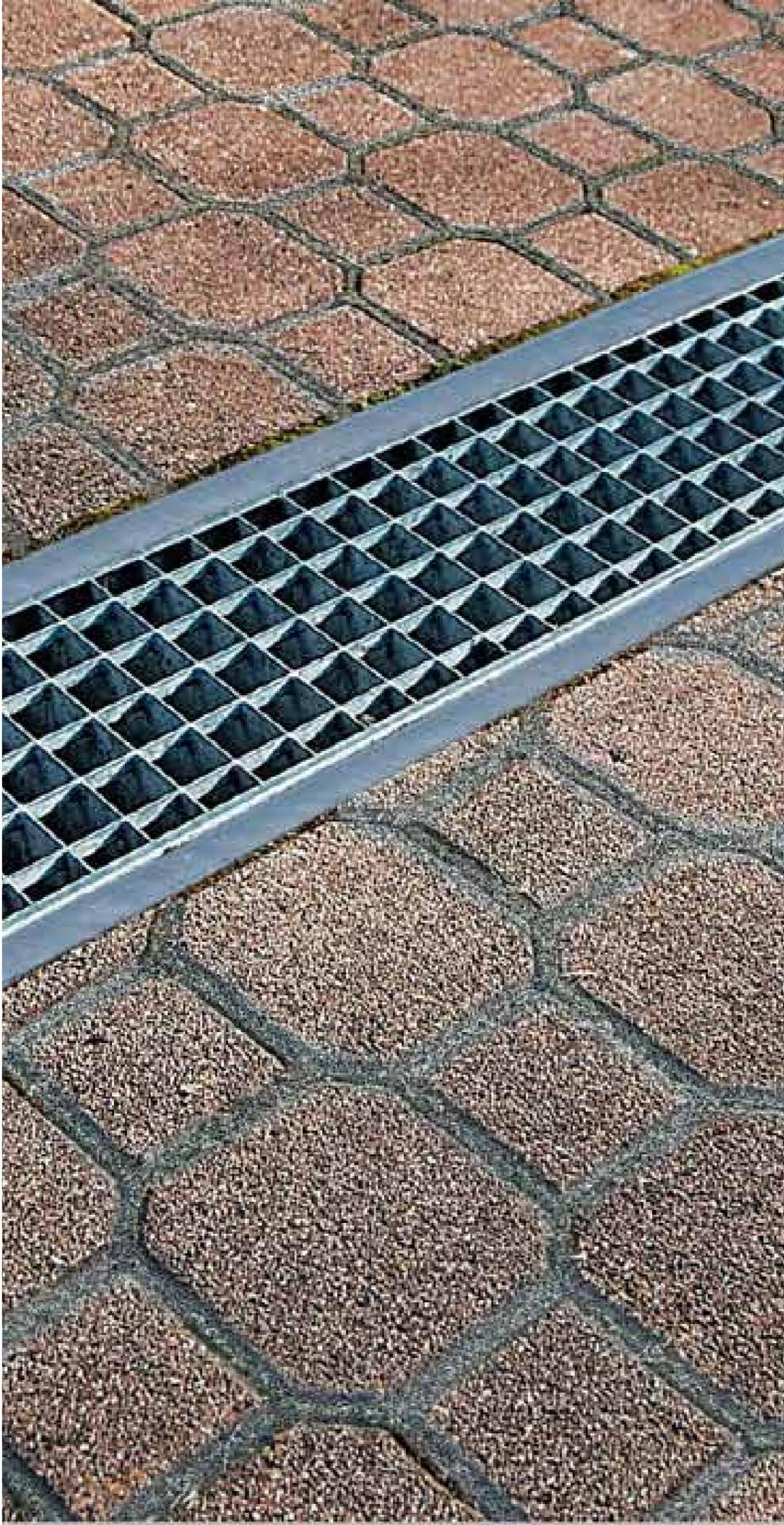
Canalette grigliate di raccolta delle acque piovane, realizzate in polimero misto calcestruzzo, larghezza 30 cm, profondità 20 cm, provviste di caditoia in ghisa sferoidale classe D400, compreso lo scavo, la posa, in rifianco ed il collegamento alla linea di raccolta.
