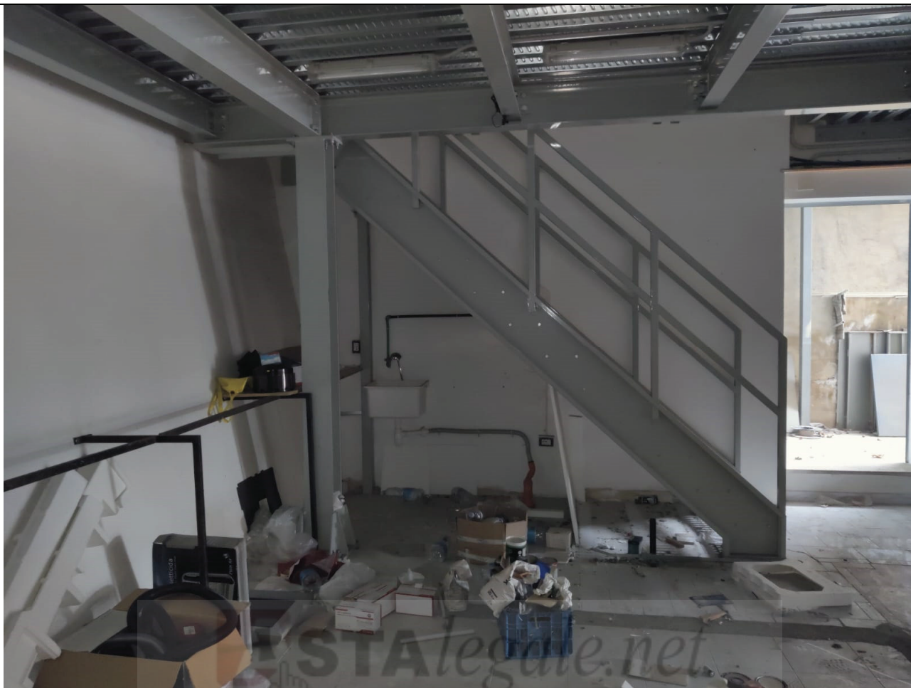
Scala di accesso al soppalco
