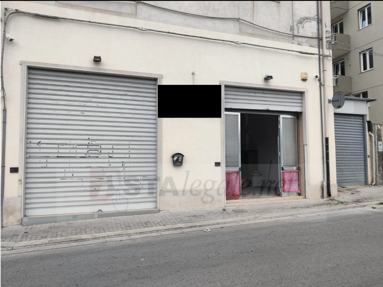
Prospetto principale su Via dei Lillà
