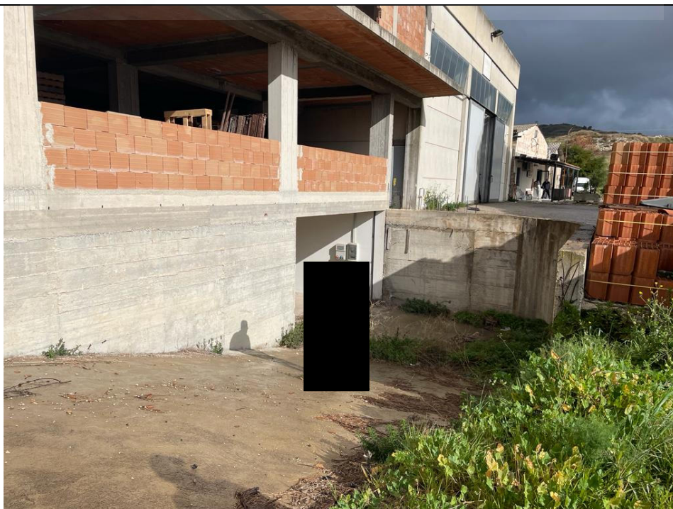
Foto 2: Rampa di accesso
