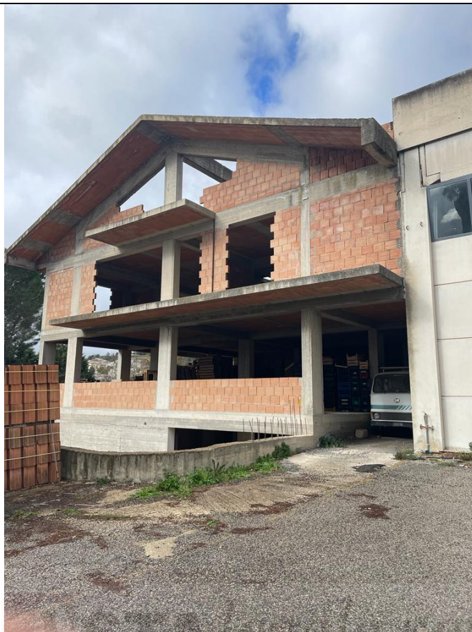
Foto 1: Immobile di cui fa parte il lotto 2
