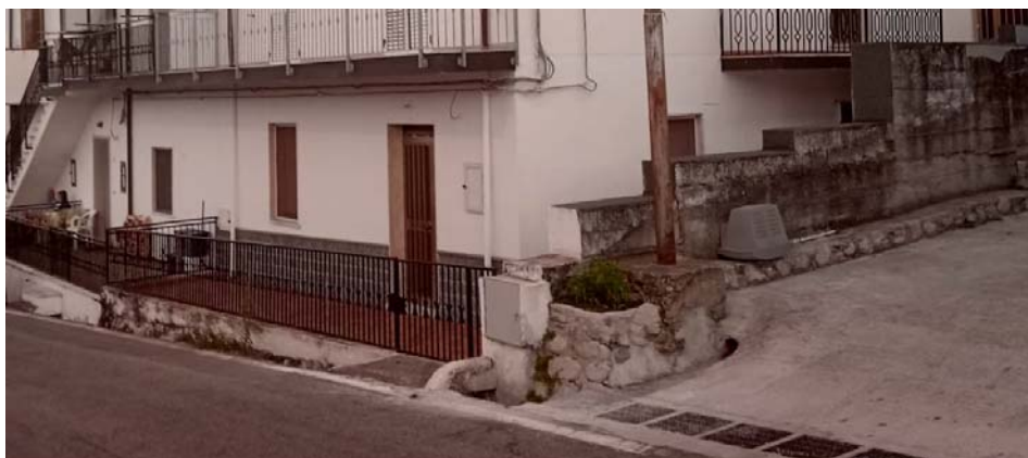
(Foto n.2_Immobile vista Via dell'Oliveto – piano Terra – sub 2)
