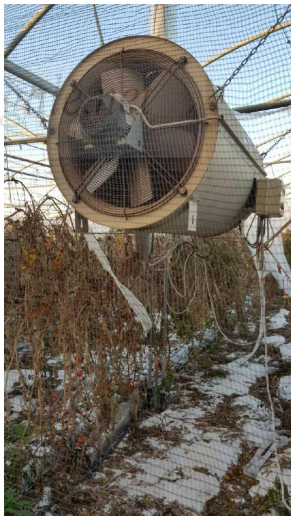
**Foto n.36 e n. 37** - generatori aria calda a gasolio per riscaldamento serre p.lle 30 e 31
