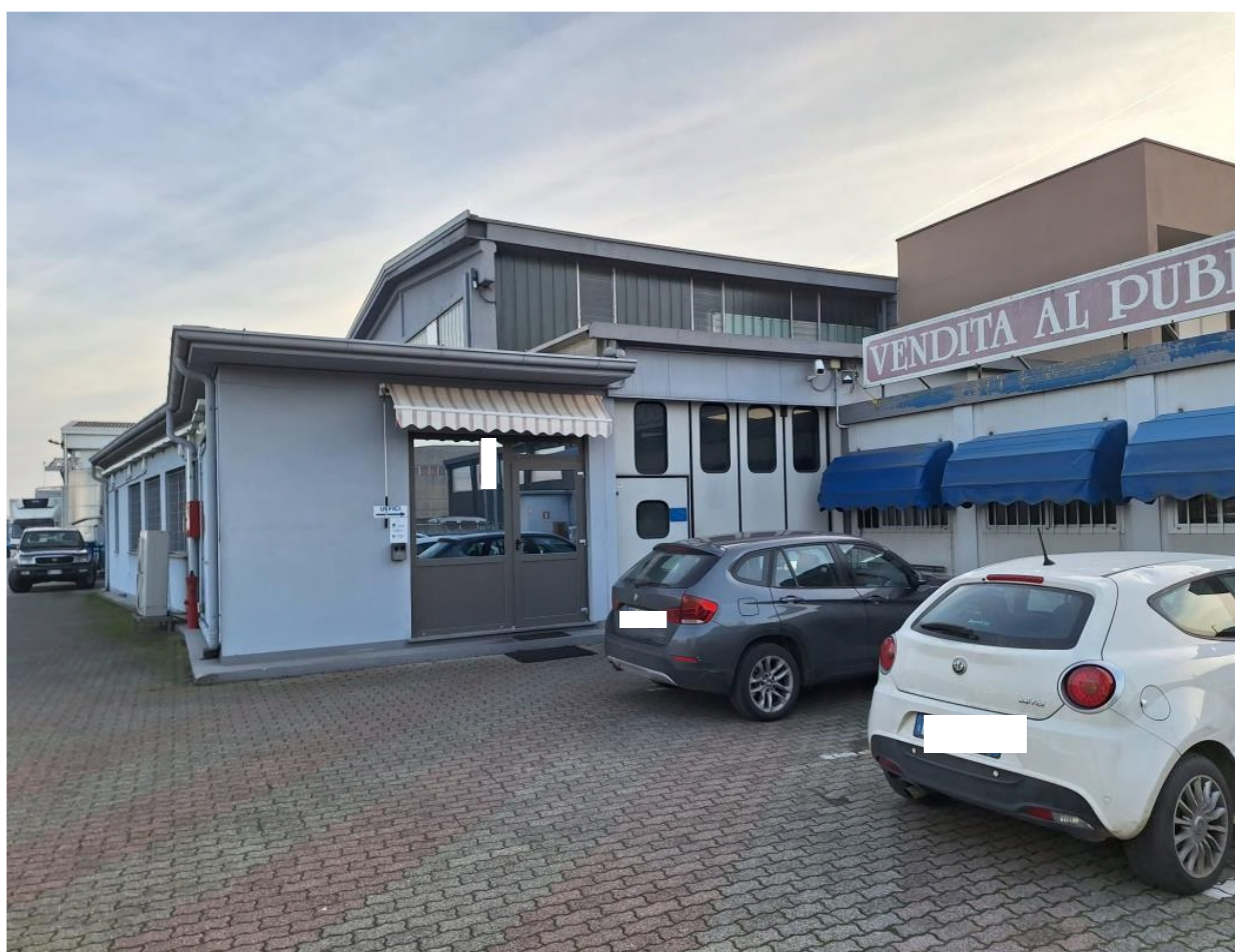
Foto 1. Ingresso principale fronte nord- ovest
