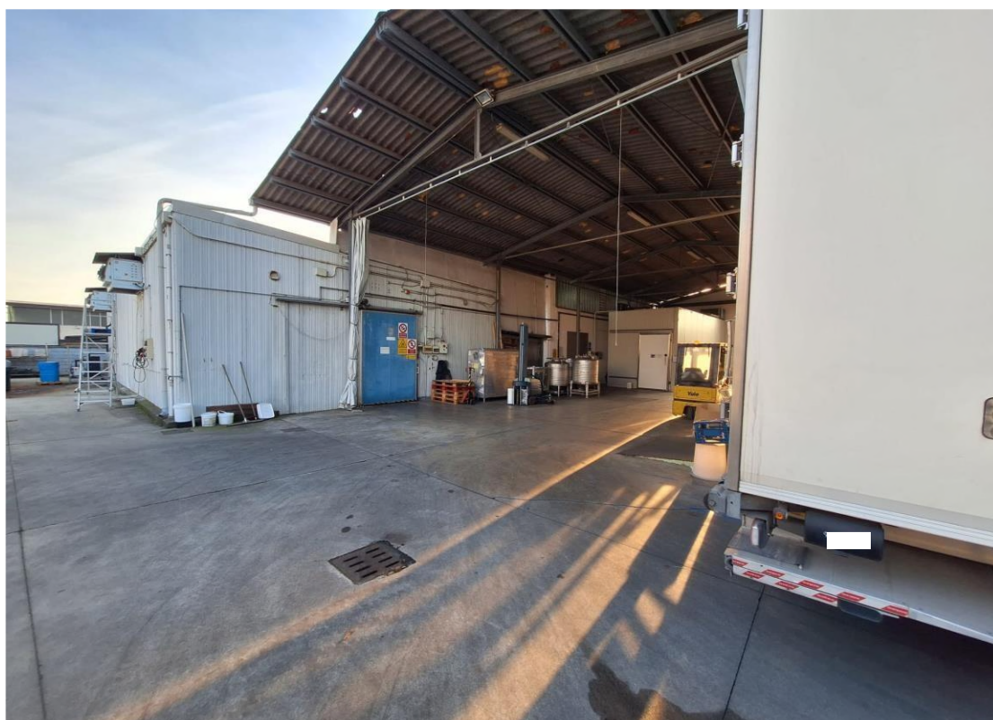
Foto 35. Fronte nord-est – tettoia 2
