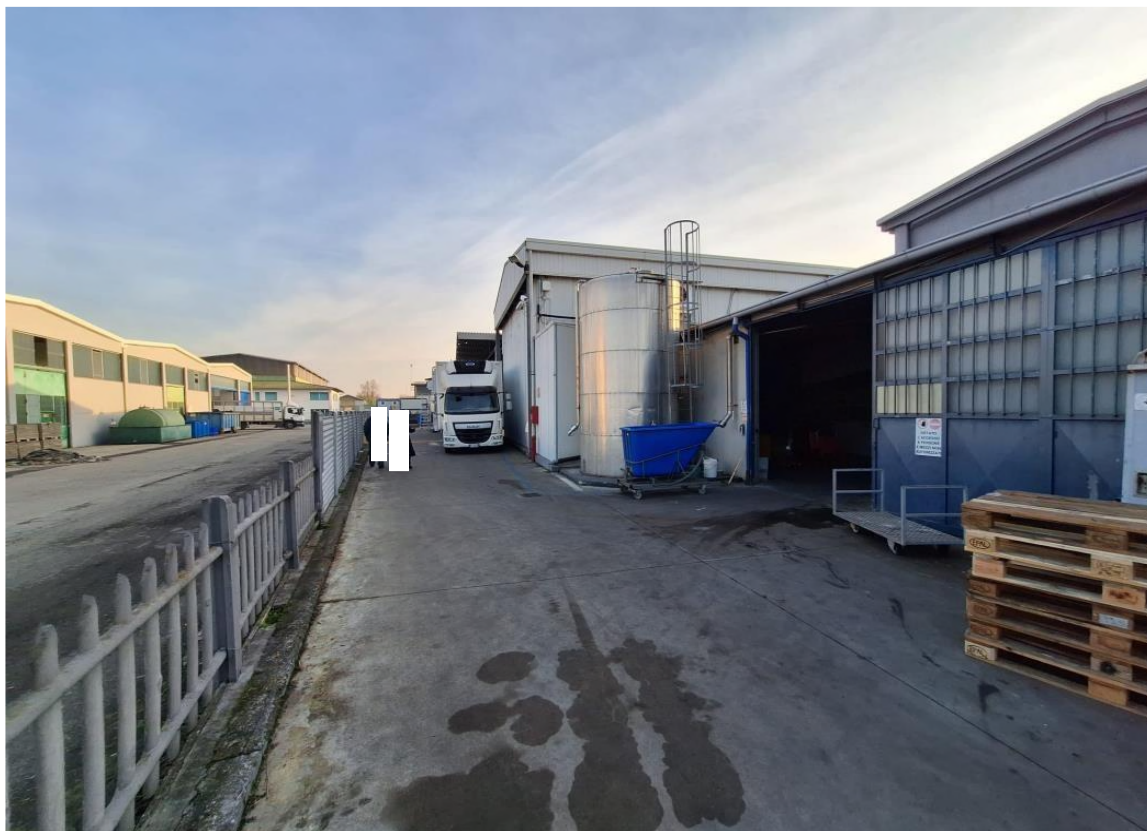
Foto 3. Fronte nord-est entrata tettoia 1
