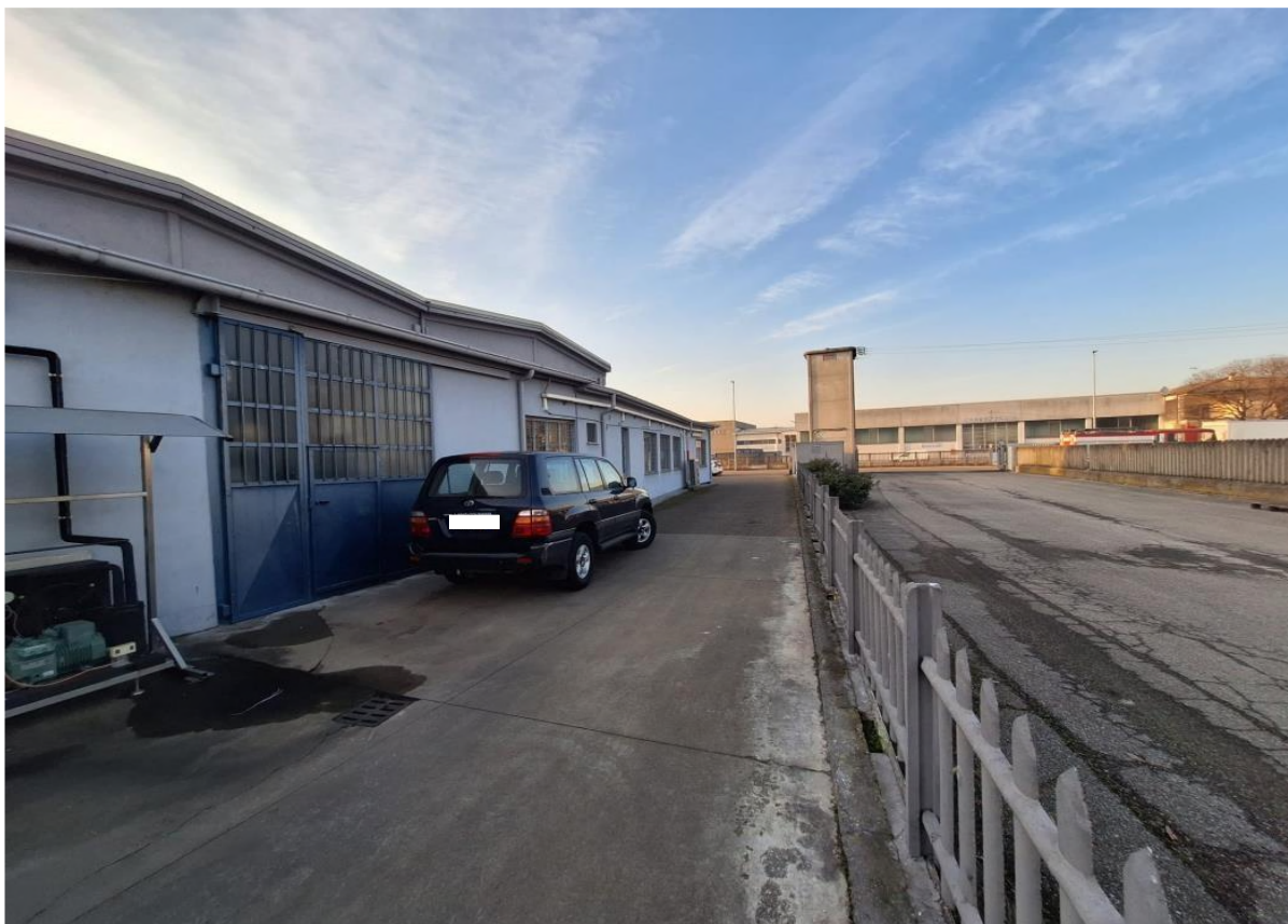
Foto 4. Fronte nord-est vista verso ingresso principale
