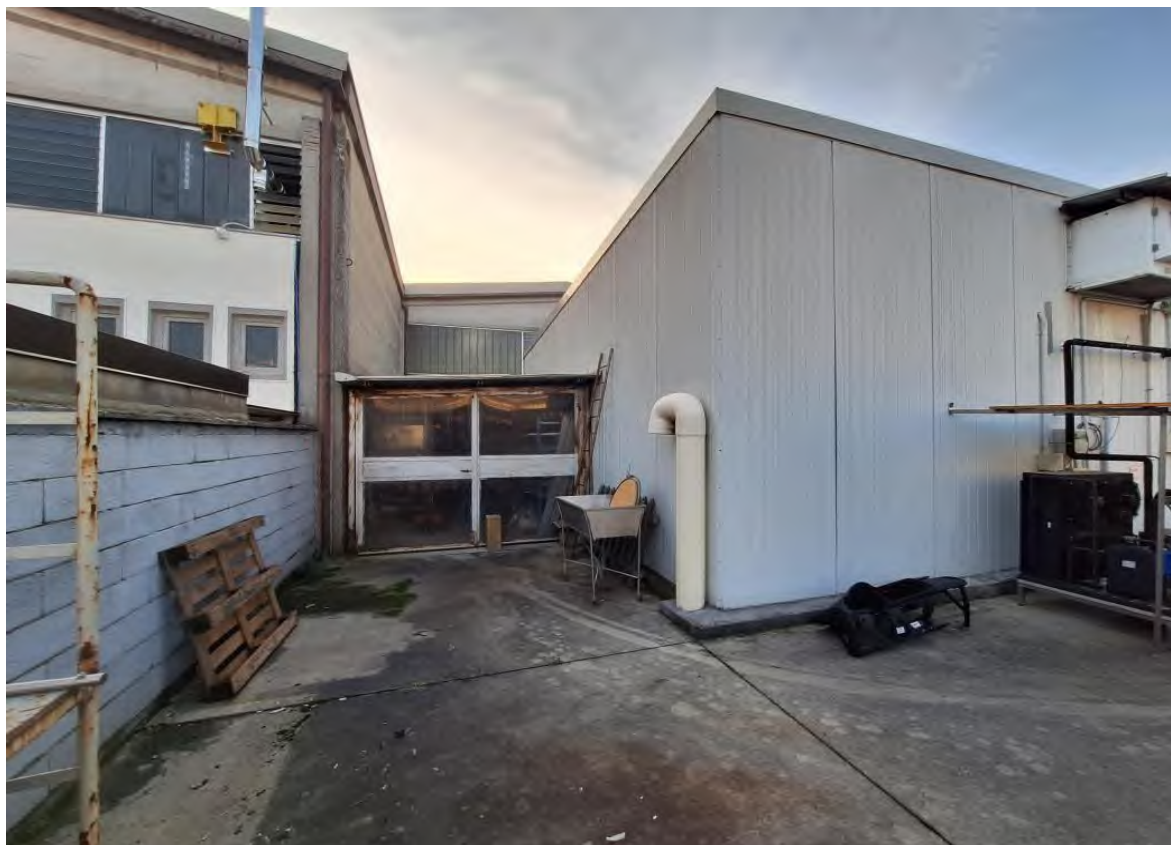
Foto 5 Fronte ingresso magazzino di fianco a cella frigorifera 5
