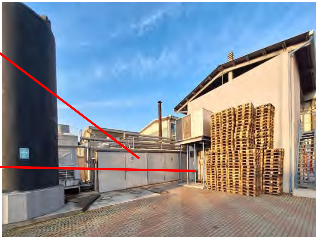
Foto 8. fronte sud- ovest Tettoia 3 + locale compressori
