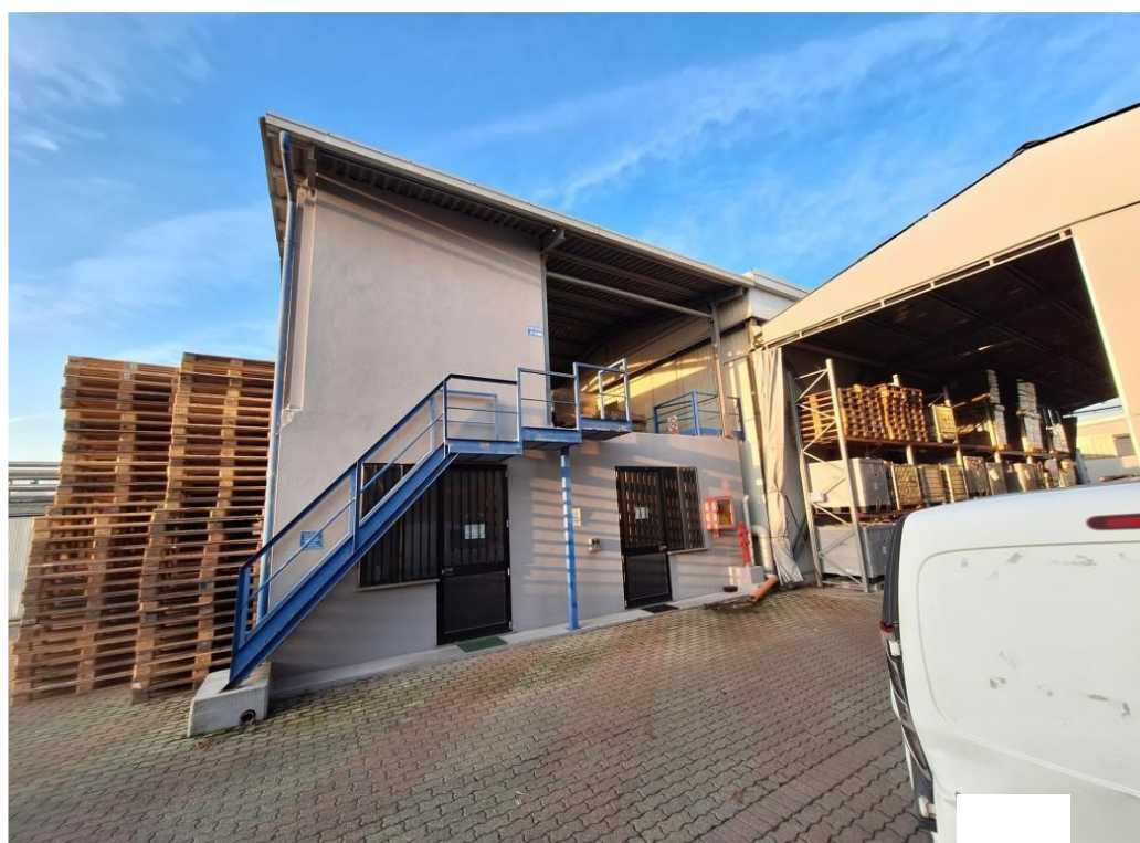
Foto 7. Prospetto fronte sud-ovest esterno spogliatoi
