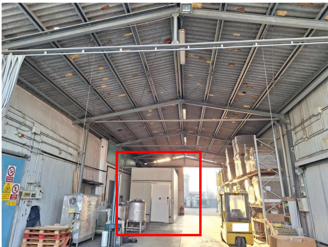
Foto 36. Interno tettoia 2 + cella frigorifera 6
