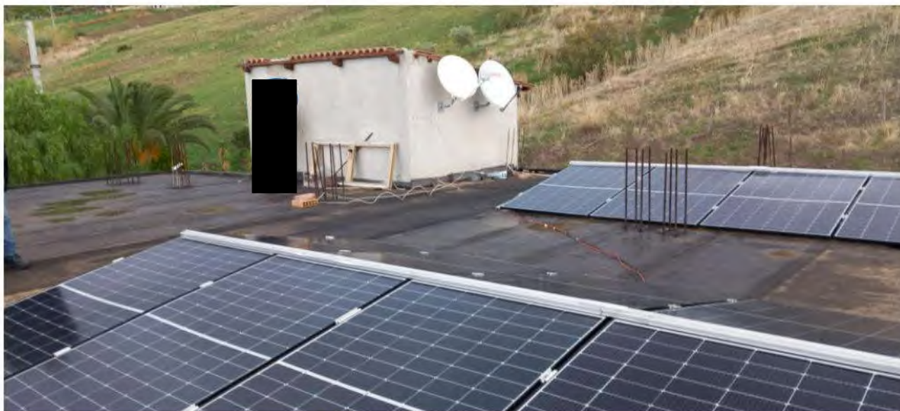
Figura 18: vista del piano primo, sub 4 (lastrico solare)
