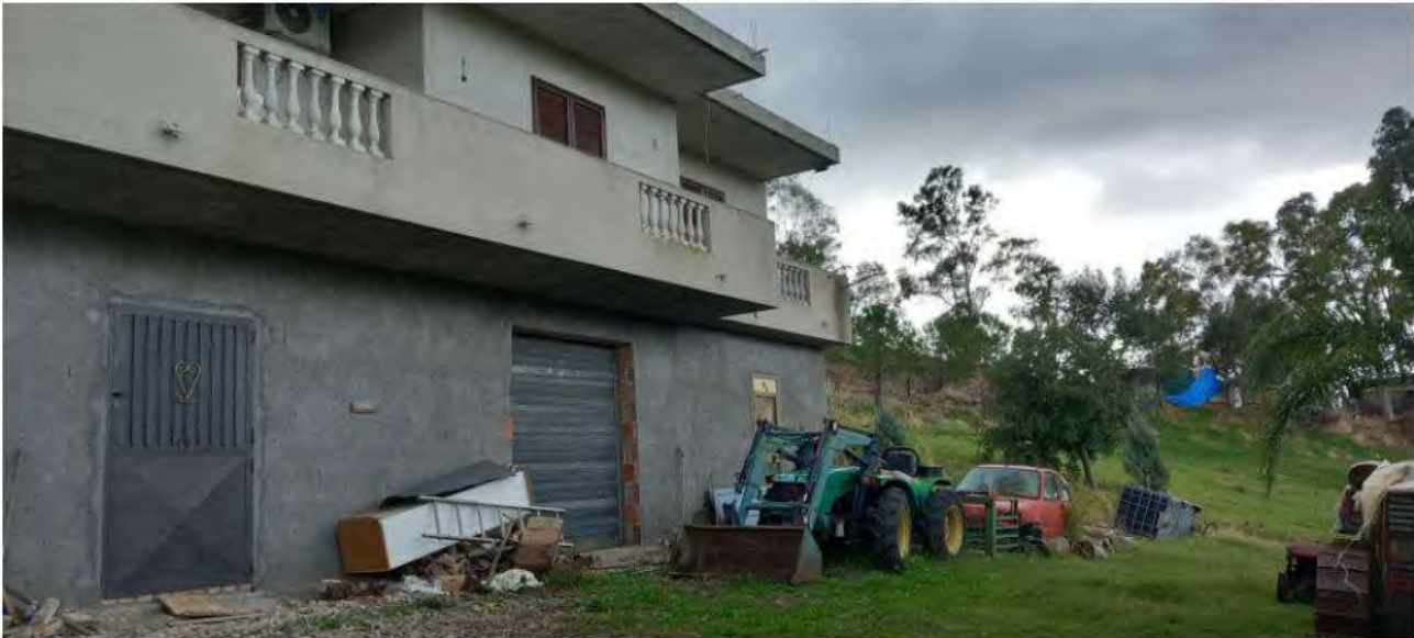
Figura 19: vista esterna del piano seminterrato (sub 3)
