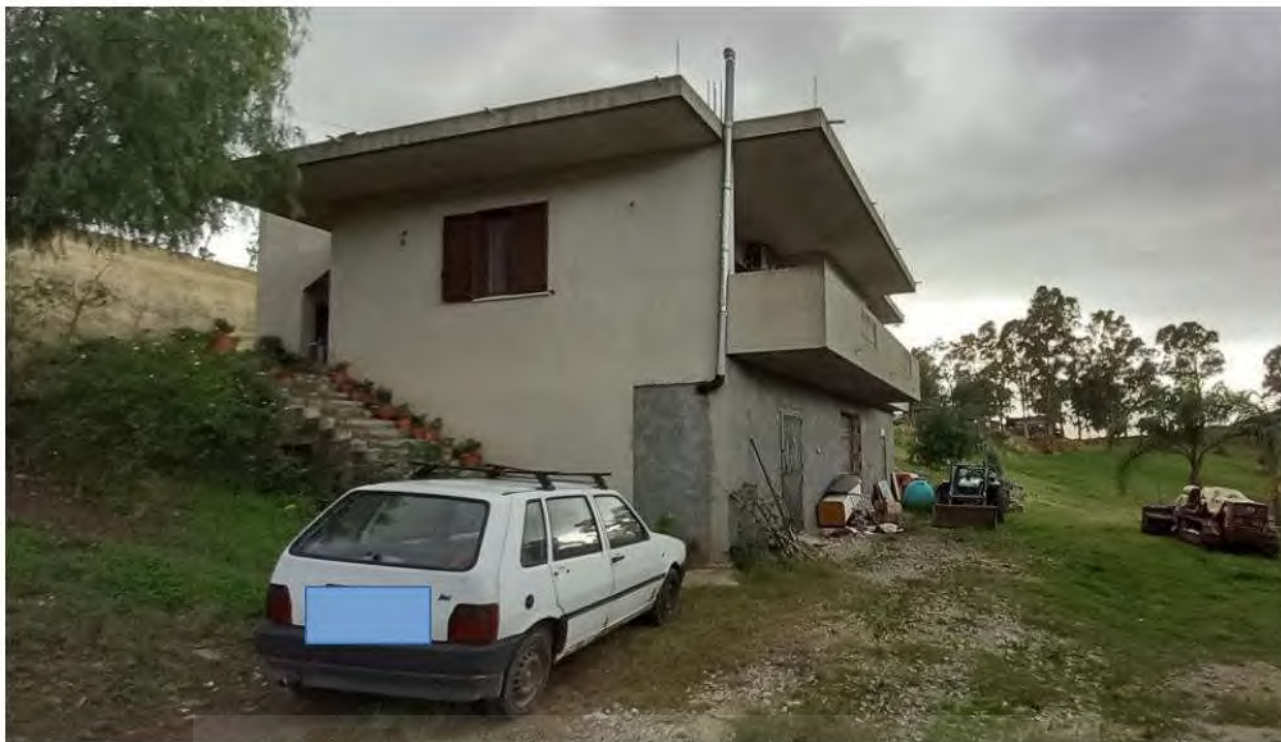
Figura 5: vista esterna del cespite lato nord - ovest
