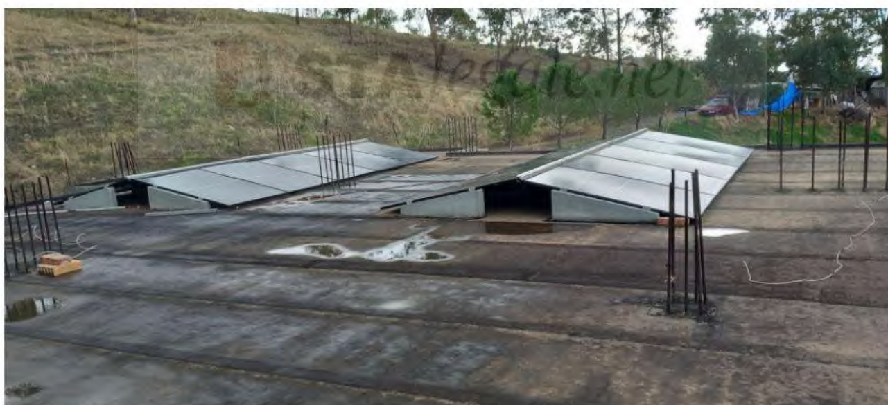
Figura 17: vista del lastrico solare, sub 4
