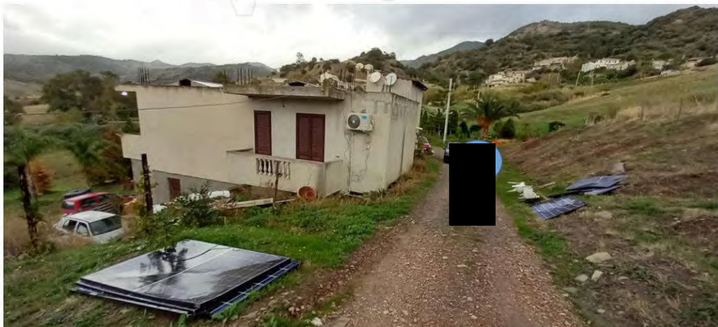
Figura 6: vista esterna del cespite lato sud - est
