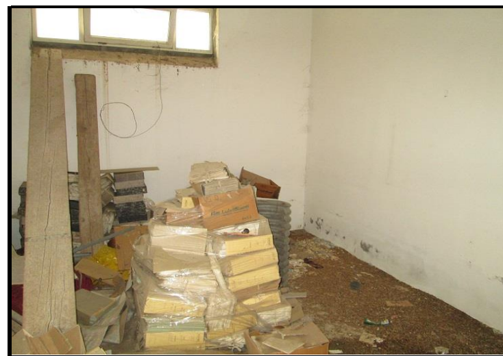
Foto n°8 - Magazzino, uffici ed abitazione Ufficio
