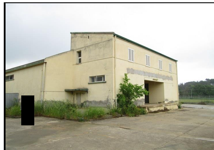
Foto n°2 - Magazzino, uffici ed abitazione Prospetto principale e laterale
