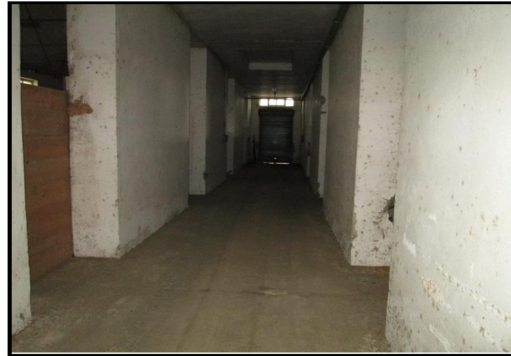
Foto n°10 - Magazzino, uffici ed abitazione Magazzino disimpegno centrale
