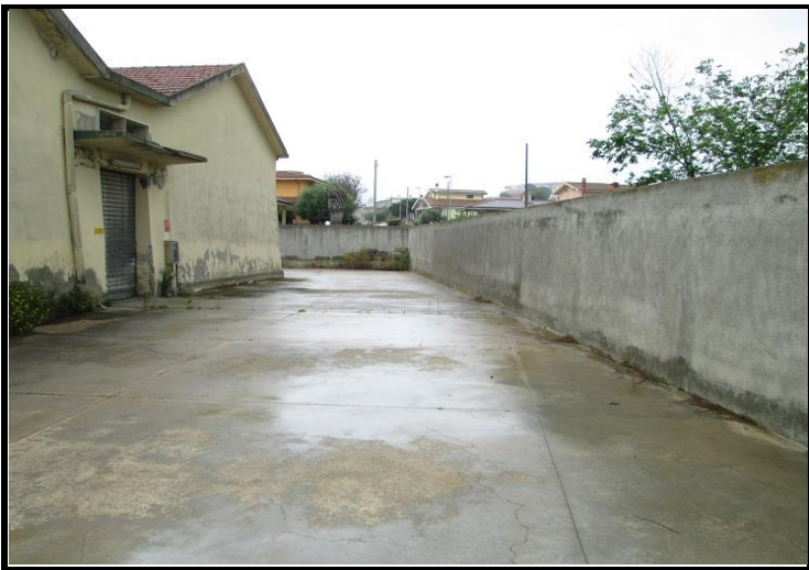
Foto n°23 - Particolare sistemazioni esterne
