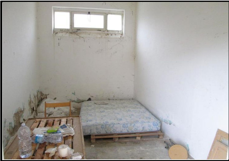
Foto n°9 - Magazzino, uffici ed abitazione Ufficio
