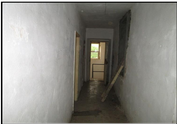
Foto n°15 - Abitazione del custode Ingresso disimpegno
