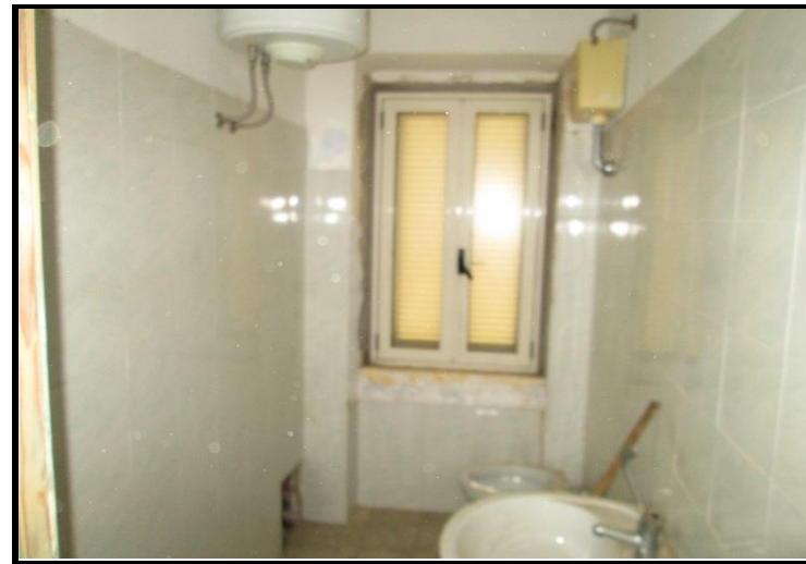
Foto n°20 - Abitazione del custode Bagno
