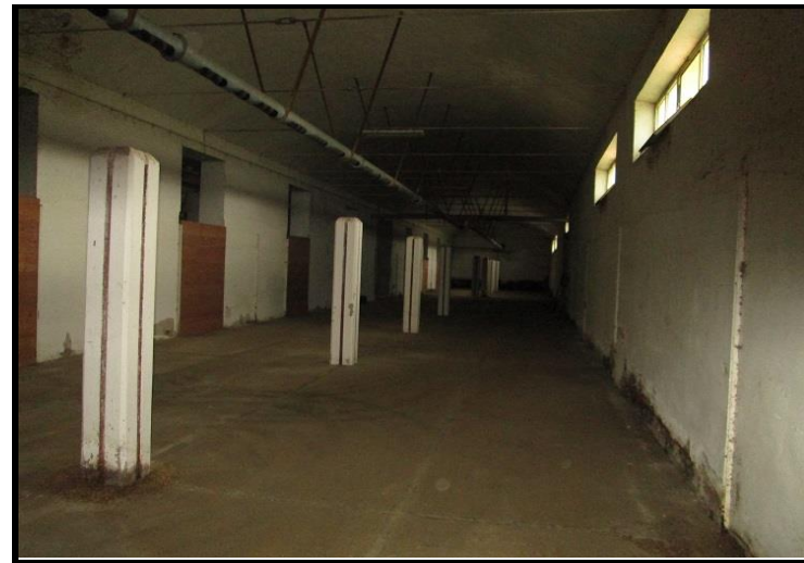
Foto n°12 - Magazzino, uffici ed abitazione Magazzino granaio
