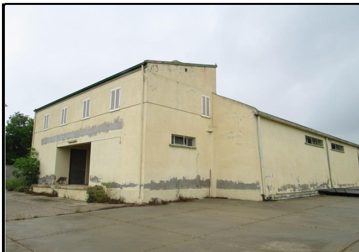
Foto n°3 - Magazzino, uffici ed abitazione Prospetto principale e laterale
