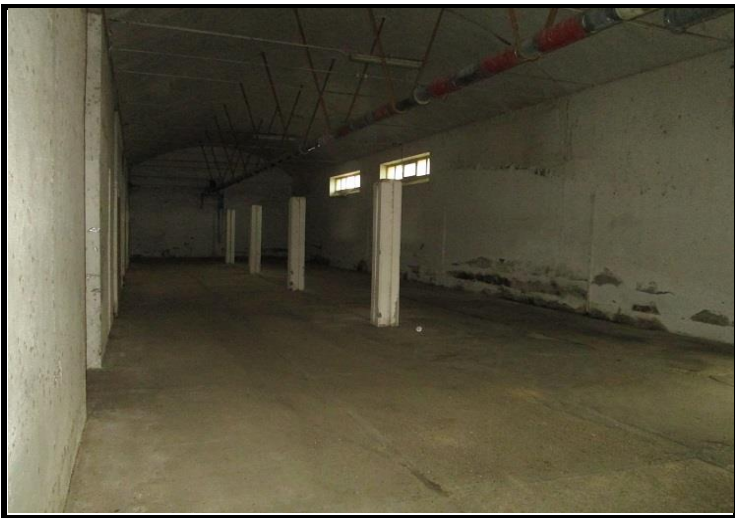
Foto n°11 - Magazzino, uffici ed abitazione Magazzino granaio
