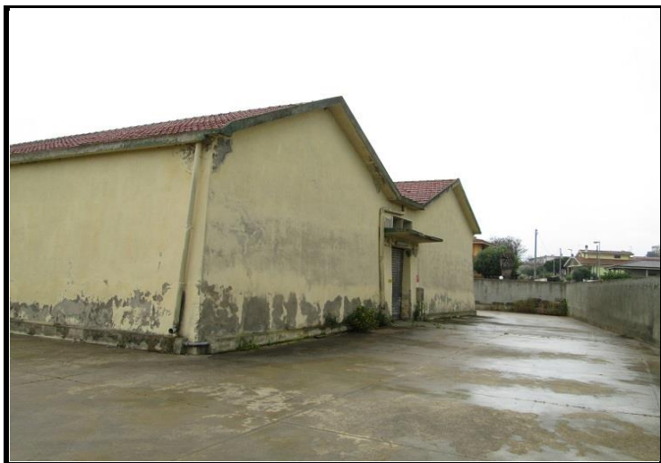
Foto n°5 - Magazzino, uffici ed abitazione Prospetto posteriore
