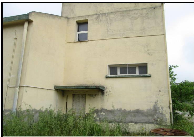
Foto n°7 - Magazzino, uffici ed abitazione Particolare ingresso abitazione
