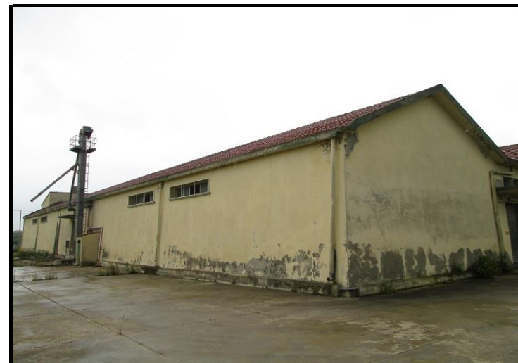
Foto n°4 - Magazzino, uffici ed abitazione Prospetto posteriore e laterale
