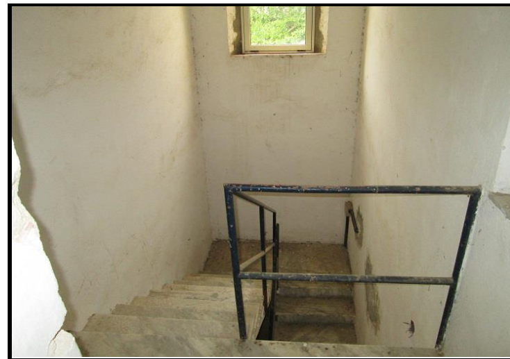
Foto n°14 - Abitazione del custode Scala d'accesso al primo piano
