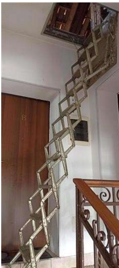
scala retrattile di accesso alla porzione di sottotetto soprastante i subalterni 716 717 e 718
