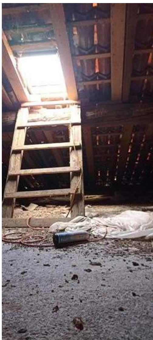
porzione di sottotetto soprastante i subalterni 716 717 e 718
