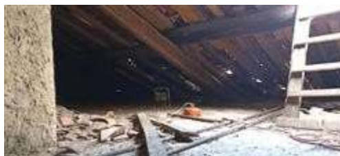
porzione di sottotetto soprastante i subalterni 716 717 e 718
