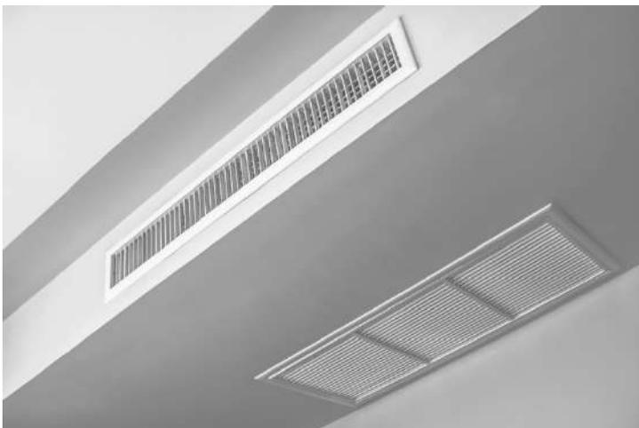
Gli appartamenti saranno dotati di un impianto di riscaldamento e raffrescamento autonomo. Ogni appartamento avrà dei ventilconvettori incassati e/o canalizzati posti nel controsoffitto delle zone di disimpegno.
