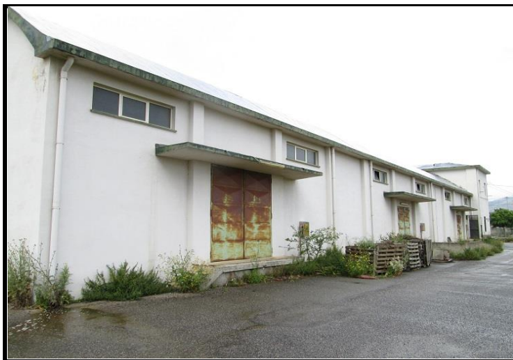
Foto n°5 - Magazzino, uffici e abitazione Prospetto laterale
