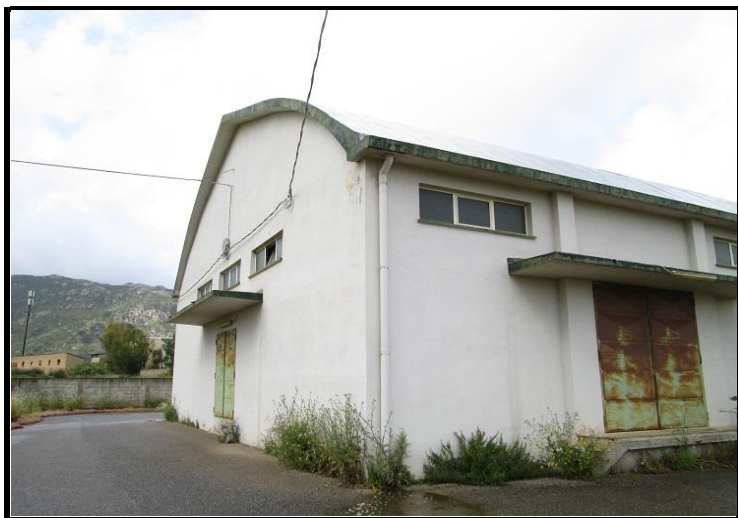
Foto n°3 - Magazzino, uffici e abitazione Prospetto posteriore
