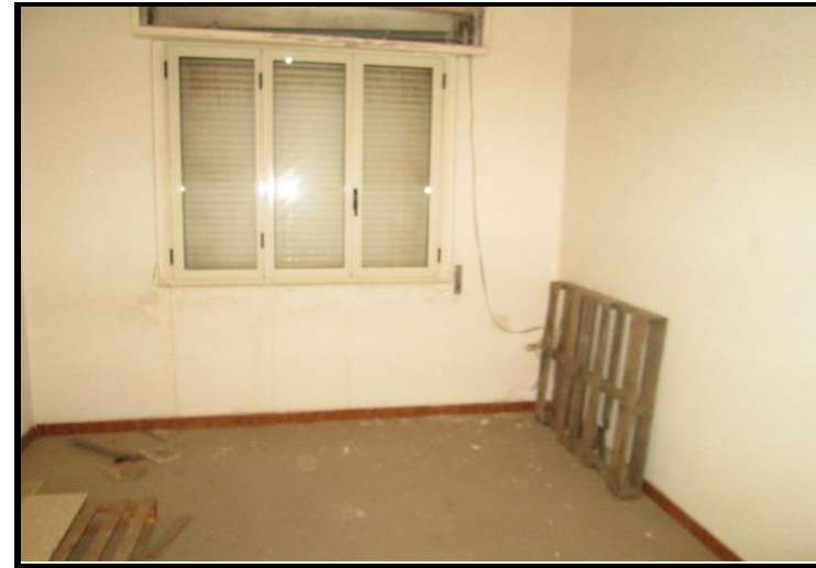
Foto n°22 - Appartamento del custode Camera
