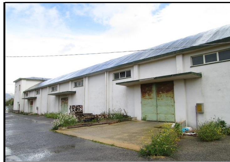
Foto n°4 - Magazzino, uffici e abitazione Prospetto laterale
