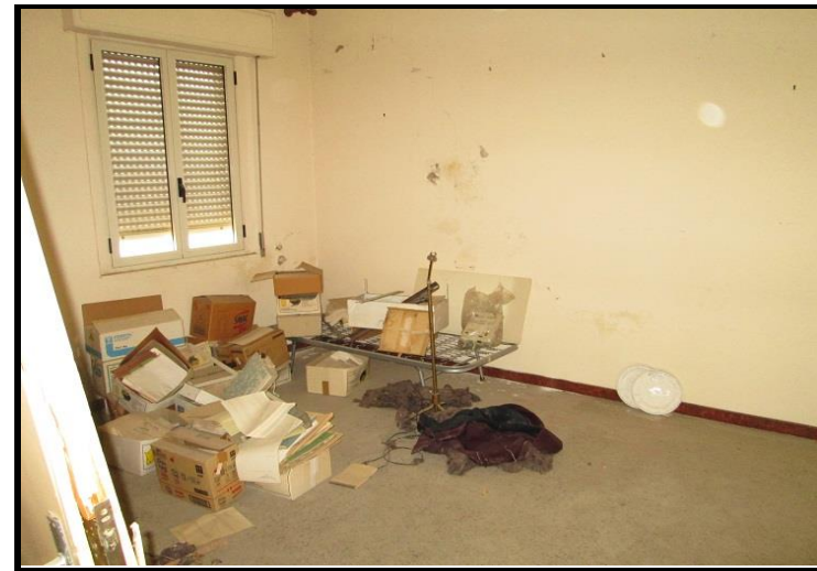
Foto n°24 - Appartamento del custode Camera
