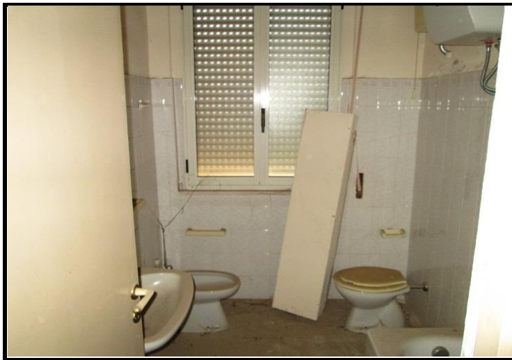
Foto n°27 - Appartamento del custode Bagno
