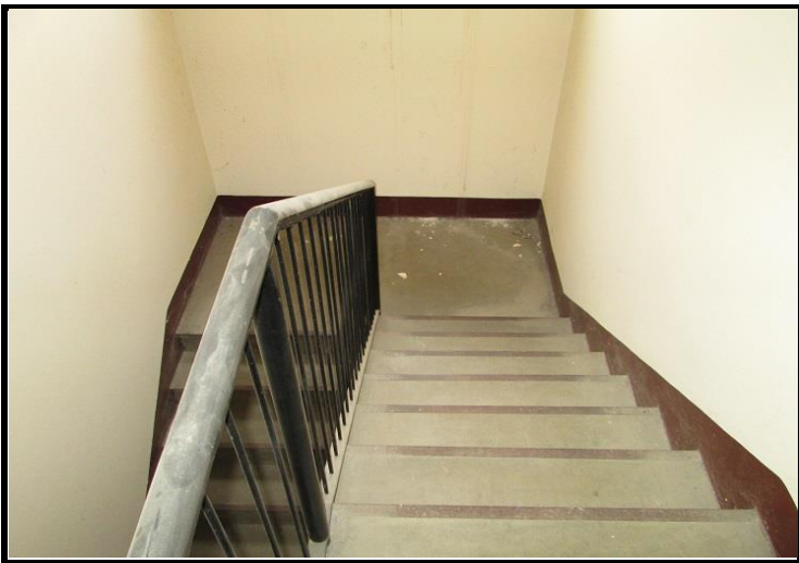
Foto n°19 - Appartamento del custode Scale d'accesso
