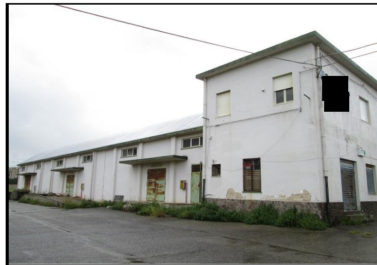
Foto n°2 - Magazzino, uffici e abitazione Prospetto laterale
