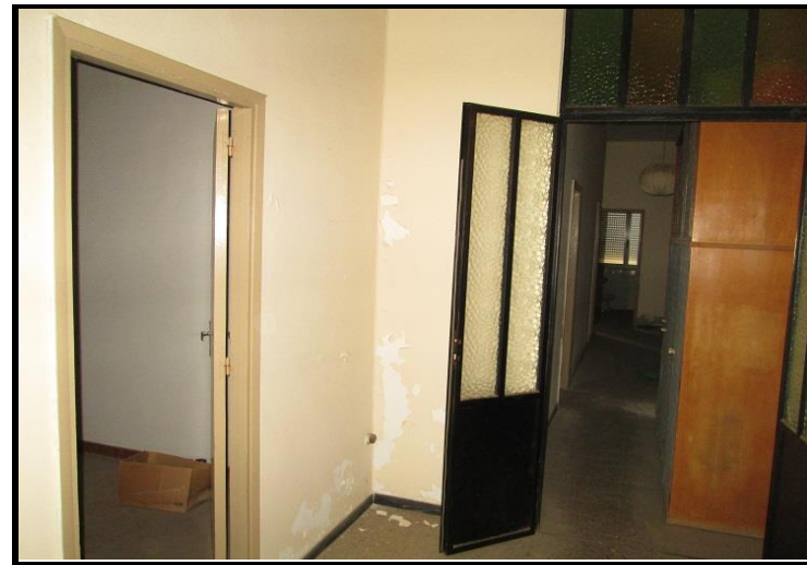
Foto n°20 - Appartamento del custode Ingresso disimpegno
