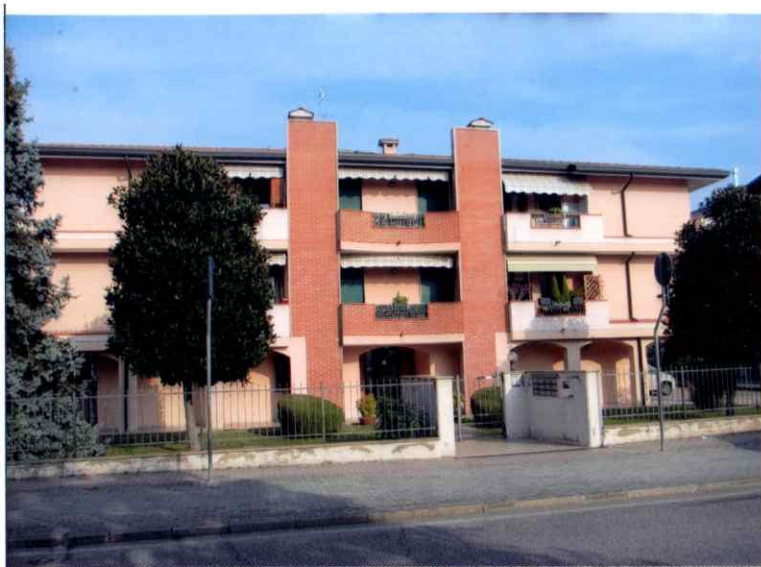
1 – Vista da SudOvest fabbricato condominiale
