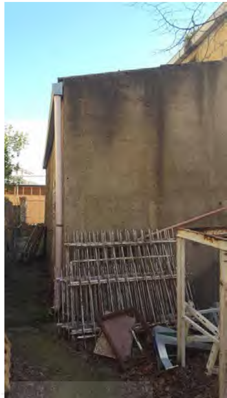
Foto N. 2: Locale Idrico da demolire Lotto L4
