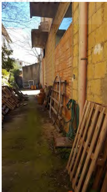
Foto N. 13: Vista laterale sinistra piano terra Lotto L1
