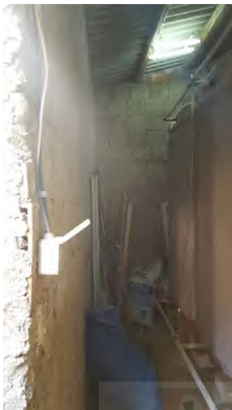
Foto N. 16: Locale idrico da demolire Lotto L4
