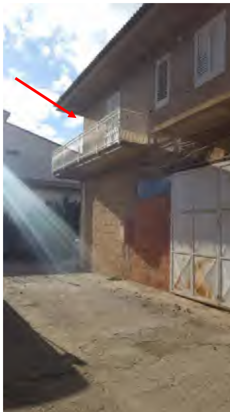
Foto N. 7: Vista Posteriore dalla Corte Comune Lotto L2
