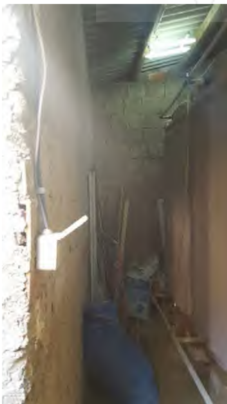
Foto N. 7: Locale idrico da demolire Lotto L4
