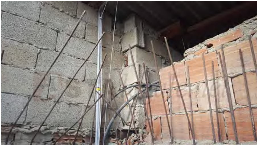
Foto N. 30: Sottotetto. Lotto L3
