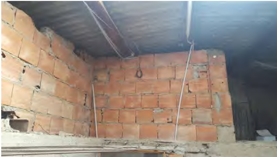
Foto N. 29: Sottotetto. Lotto L3
