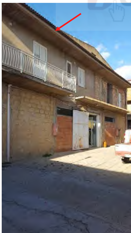
Foto N. 8: Vista Posteriore Dalla Corte comune Lotto L2
