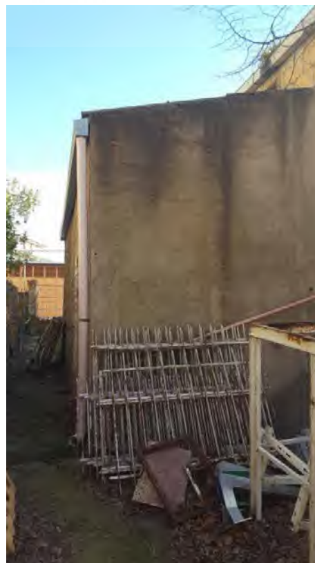
Foto N. 12: Locale Idrico da demolire Lotto L4
