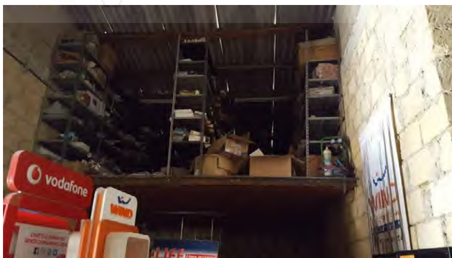
Foto N. 34: Interno del magazzino e controsoffitto Lotto L4
