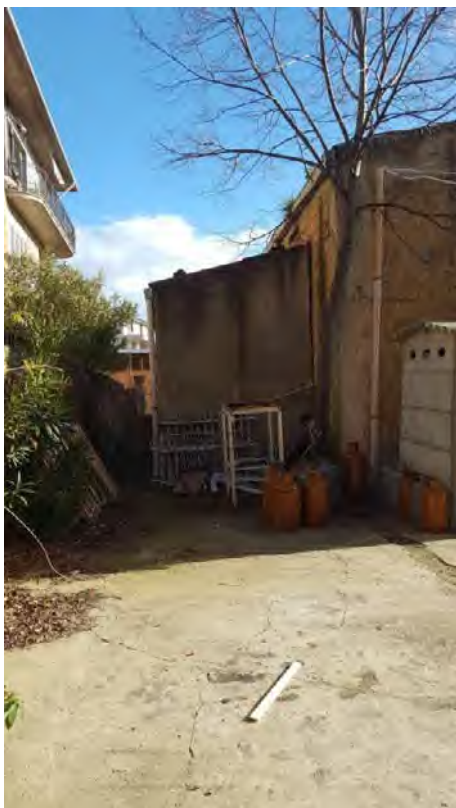
Foto N. 13: Locale Idrico da demolire Lotto L4
