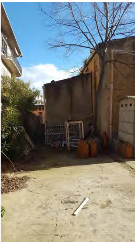
Foto N. 3: Locale Idrico da demolire Lotto L4
