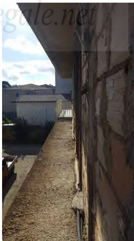
Foto N. 9: Vista Del Balcone Posteriore- Lotto L3
