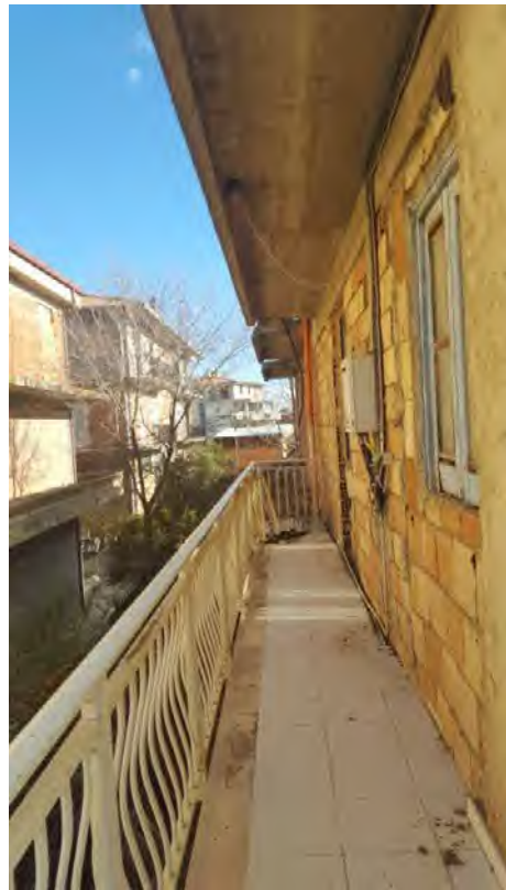
Foto N. 11: Vista Del Balcone Posteriore- Lotto L3
