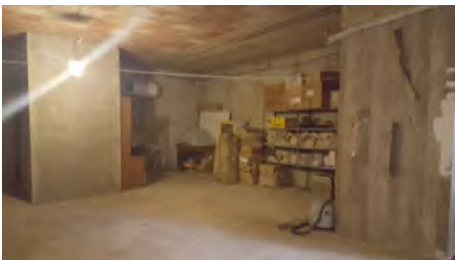
Foto N. 25: Vano n. 2. Piano Primo Lotto L3
