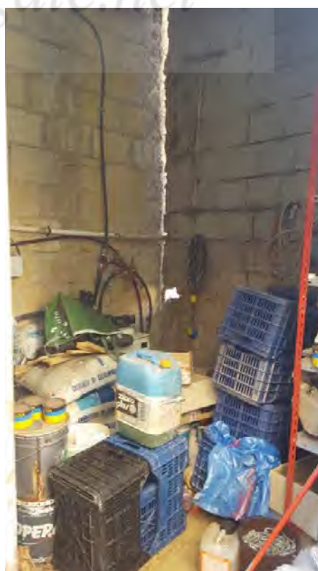
Foto N. 15: Parete in laterizio sconnessa del locale idrico da demolire Lotto L4
