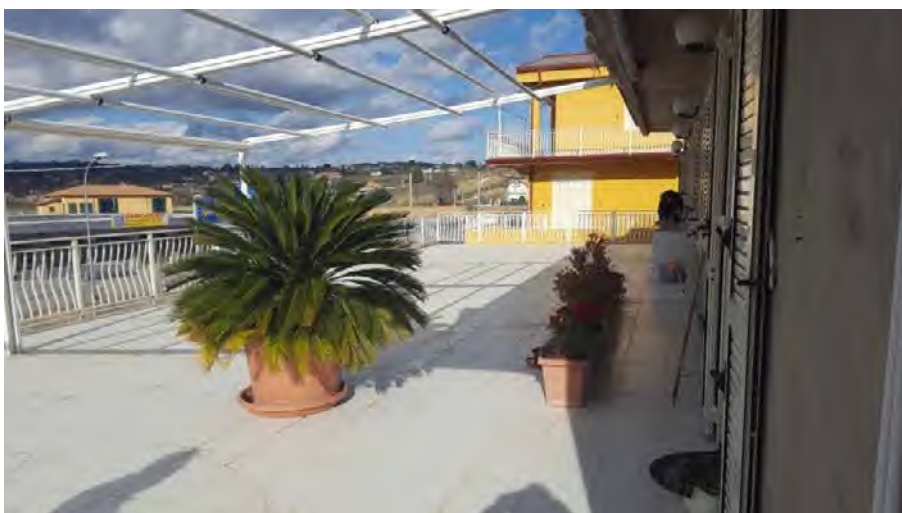
Foto N. 12: Vista Del Terrazzo- Lotto L2
