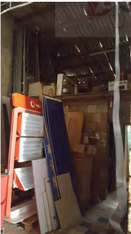
Foto N. 26: Interno del magazzino e controsoffitto Lotto L4
