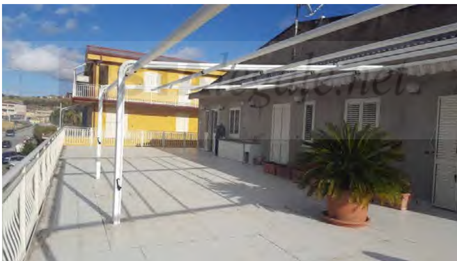
Foto N. 11: Vista Del Terrazzo- Lotto L2
