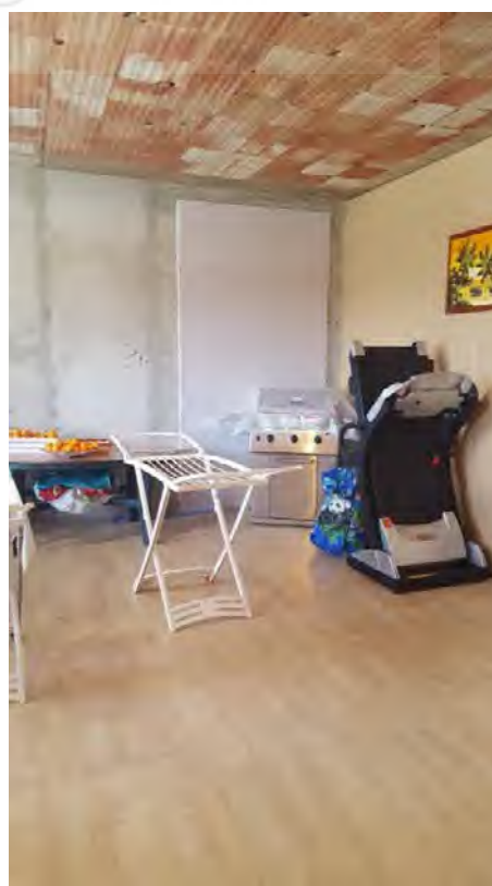
Foto N. 17: Vano n. 1. Piano Primo Lotto L3
