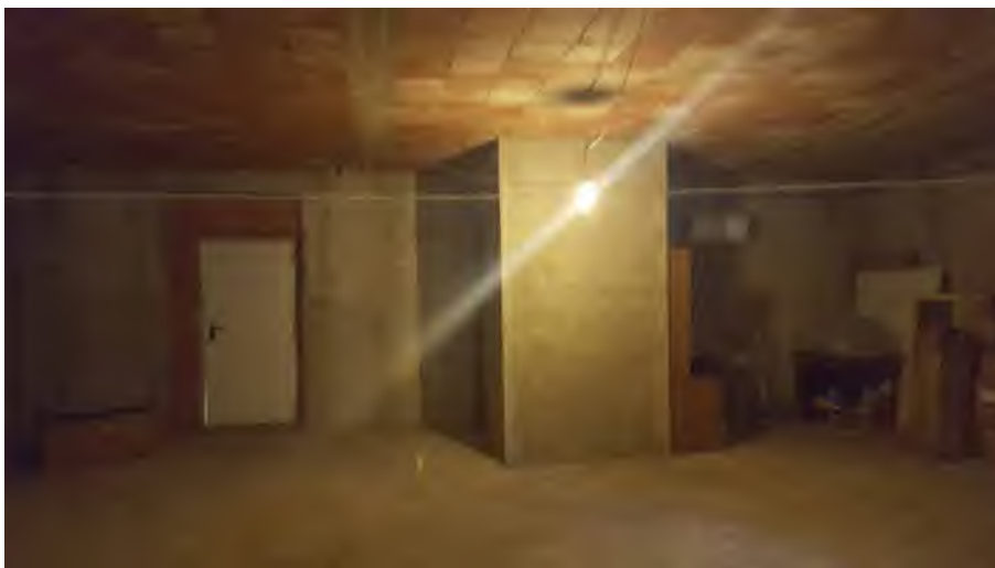
Foto N. 26: Vano n. 2. Piano Primo Lotto L3
