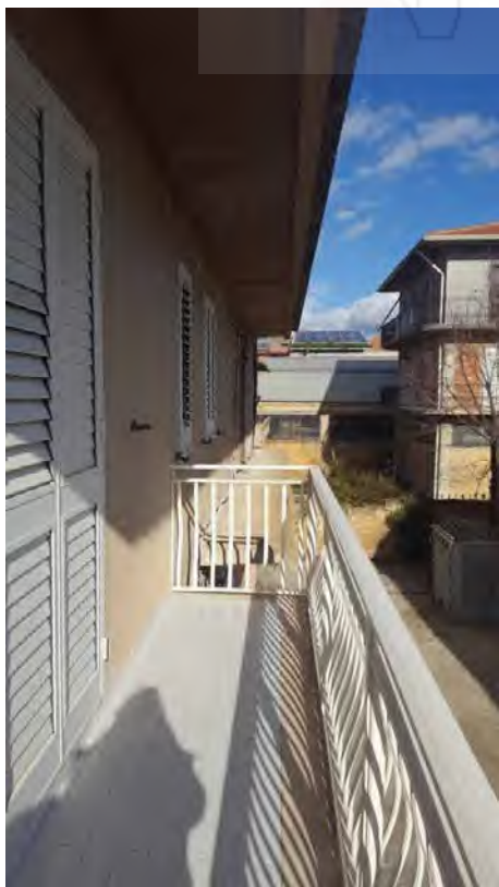
Foto N. 15: Vista Balcone dal Terrazzo- Lotto L2
