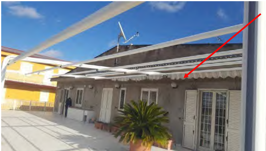
Foto N. 10: Vista Del Terrazzo- Lotto L2
