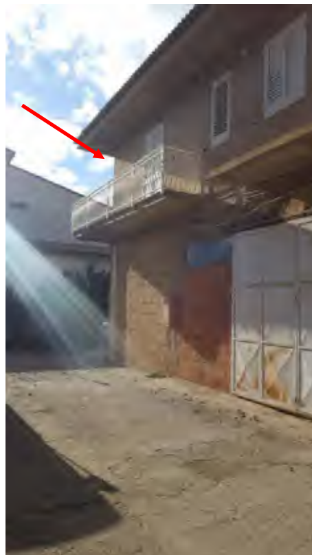
Foto N. 7: Vista Posteriore dalla Corte Comune Lotto L2
