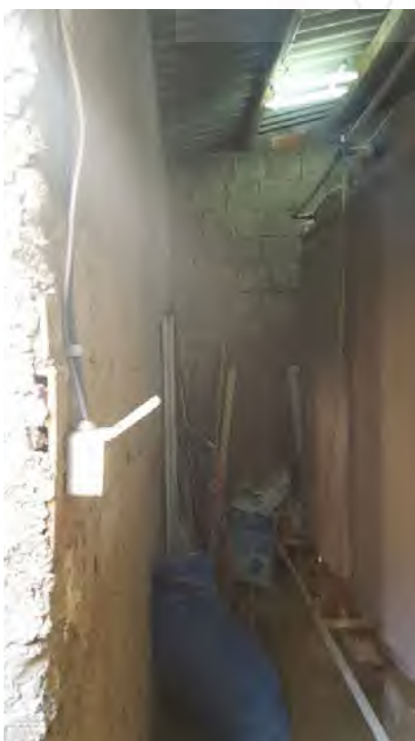
Foto N. 7: Locale idrico da demolire Lotto L4
