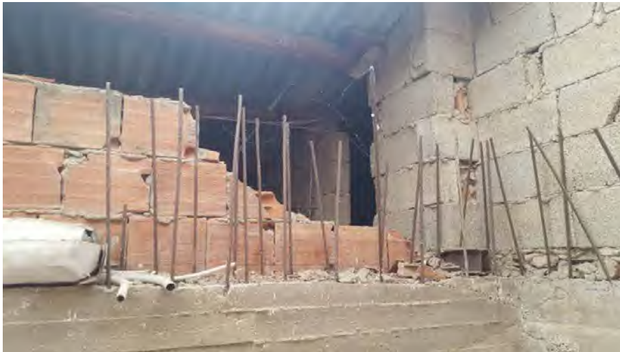
Foto N. 32: Sottotetto. Lotto L3
