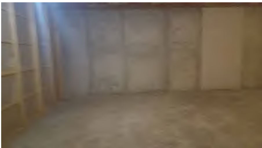
Foto N. 22: Vano n. 2. Piano Primo Lotto L3
