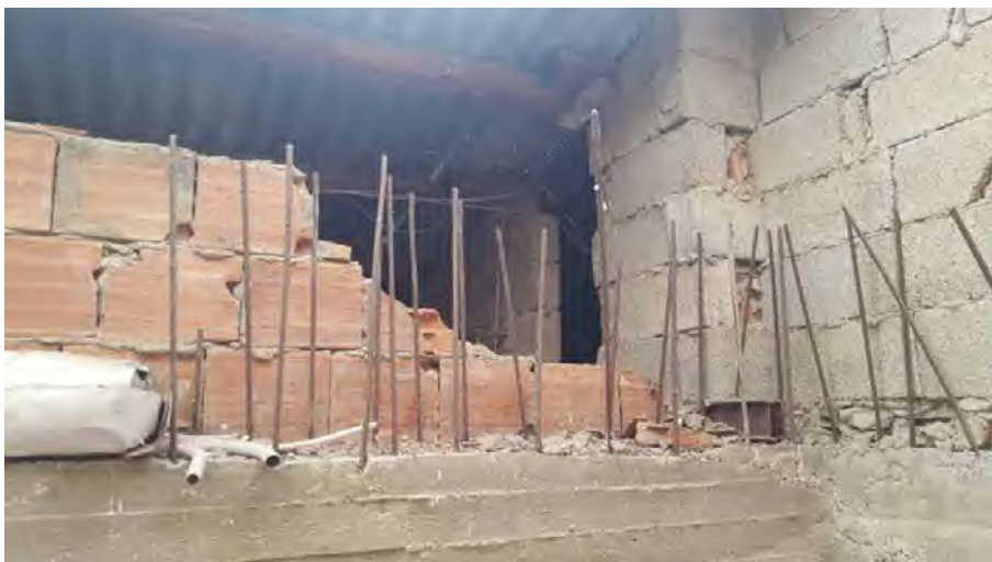
Foto N. 31: Sottotetto. Lotto L3
