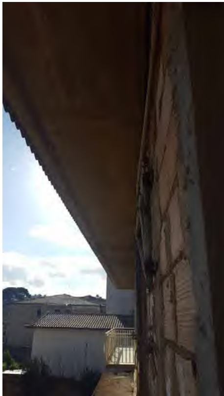
Foto N. 10: Vista Del Balcone Posteriore- Lotto L3
