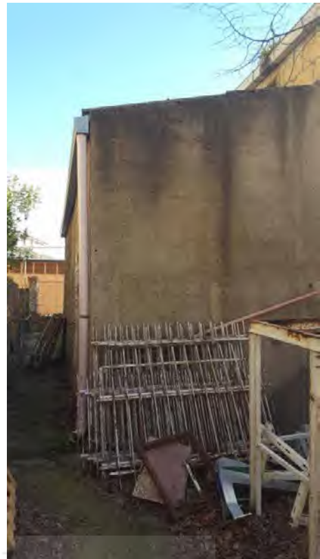
Foto N. 2: Locale Idrico da demolire Lotto L4
