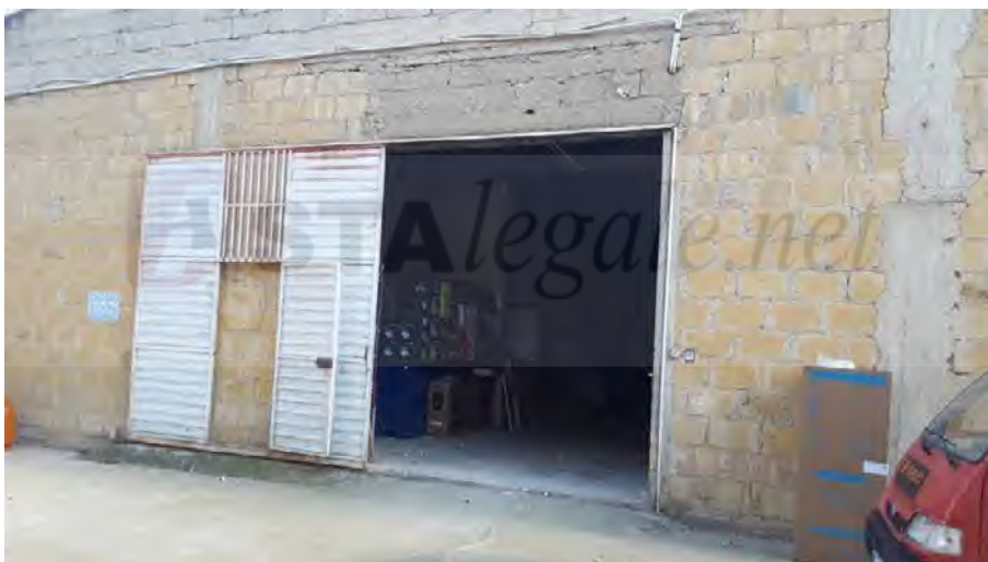
Foto N. 8: Ingresso dalla corte interna al lotto L4
