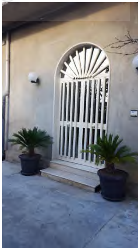
Foto N. 16: Ingresso Dalla Corte Lotto L2
