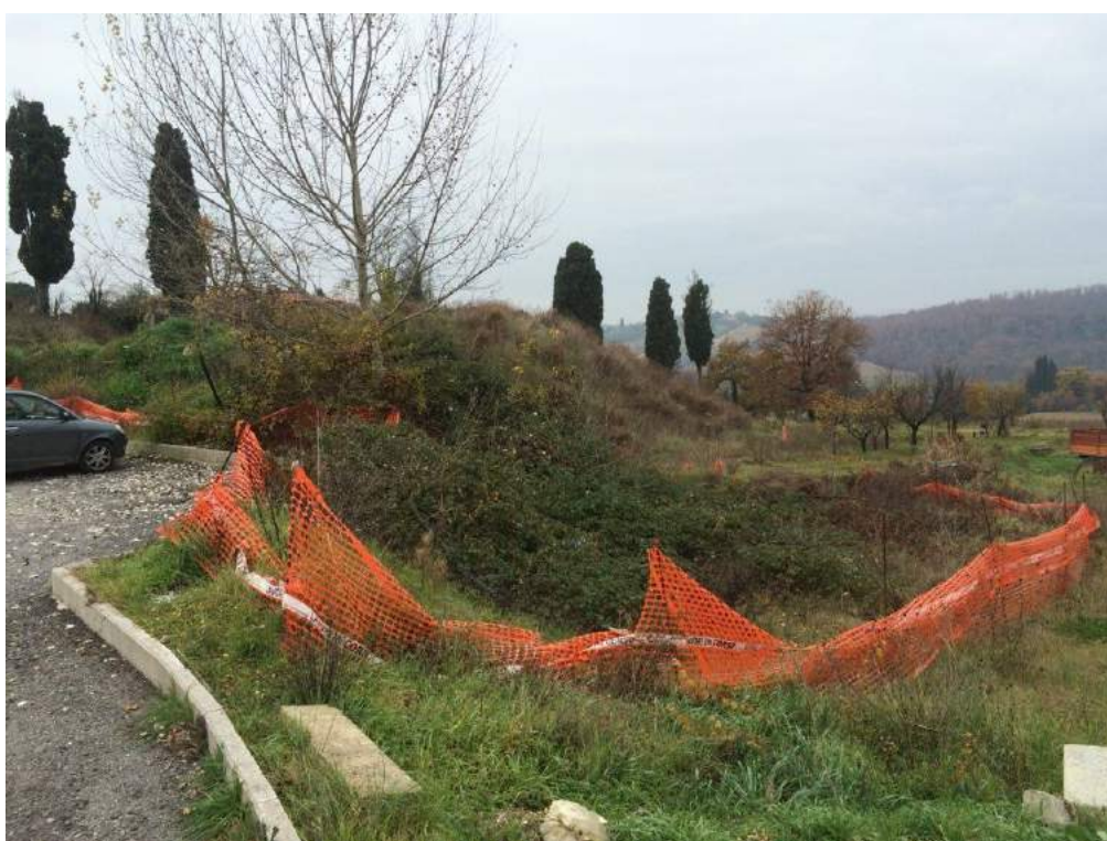
AREA DI CANTIERE
