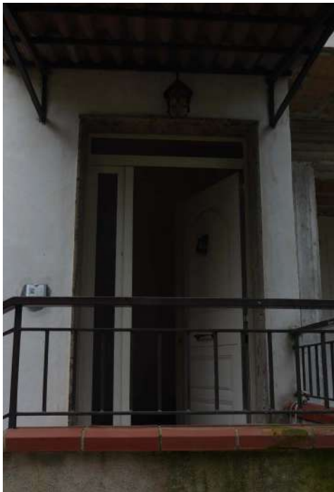
Foto Esterno 2. Fg 29 P.Ila 276 Ingresso Esterno al Sub 11
