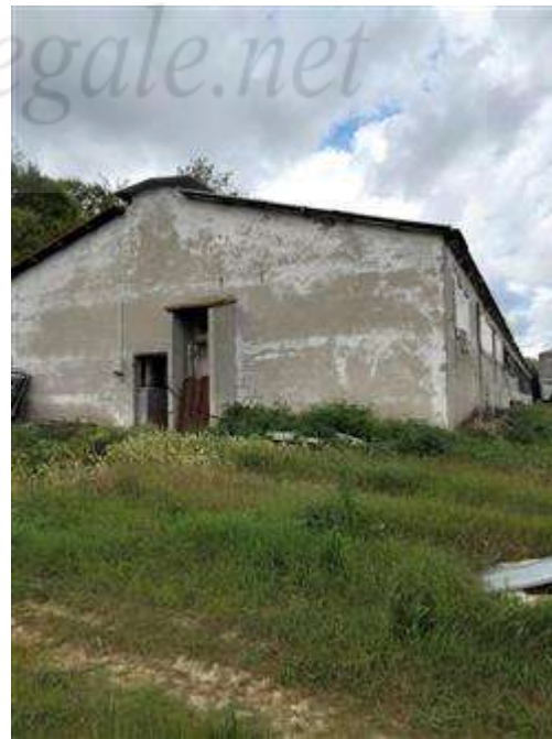
CAPANNONE n° 2 ESTERNO
