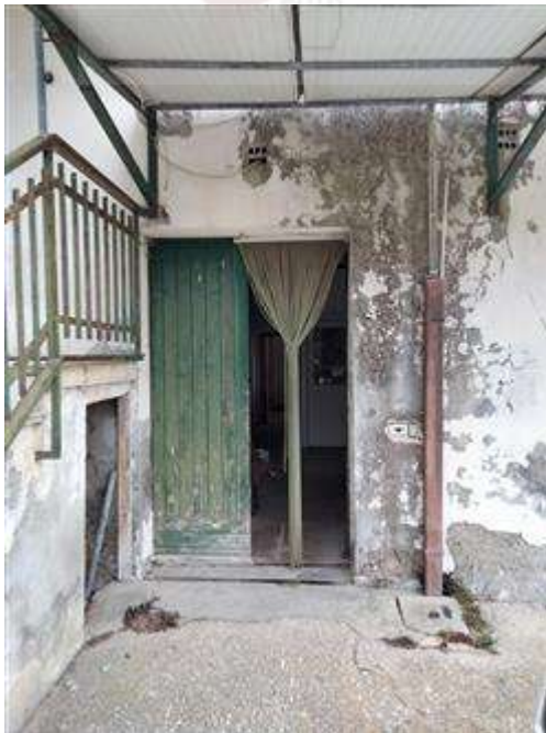
INGRESSO PIANO TERRA UFFICI
