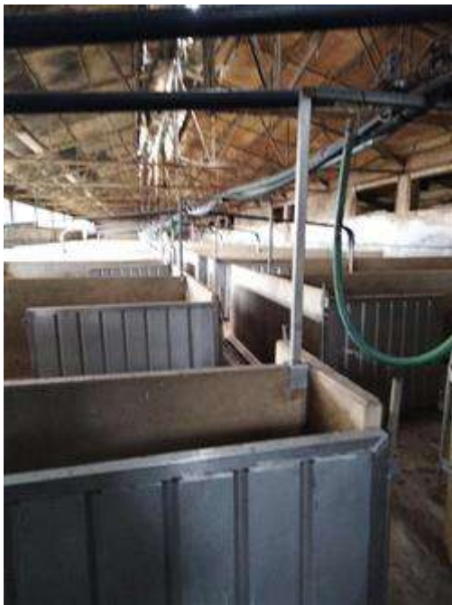
CAPANNONE n° 3 INTERNO
