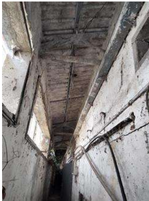
CAPANNONE n°3 INTERNO
