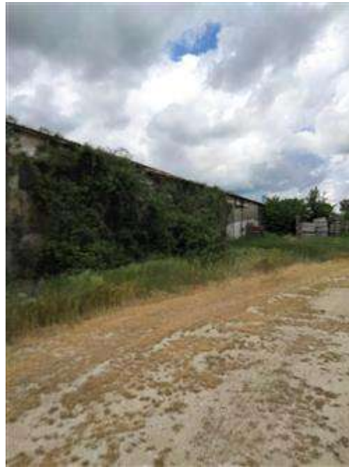
CAPANNONE n° 3 ESTERNO
