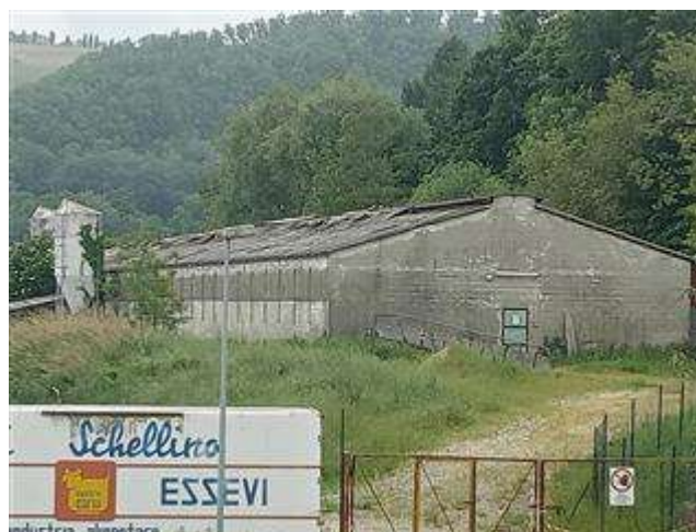
COPERTURA VISTA ESTERNA
