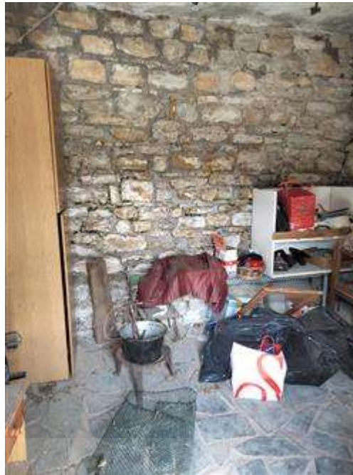
INTERNO RIMESSA ATTREZZI n°6 (A)
