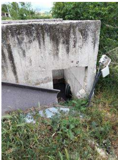
POZZETTO RACCOLTA LINEE REFLUI DEI TRE CAPANNONI
