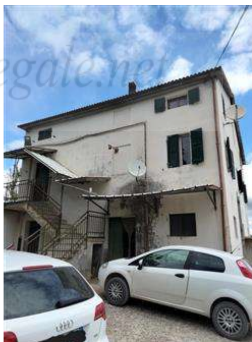
FABBRICATO RURALE CIELO TERRA OVEST
