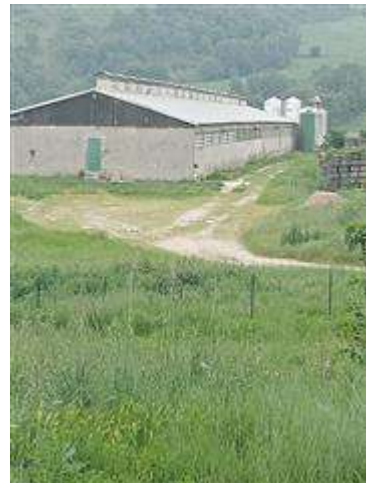
CAPANNONE n°4 ESTERNO
