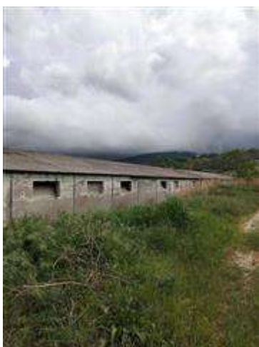
COPERTURA VISTA ESTERNA
