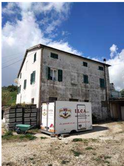
FABBRICATO RURALE CIELO TERRA SUD EST
