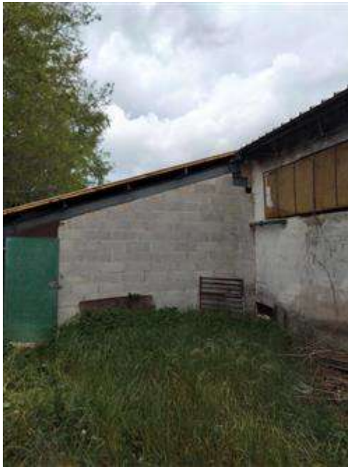
CAPANNONE n° 2 ESTERNO
