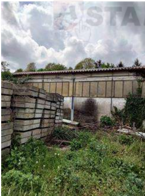
CAPANNONE n° 3 ESTERNO
