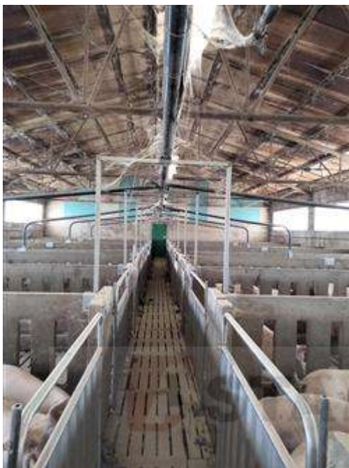
CAPANNONE n°4 INTERNO
