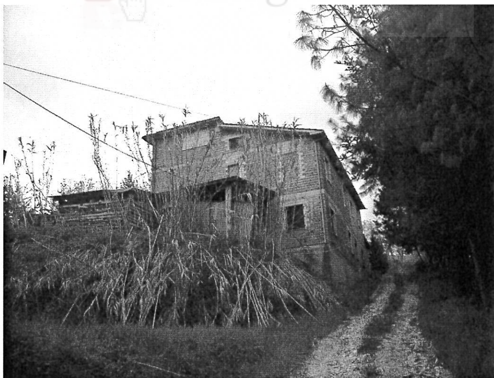
EDIFICIO PRINCIPALE (vista sud – est)
