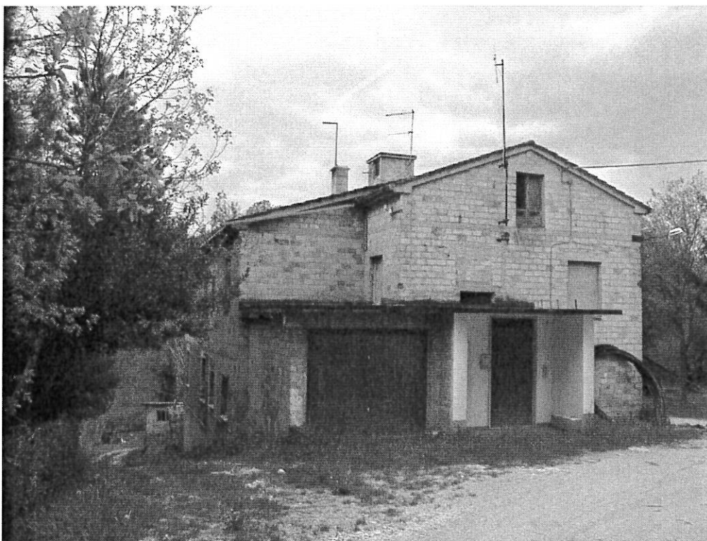
EDIFICIO PRINCIPALE (vista nord - est)
