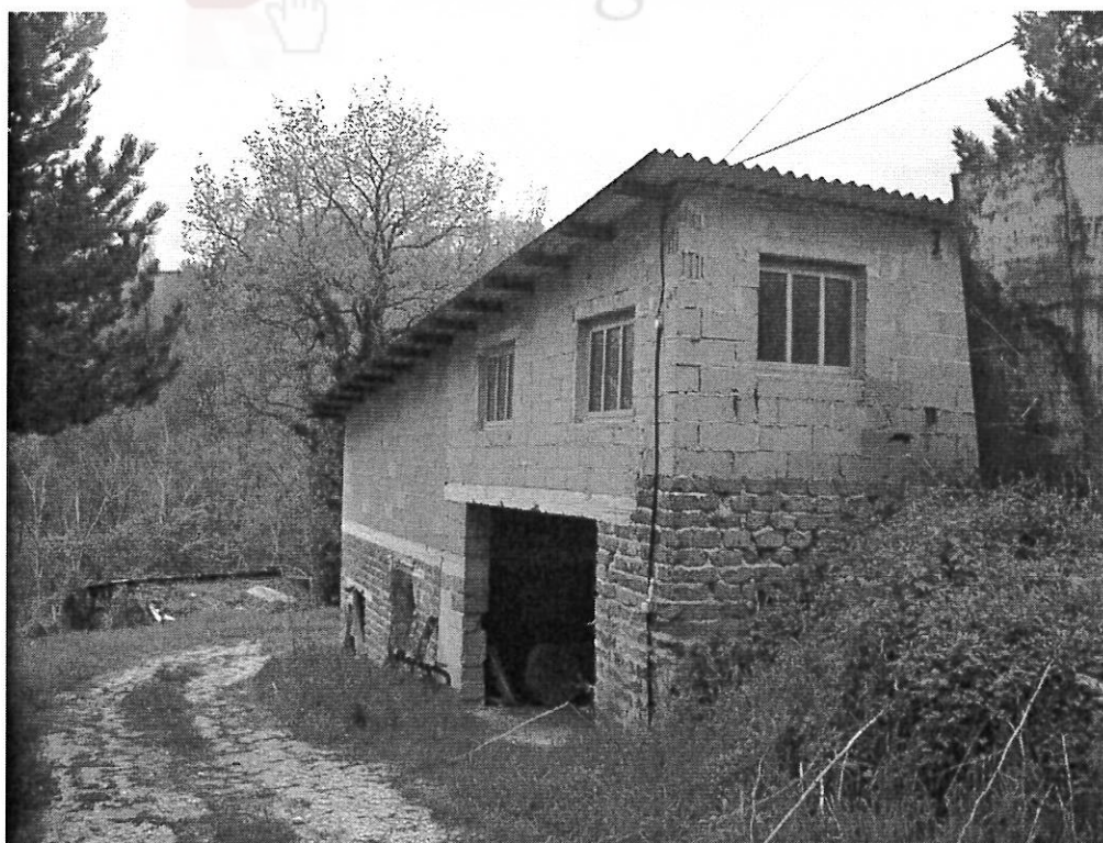
EDIFICIO ACCESSORIO (vista nord - est)
