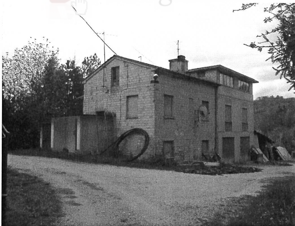
EDIFICIO PRINCIPALE (vista nord – ovest)
