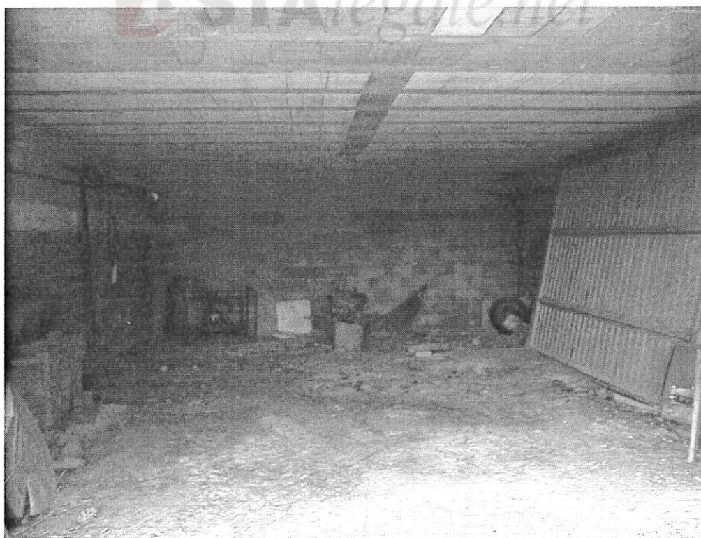
EDIFICIO ACCESSORIO (interni piano 1° sottostrada)
