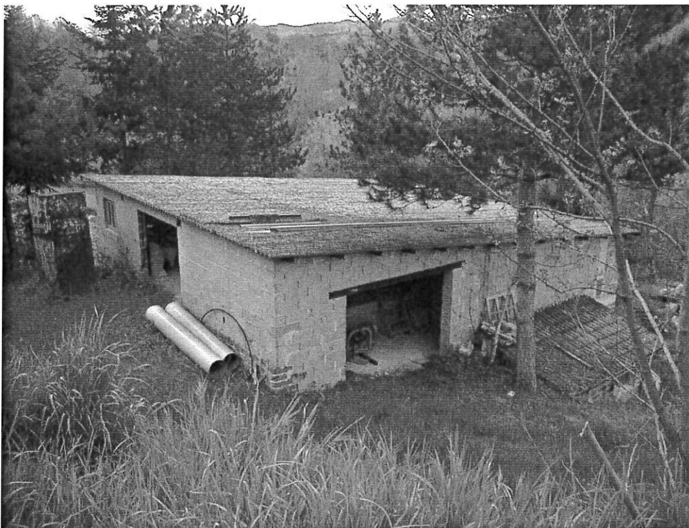
EDIFICIO ACCESSORIO (vista nord - ovest)
