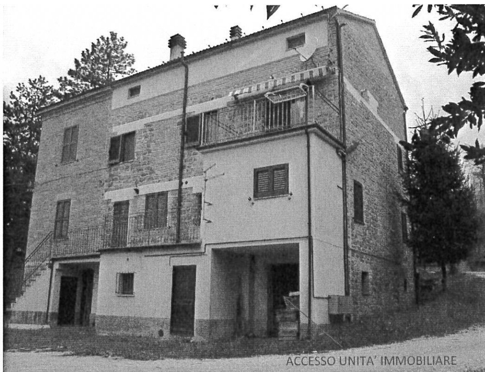
PORZIONE EDIFICIO RESIDENZIALE PART. 116 (vista sud – est)
