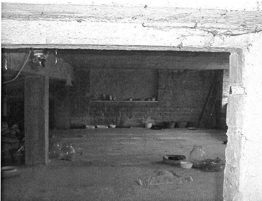
EDIFICIO PRINCIPALE (interni piano 2° sottotetto)
