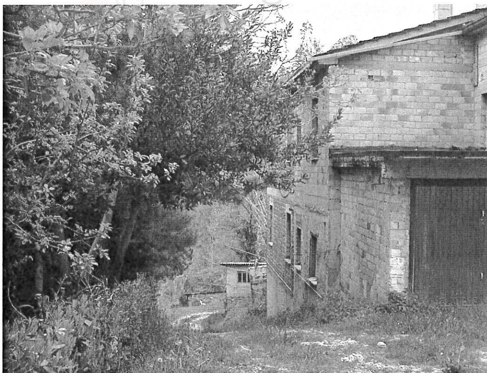
EDIFICIO PRINCIPALE (vista est)
