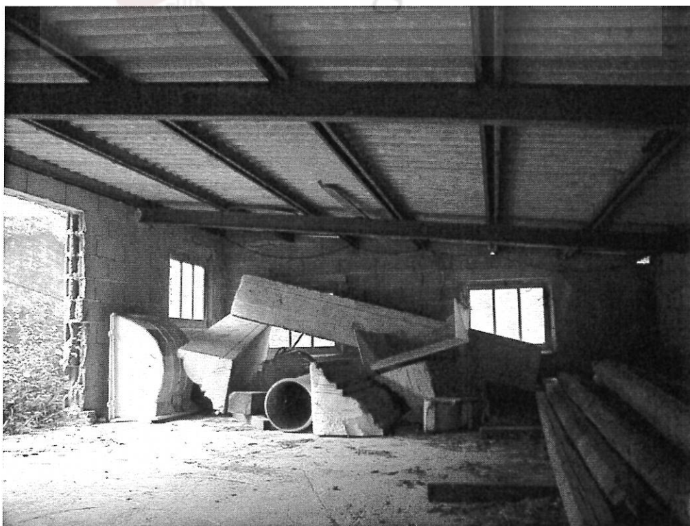
EDIFICIO ACCESSORIO (interni piano terra)
