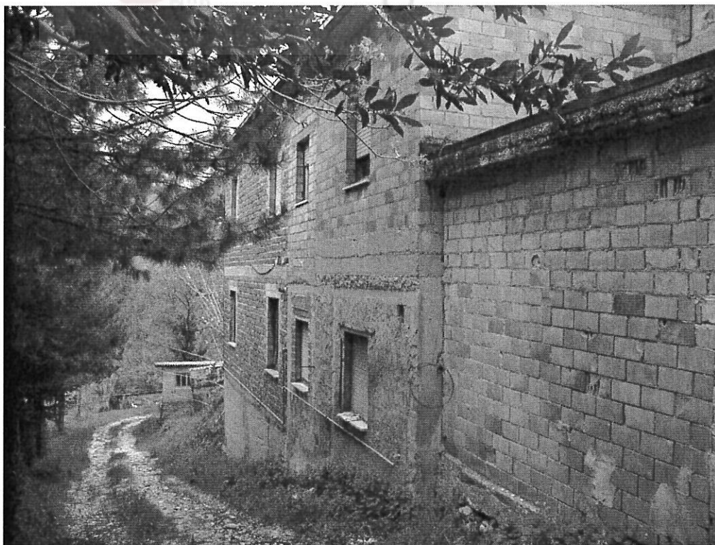
EDIFICIO PRINCIPALE (vista est)
