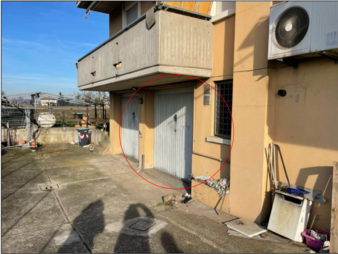
14 - Garage visto dall'esterno
