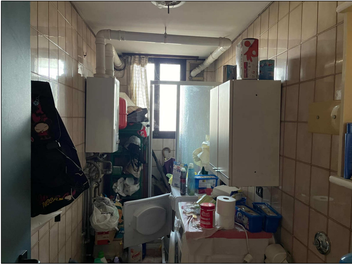
12 - Bagno piano terra
