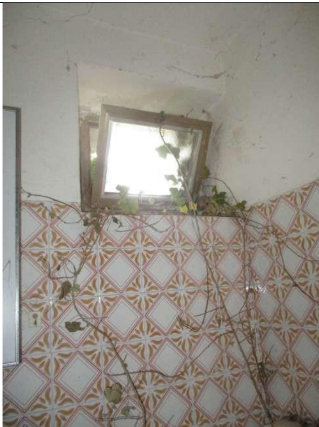
Finestra del Servizio Igienico
