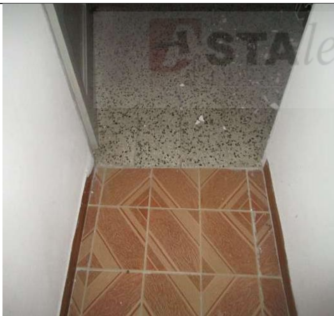
Particolare della pavimentazione piano primo
