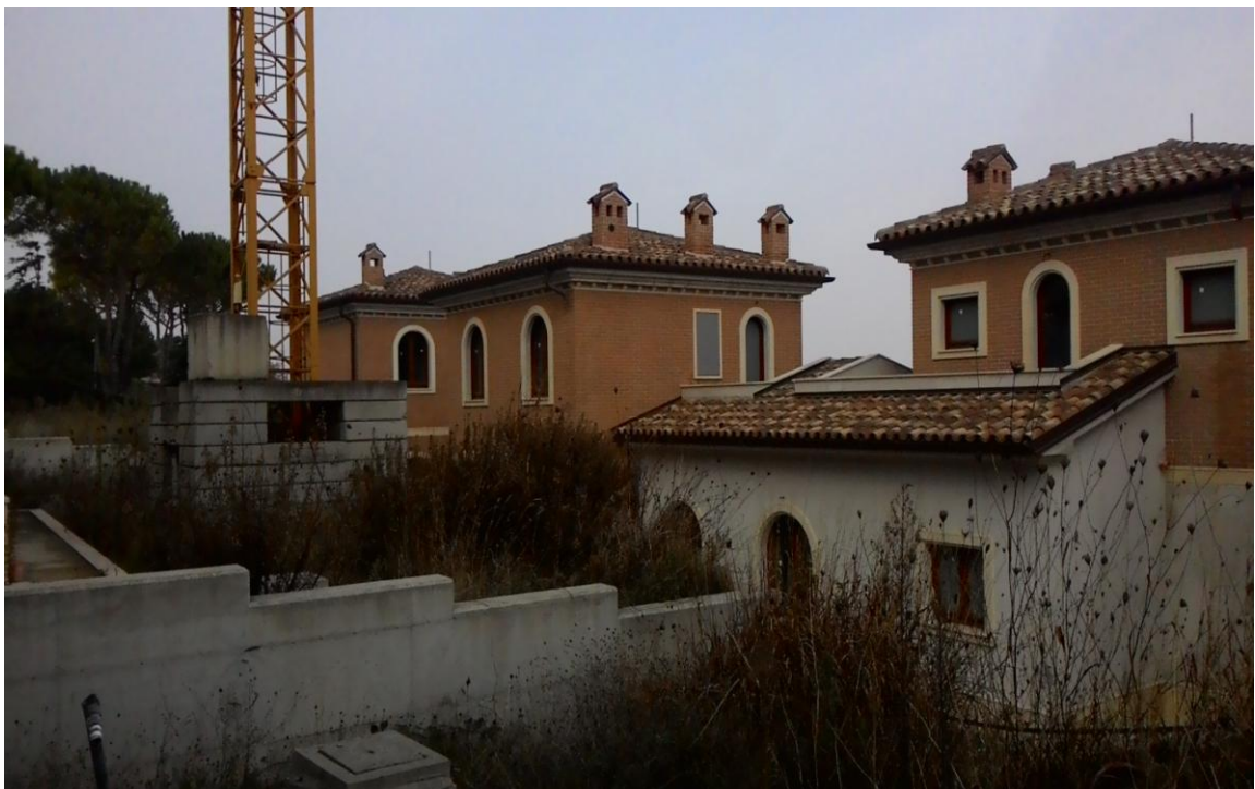
LOTTI 1-2 IMMOBILI AL GREZZO, ESTERNO
