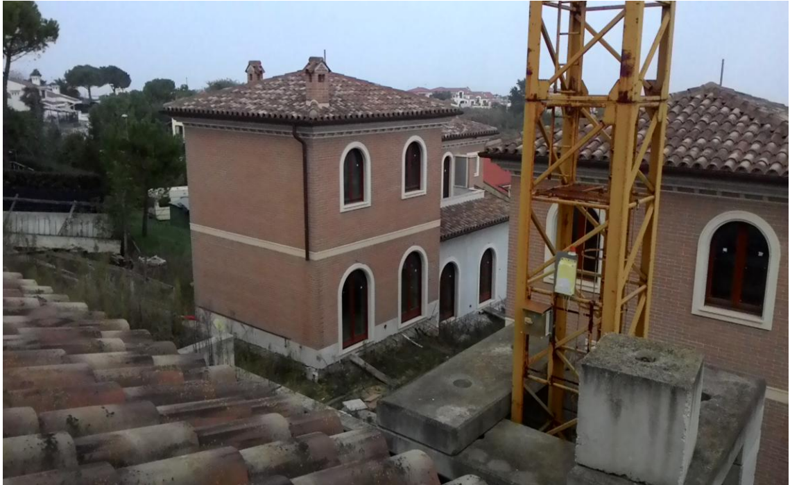
LOTTI 1-2 IMMOBILI AL GREZZO, ESTERNO
