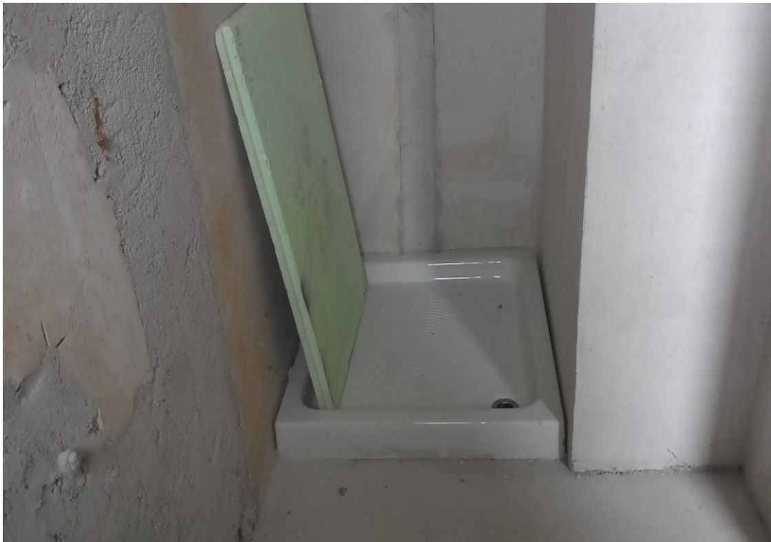
LOTTI 1-2 IMMOBILI AL GREZZO, INTERNI
