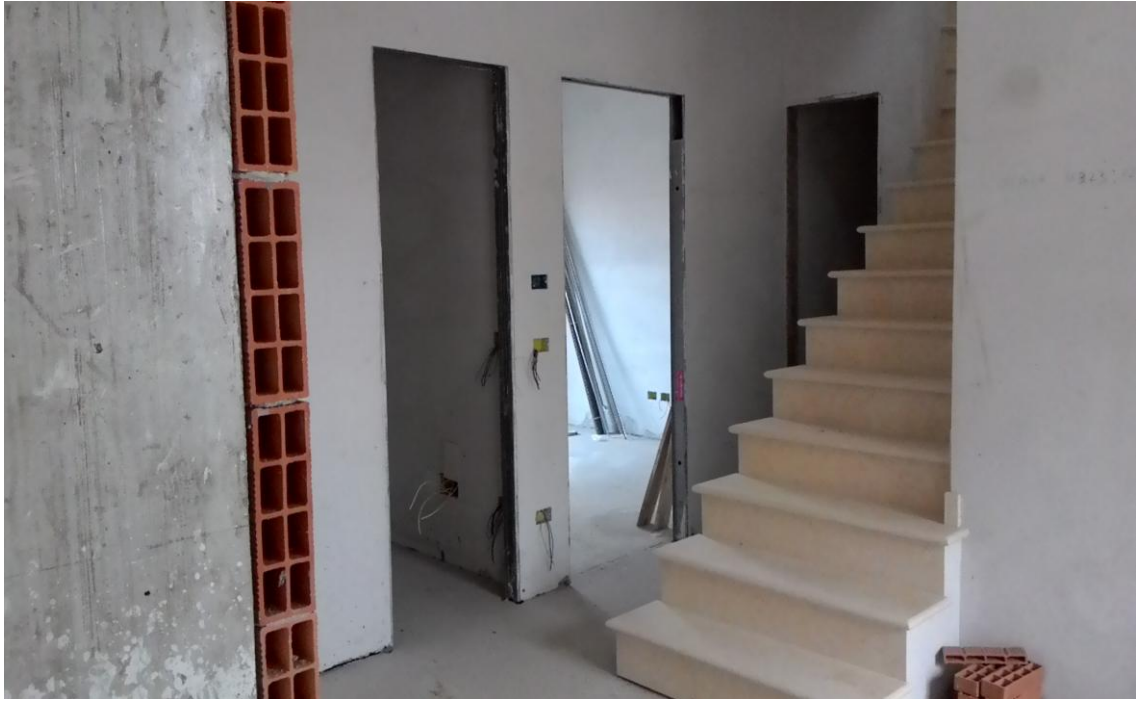
LOTTI 1-2 IMMOBILI AL GREZZO, INTERNI
