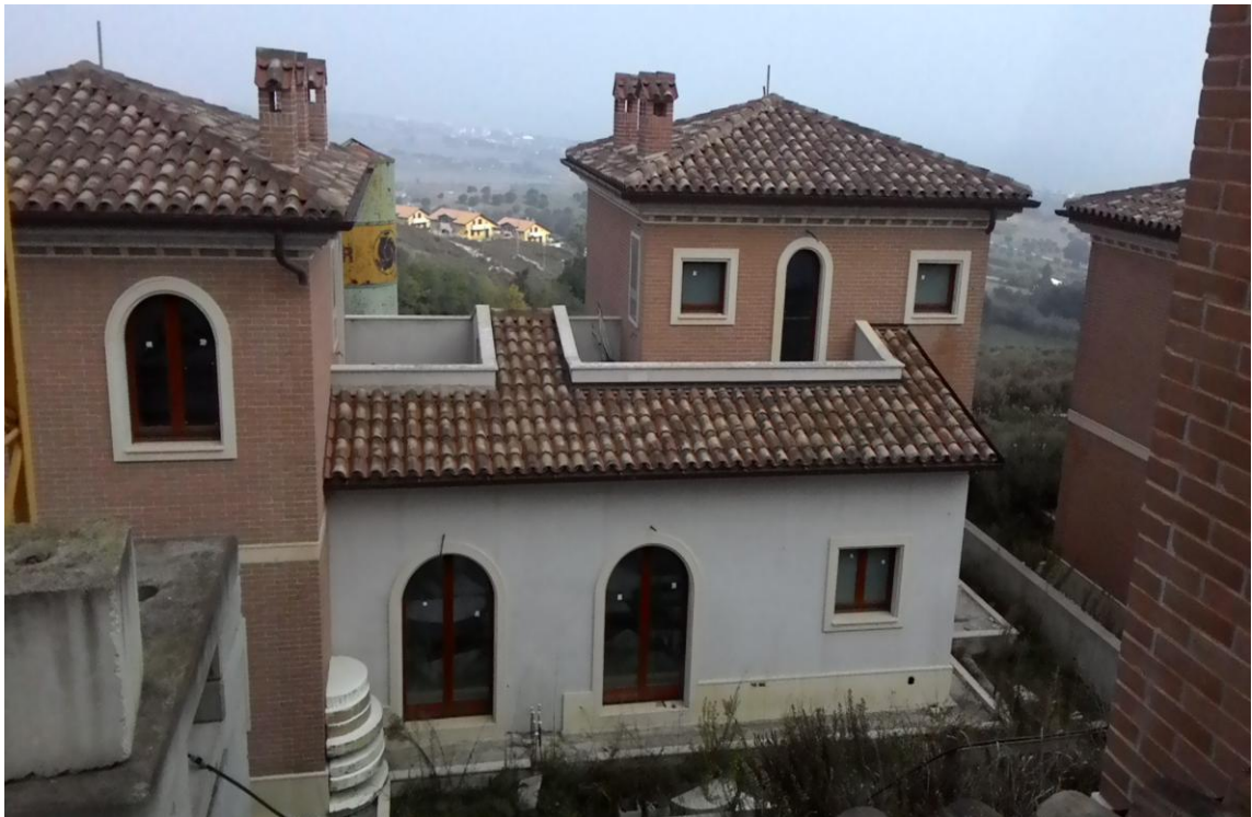
LOTTI 1-2 IMMOBILI AL GREZZO, ESTERNO
