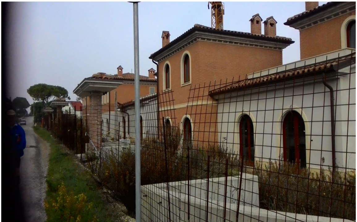
LOTTI 1-2 IMMOBILI AL GREZZO, ESTERNO
