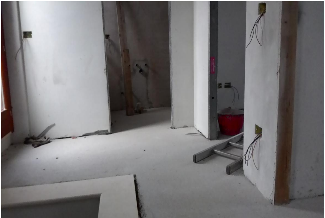
LOTTI 1-2 IMMOBILI AL GREZZO, INTERNI
