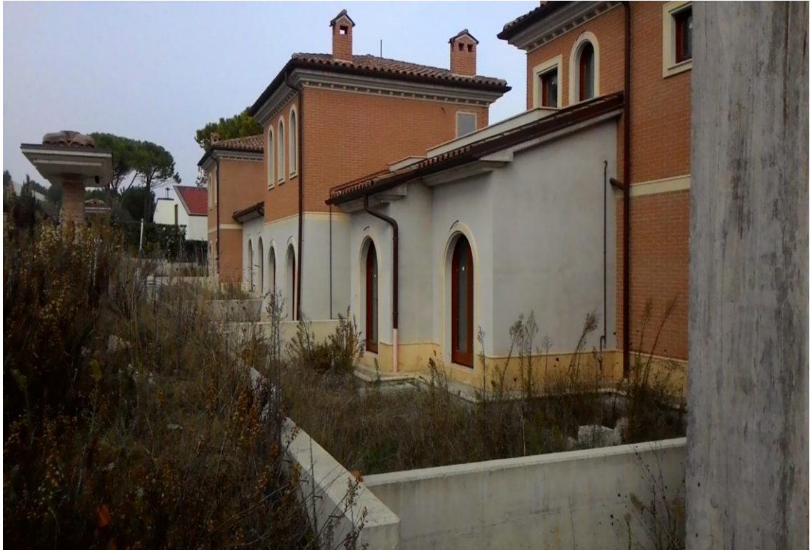
LOTTI 1-2 IMMOBILI AL GREZZO, ESTERNO
