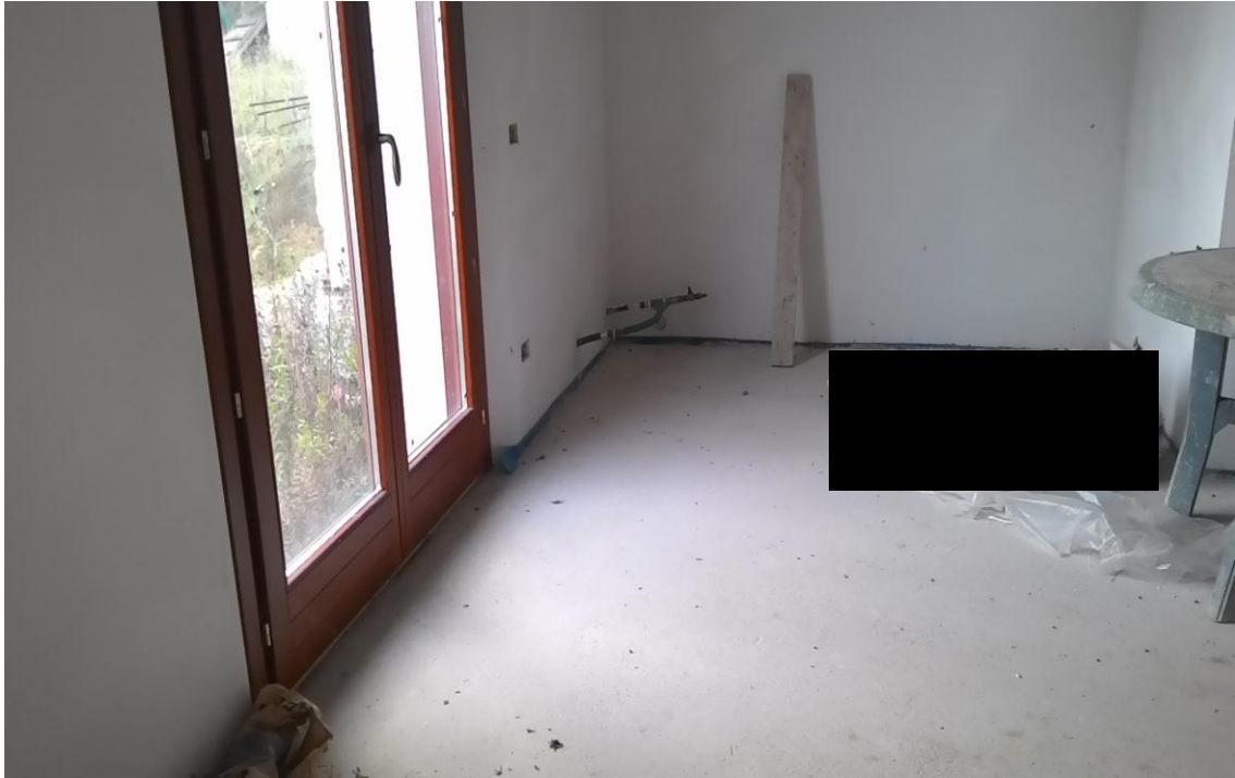
LOTTI 1-2 IMMOBILI AL GREZZO, INTERNI
