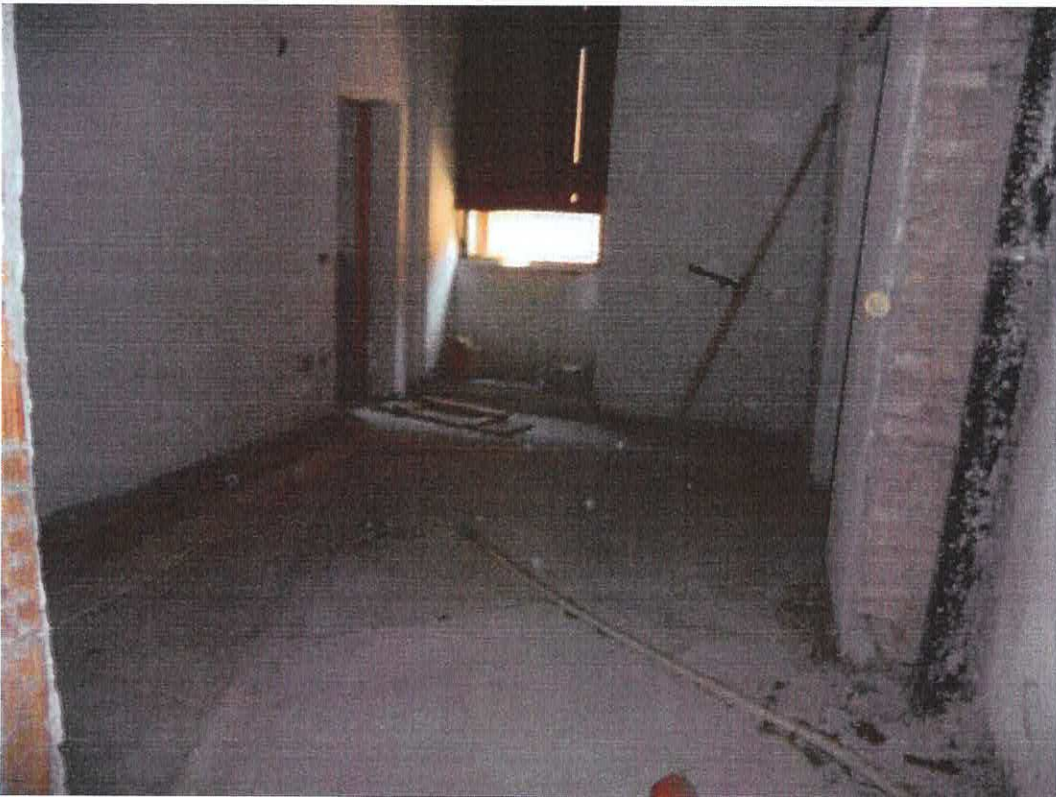
Foto n.4 - Porzione del piano dell'appartamento nobile allo stato grezzo
