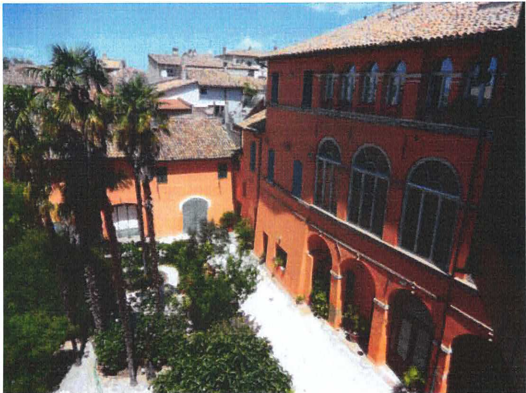
Foto n.2 - Prospetto retro e vista della corte interna
