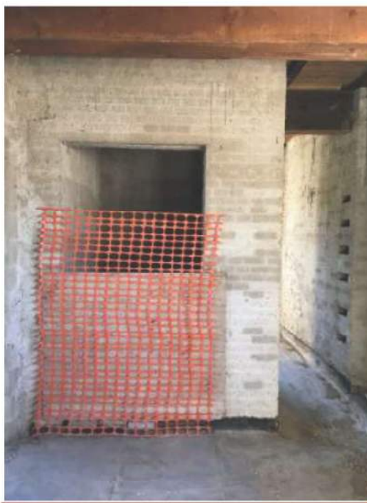
FOTO 86 sta Ascensore Interno Piano Secondo
