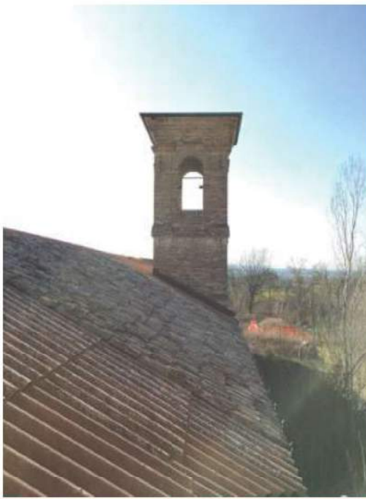
FOTO 84 Vista Copertura ex Chiesa Piano Secondo
