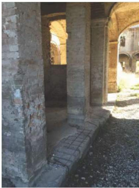
FOTO 14 Porticato Ingresso Piano Terra
