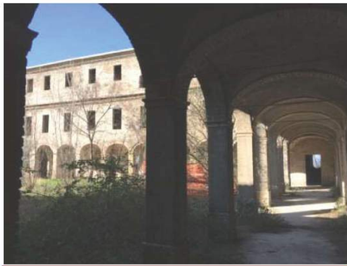
FOTO 45 Vista Cortile Interno Piano Terra
