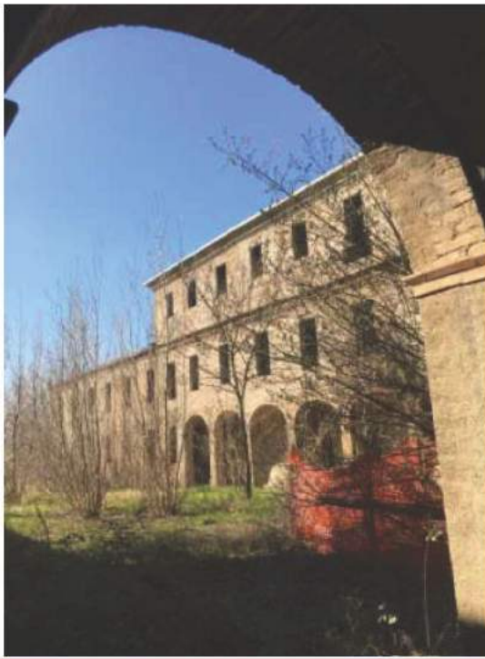
FOTO 25 Vista Porticato Interno Piano Terra
