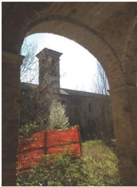
FOTO 22 Vista da Porticato nterno Piano Terra
