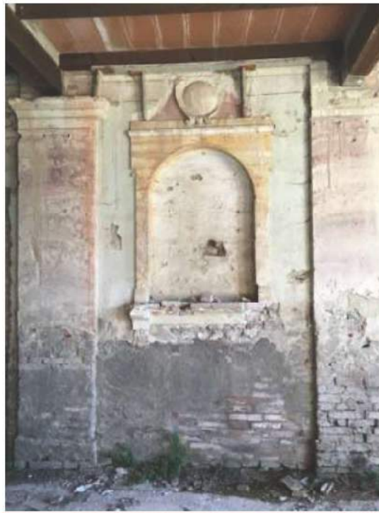
FOTO 54 sta Interno ex Chiesa Piano Terra
