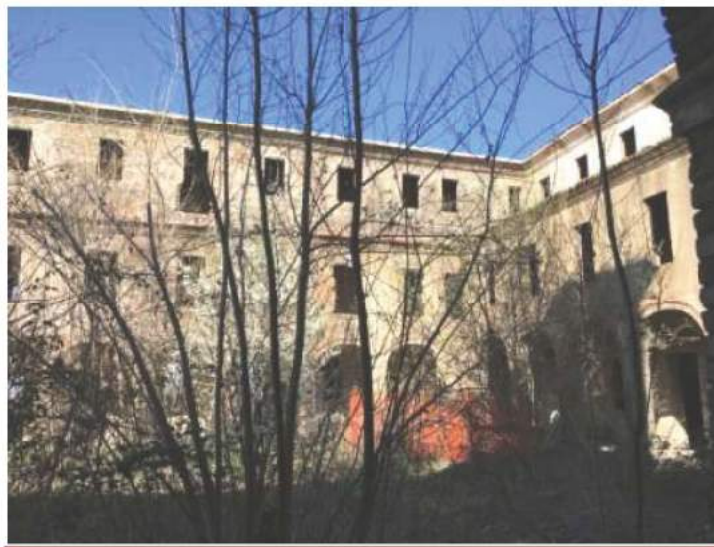
FOTO 48 Vista Cortile Interno Piano Terra
