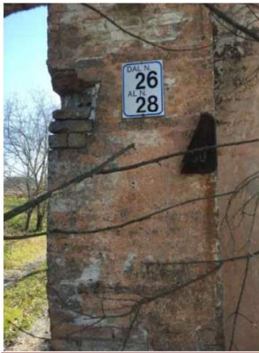
FOTO 2 Particolare Ingresso da Nord
