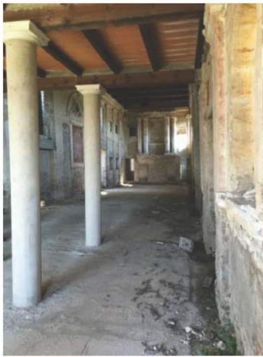
FOTO 62 Vista Interno ex Chiesa Piano Terra
