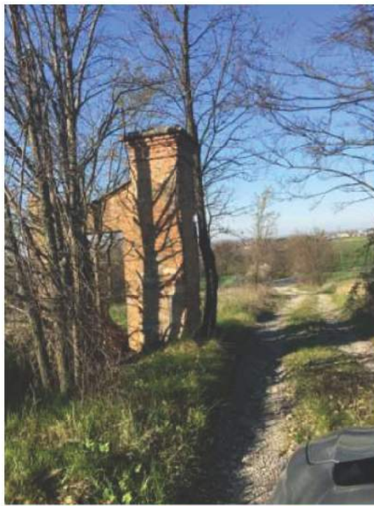
FOTO 153 Vista Esterno Accesso Lato Nord
