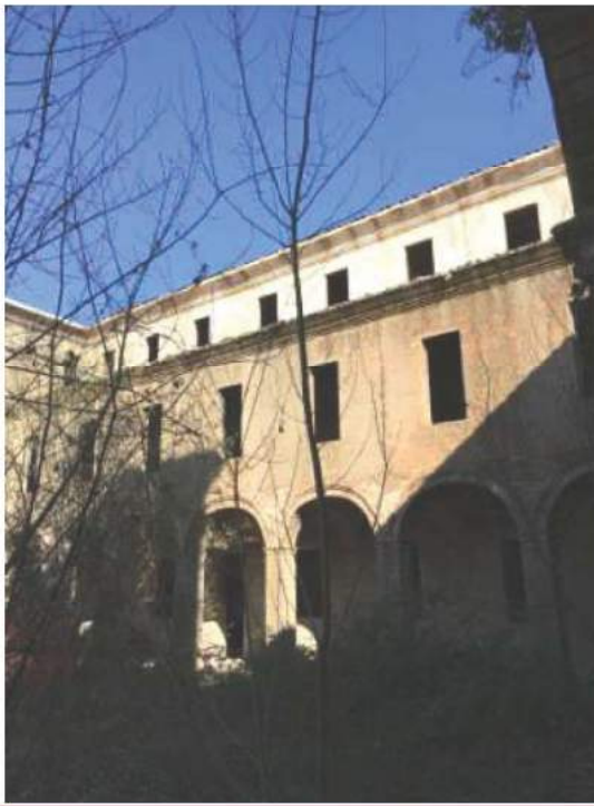
FOTO 49 Vista Cortile Interno Piano Terra
