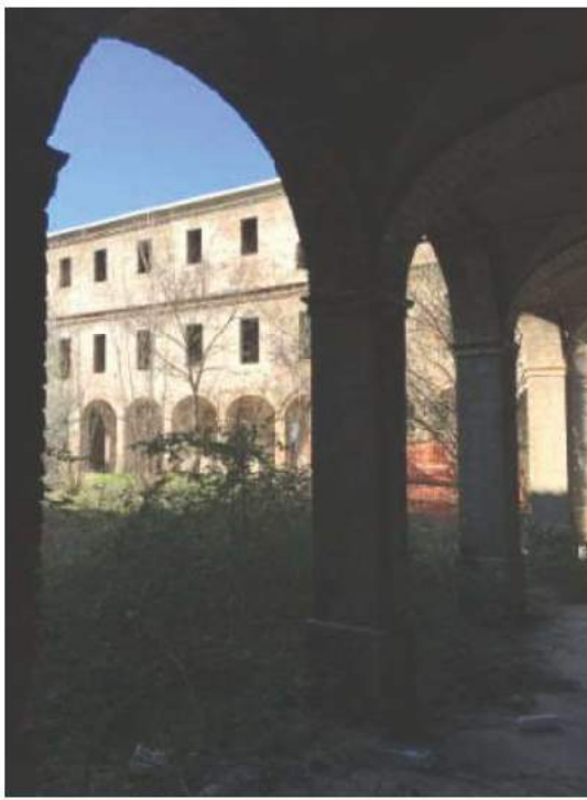
FOTO 44 Vista Cortile Interno Piano Terra
