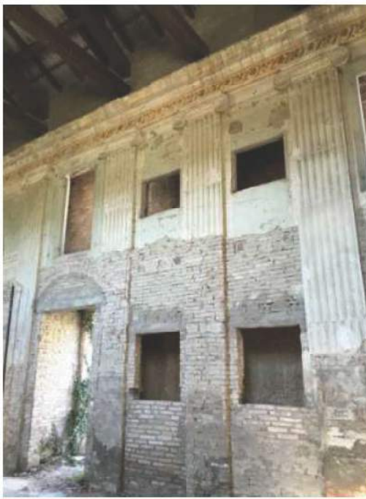
FOTO 50 Vista Interno ex Chiesa Piano Terra
