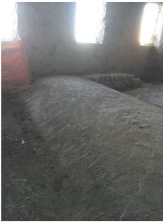
FOTO 32 Vista Solaio Voltato Piano Terra
