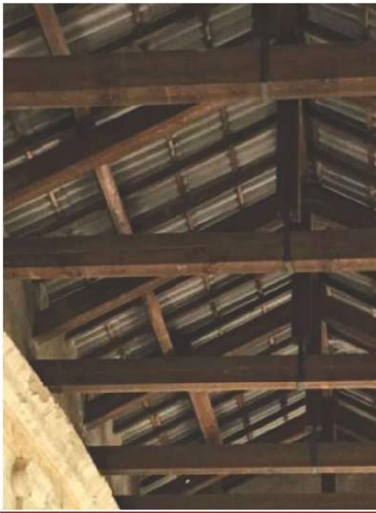
FOTO 65 ista Interno ex Chiesa Piano Terra
