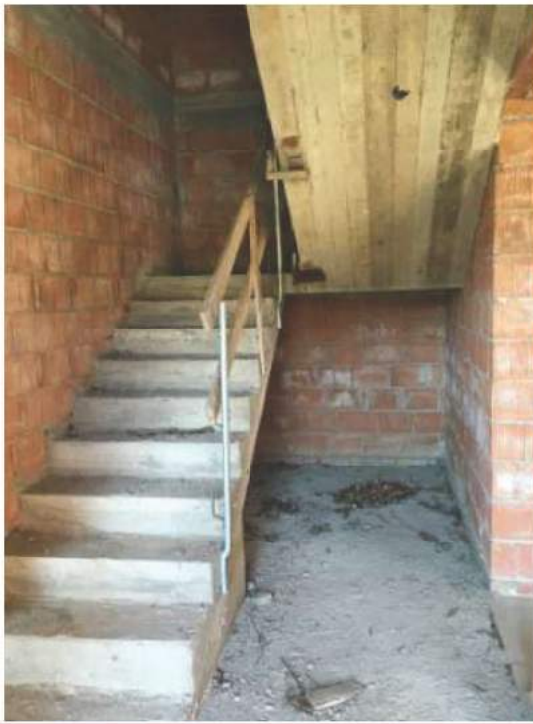
FOTO 135 Vista Interno asa Fattore Piano Terra
