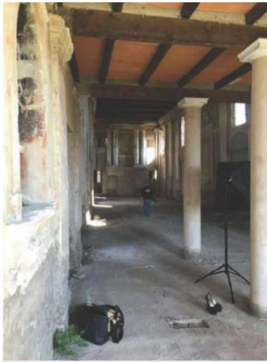
FOTO 63 Vista Interno ex Chiesa Piano Terra
