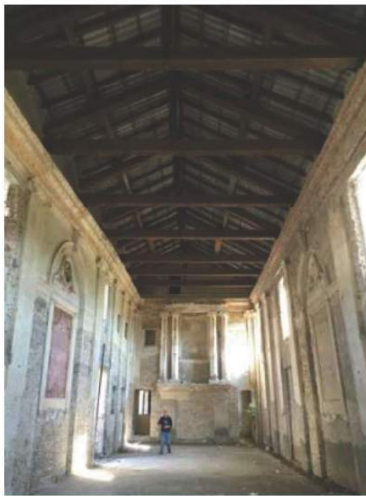
FOTO 64 Vista Interno ex Chiesa Piano Terra
