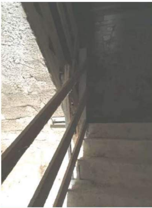
FOTO 80 Vista Scala Accesso Piano Secondo
