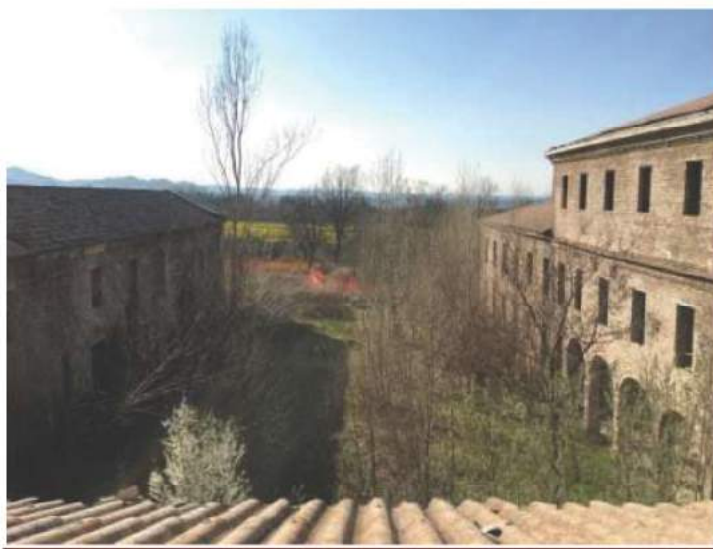
FOTO 118 Vista Esterno Cortile Interno Ovest
