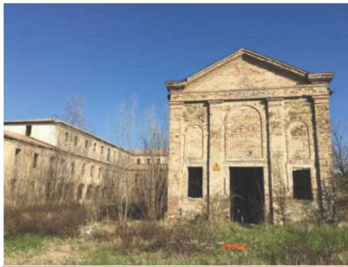
FOTO 56 Vista Esterno ex Chiesa da Sud-Ovest
