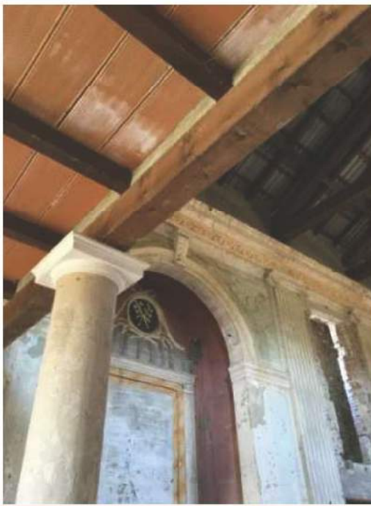
FOTO 66 ista Interno ex Chiesa Piano Terra
