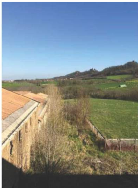
FOTO 94 Vista Prospetto Sud Casa Fattore
