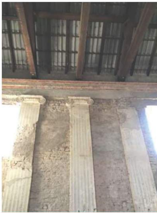
FOTO 68 sta Interno ex Chiesa Piano Terra
