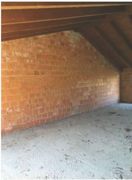
FOTO 136 Vista Interno asa Fattore 1° Piano
