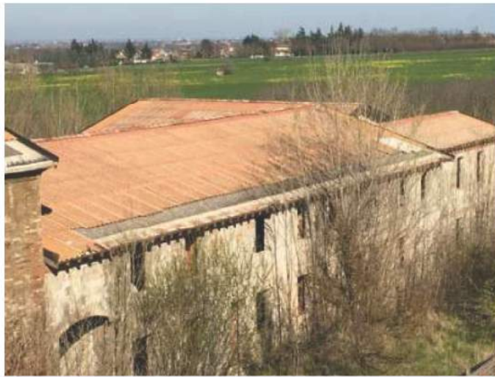
FOTO 93 Vista Prospetto Sud E Copertura Casa Fattore
