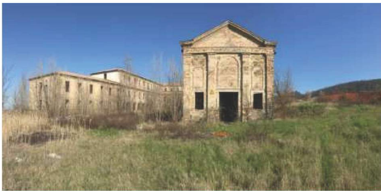
FOTO 58 Vista Esterno ex Chiesa da Sud-Ovest
