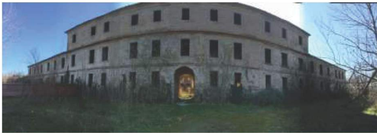
FOTO 10 Vista Panoramica da Nord
