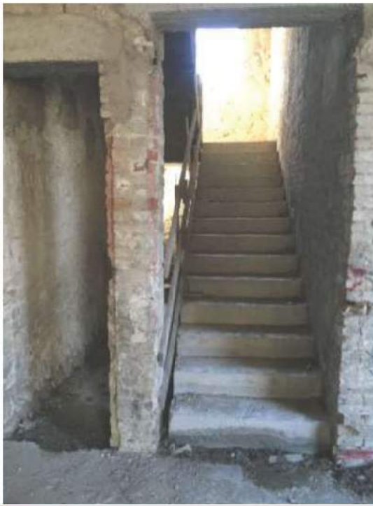
FOTO 69 Vista Interno Scala Ascensore Piano Terra
