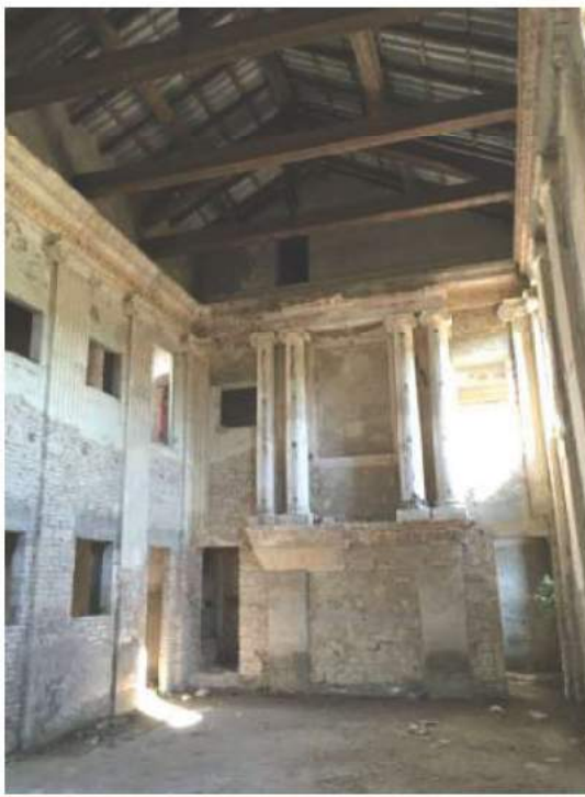
FOTO 52 ista Interno ex Chiesa Piano Terra
