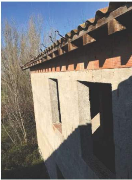
FOTO 138 Vista Esterno Nord Casa Fattore
