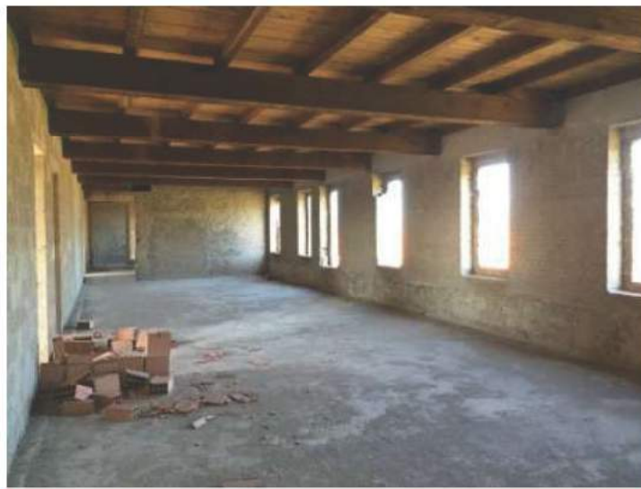
FOTO 89 Vista Ascensore Interno Piano Secondo
