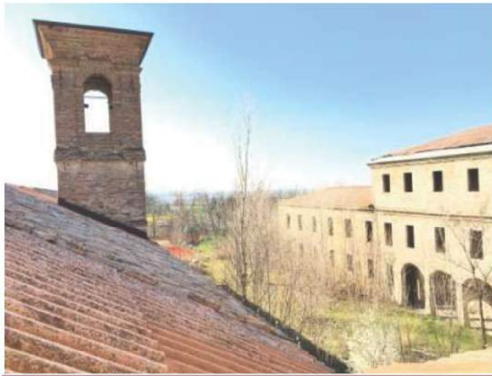
FOTO 85 Vista Copertura ex Chiesa Piano Secondo
