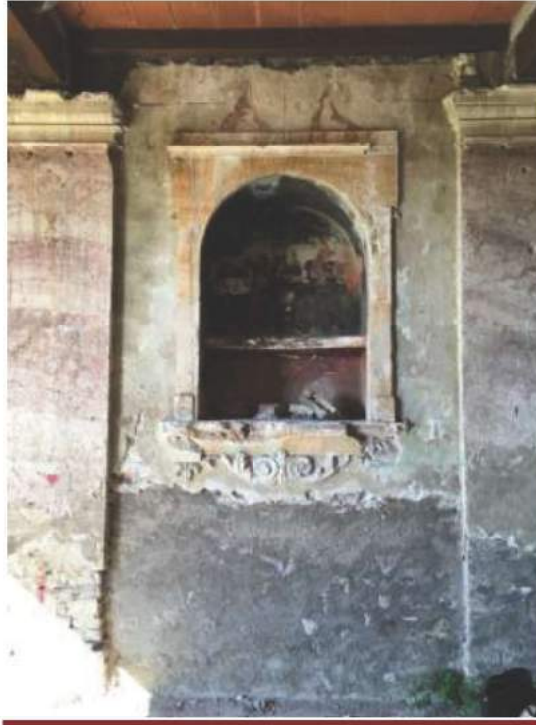
FOTO 53 sta Interno ex Chiesa Piano Terra
