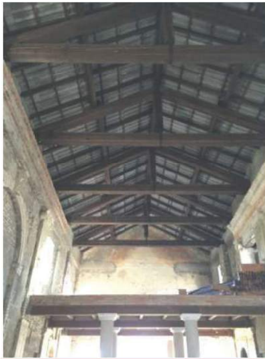
FOTO 67 sta Interno ex Chiesa Piano Terra
