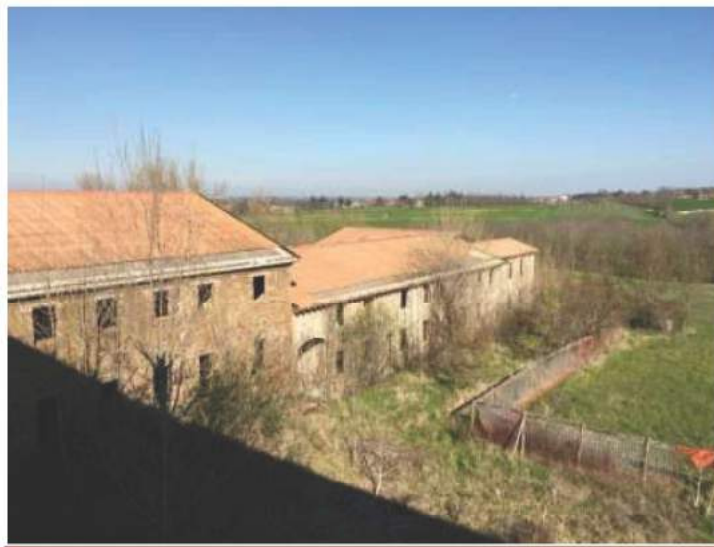
FOTO 92 Vista Prospetto Sud Casa Fattore
