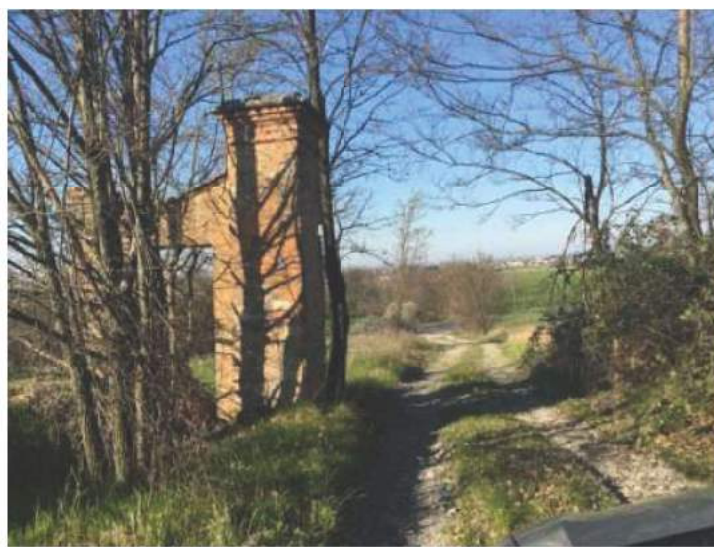
FOTO 154 Vista Esterno Accesso Lato Nord
