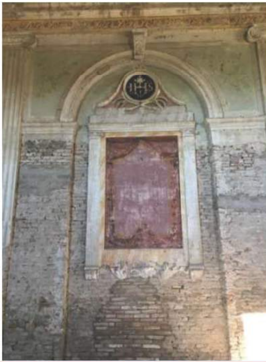
FOTO 51 ista Interno ex Chiesa Piano Terra
