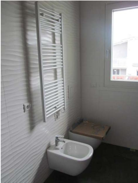
In ogni bagno verrà posato un termo-arredo elettrico. Verrà fornito un termostato ambiente per ogni piano (n. 2 termostati per unità). Verrà predisposto uno split idronico a parete per il raffrescamento estivo in ogni locale (bagni e disimpegni esclusi).
