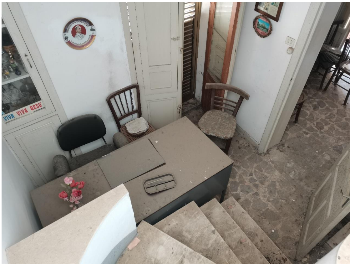
FOTO 11 – disimpegno-studio (piano primo)
