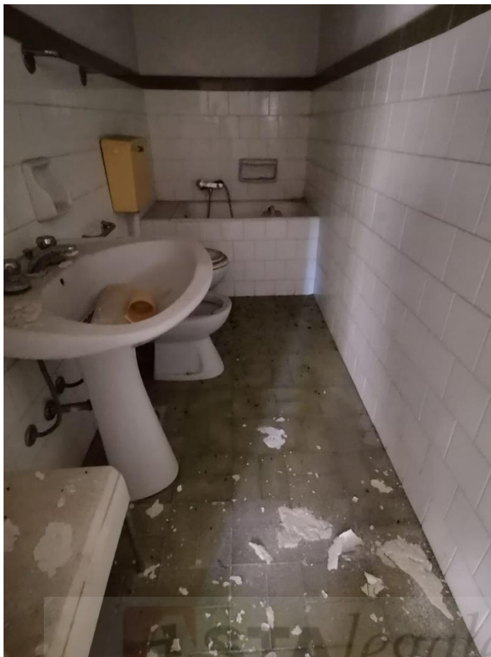
FOTO 9 – bagno 2 (piano primo)
