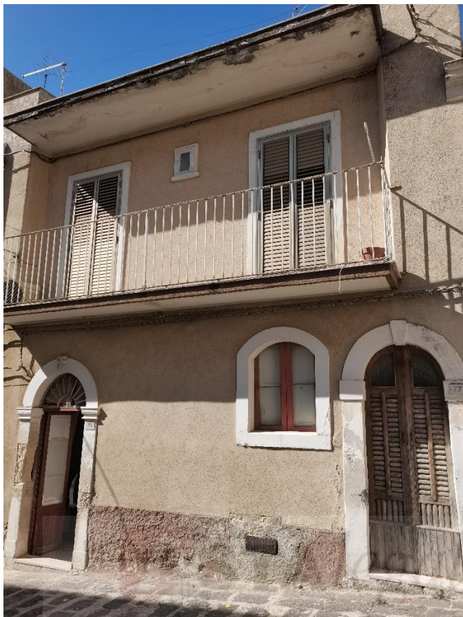
FOTO 1 – prospetto su via Nino Bixio
