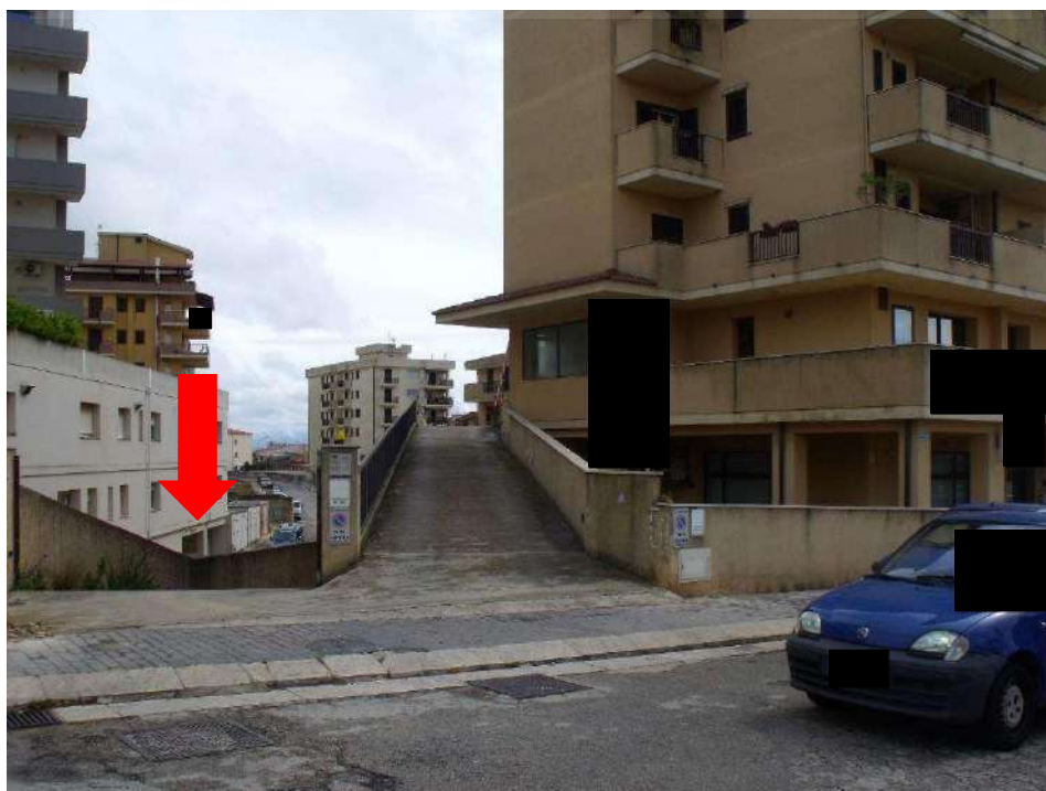
ESTERNO - INGRESSO DAL N. 26 DI VIA G. PERLASCA
