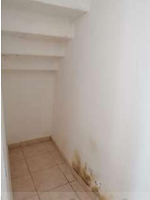
Foto 10 – Ripostiglio sottoscala (macchie di umido)
