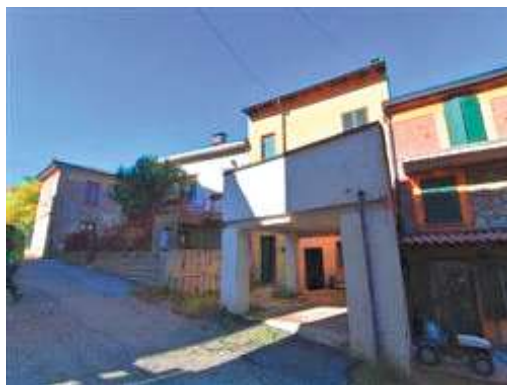
Altra vista dell'immobile dalla strada
