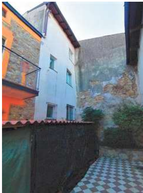
Vista esterna dell'immobile, sul retro
