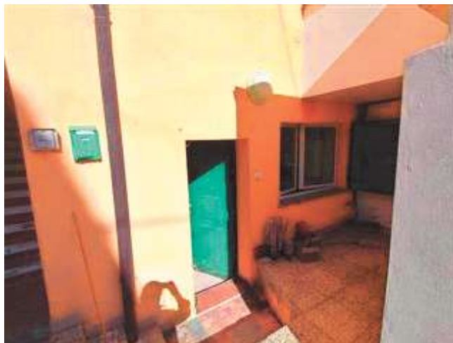
Vista dall'esterno della porta d'ingresso
