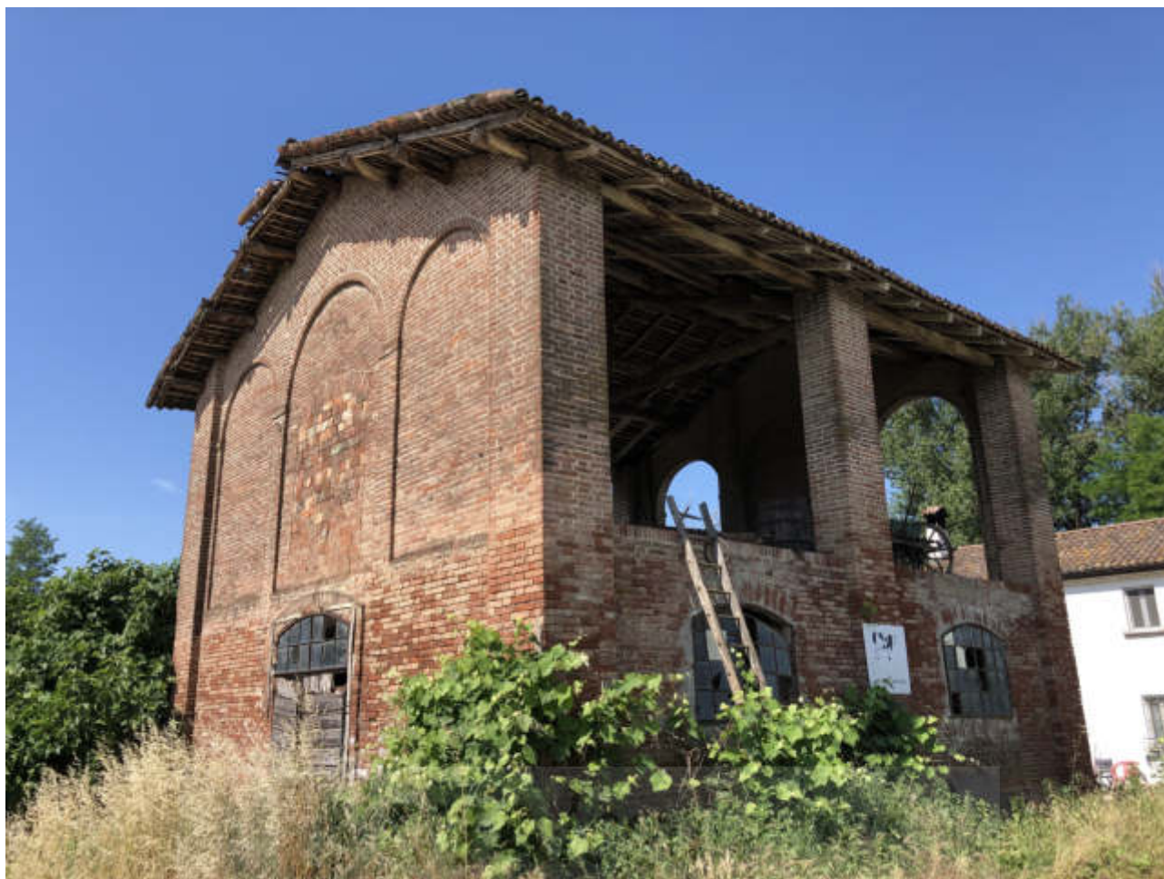
FOTO N. 10 VISTA ESTERNA - FGL. 10, MAPP. 283, SUB. 1
