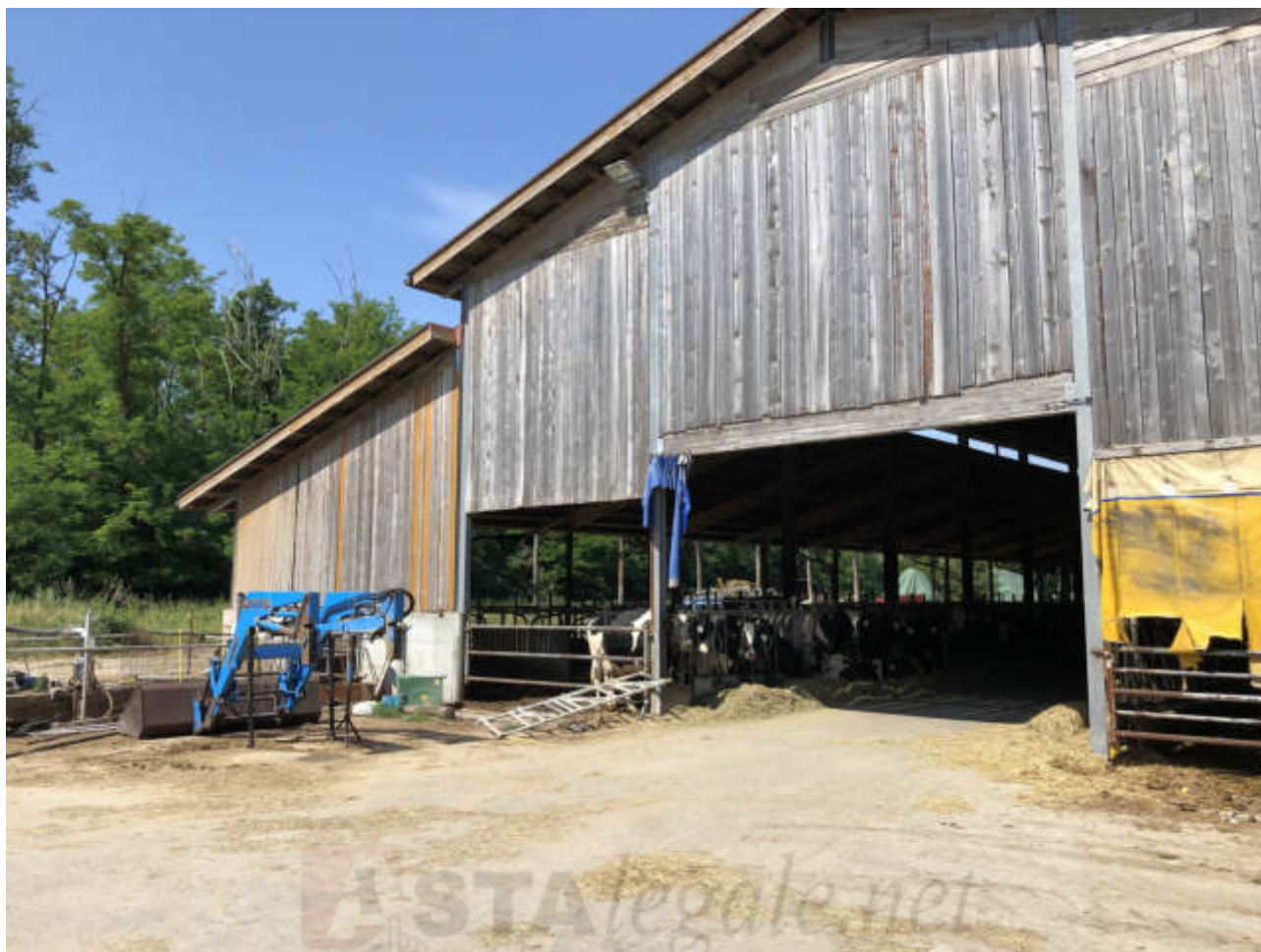
FOTO N. 20 VISTA ESTERNA - FGL. 10, MAPP. 283, SUB. 1
