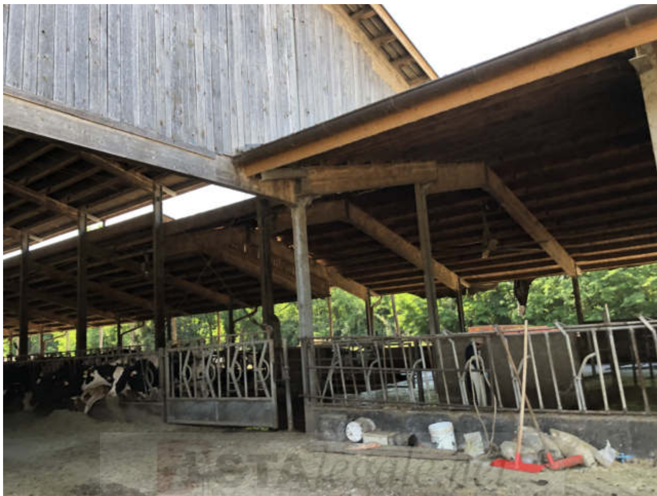
FOTO N. 28 VISTA ESTERNA - FGL. 10, MAPP. 283, SUB. 1
