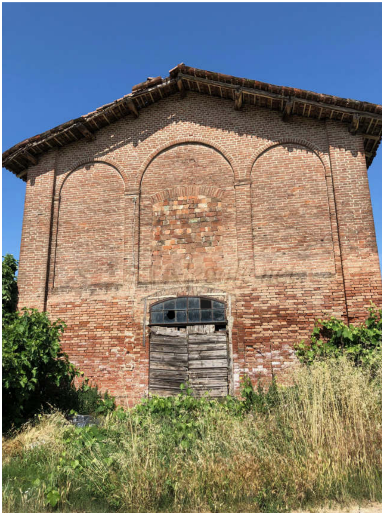
FOTO N. 11 VISTA ESTERNA - FGL. 10, MAPP. 283, SUB. 1
