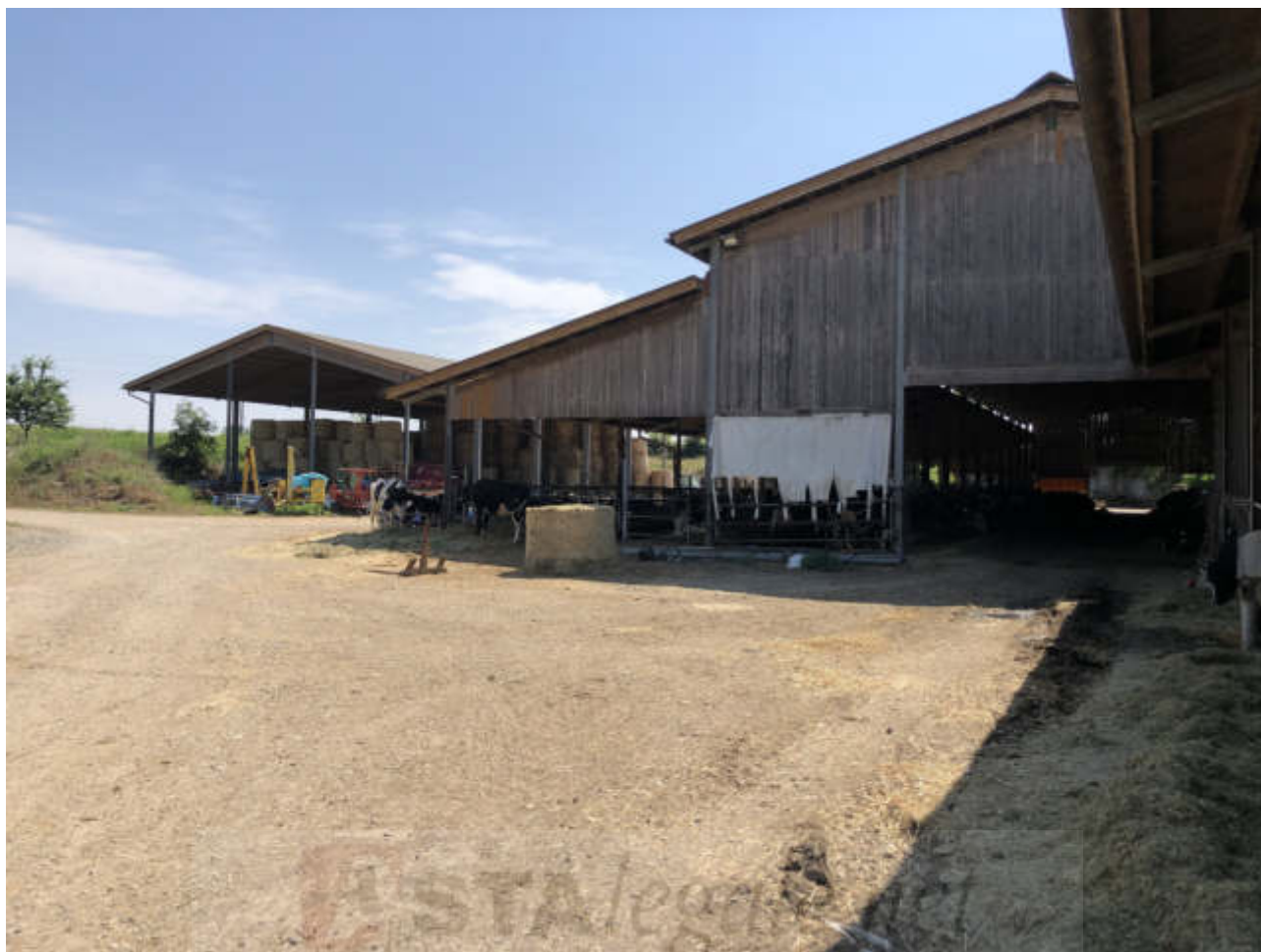
FOTO N. 26 VISTA ESTERNA - FGL. 10, MAPP. 283, SUB. 1
