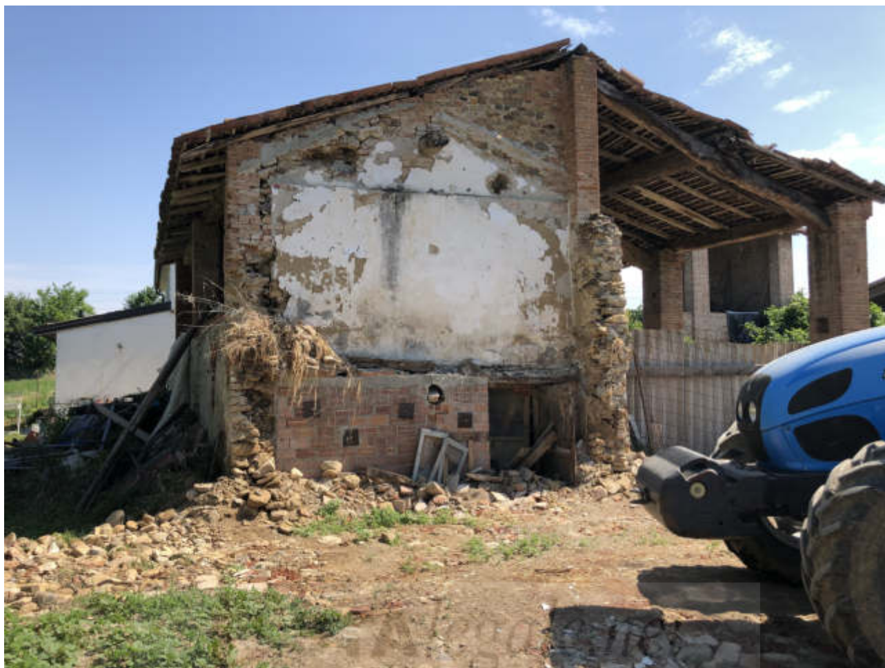
FOTO N. 33 VISTA ESTERNA - FGL. 10, MAPP. 283, SUB. 3
