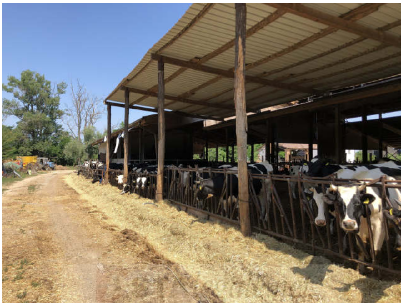
FOTO N. 24 VISTA ESTERNA - FGL. 10, MAPP. 283, SUB. 1
