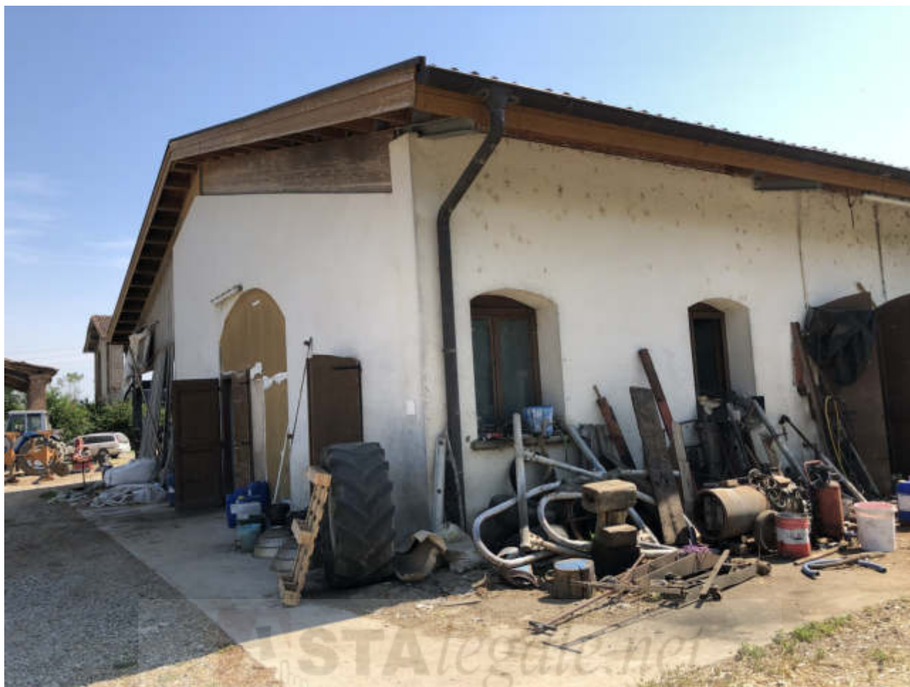
FOTO N. 25 VISTA ESTERNA - FGL. 10, MAPP. 283, SUB. 1
