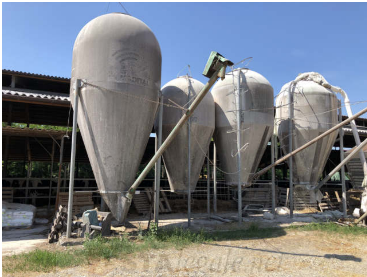
FOTO N. 19 VISTA ESTERNA - FGL. 10, MAPP. 283, SUB. 1
