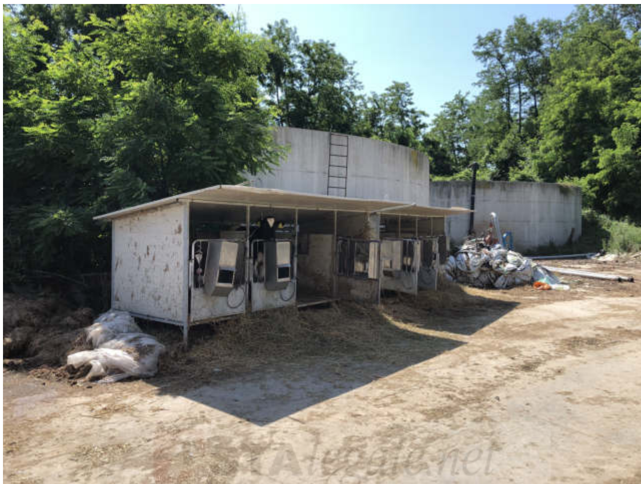
FOTO N. 22 VISTA ESTERNA - FGL. 10, MAPP. 283, SUB. 1
