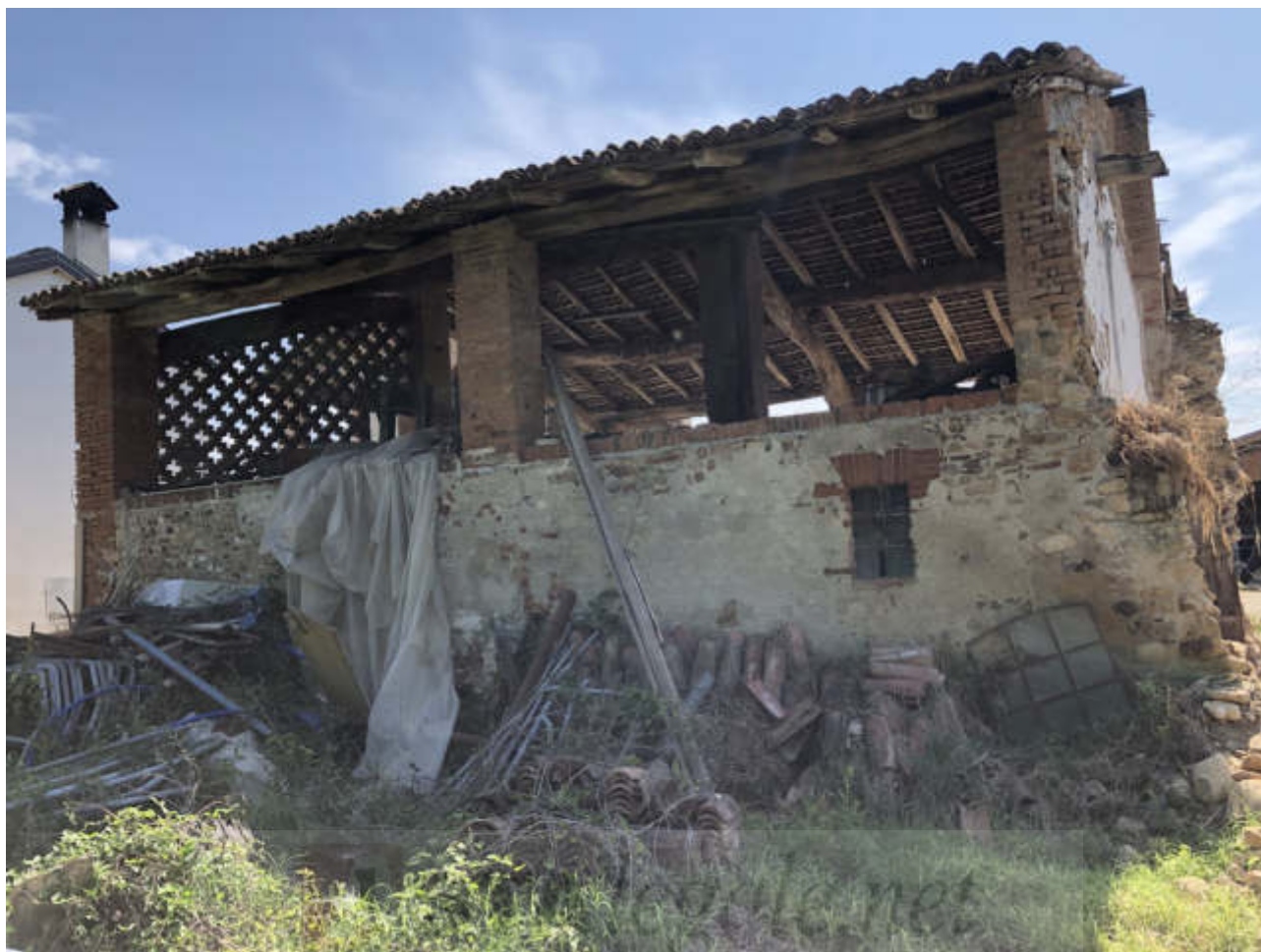
FOTO N. 31 VISTA ESTERNA - FGL. 10, MAPP. 283, SUB. 3
