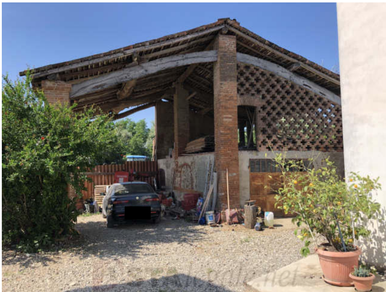
FOTO N. 29 VISTA ESTERNA - FGL. 10, MAPP. 283, SUB. 3
