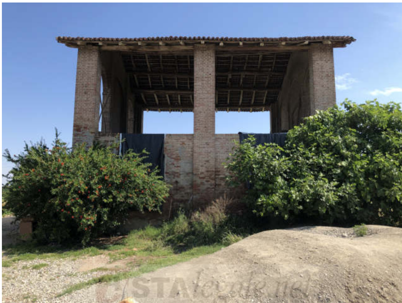
FOTO N. 12 VISTA ESTERNA - FGL. 10, MAPP. 283, SUB. 1
