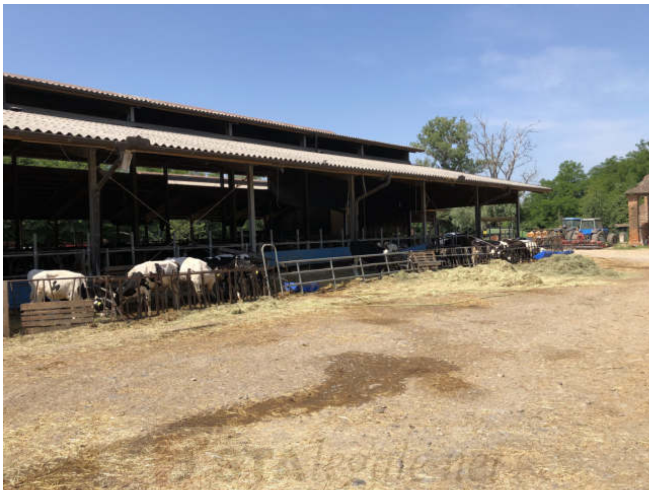
FOTO N. 18 VISTA ESTERNA - FGL. 10, MAPP. 283, SUB. 1
