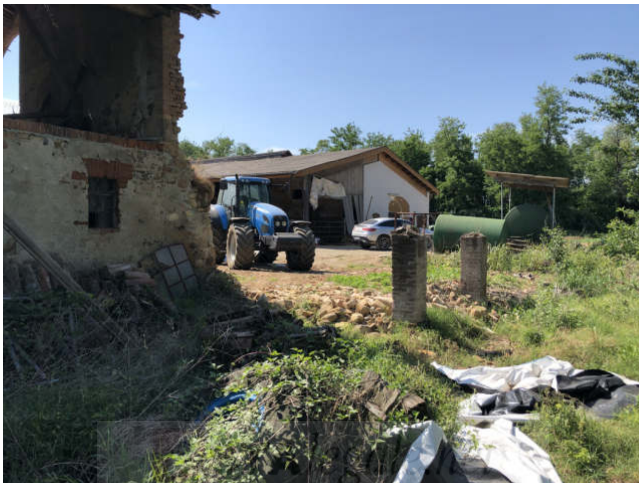
FOTO N. 30 VISTA ESTERNA - FGL. 10, MAPP. 283, SUB. 3
