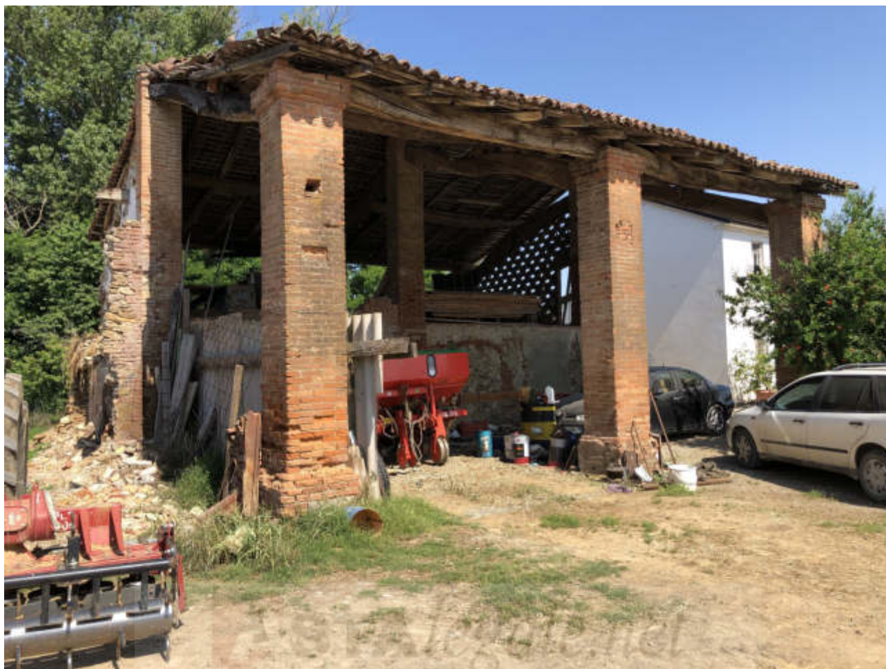
FOTO N. 32 VISTA ESTERNA - FGL. 10, MAPP. 283, SUB. 3
