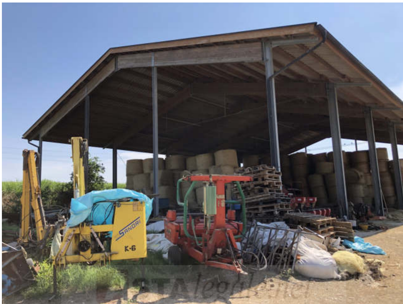
FOTO N. 15 VISTA ESTERNA - FGL. 10, MAPP. 283, SUB. 1
