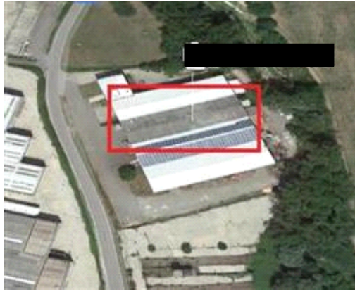
VISTA DALL'ALTO DELLA COPERTURA IN FIBRO-AMIANTO
