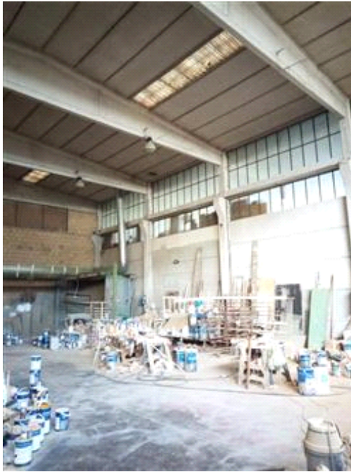
interno con evidenziata la struttura a capriata
