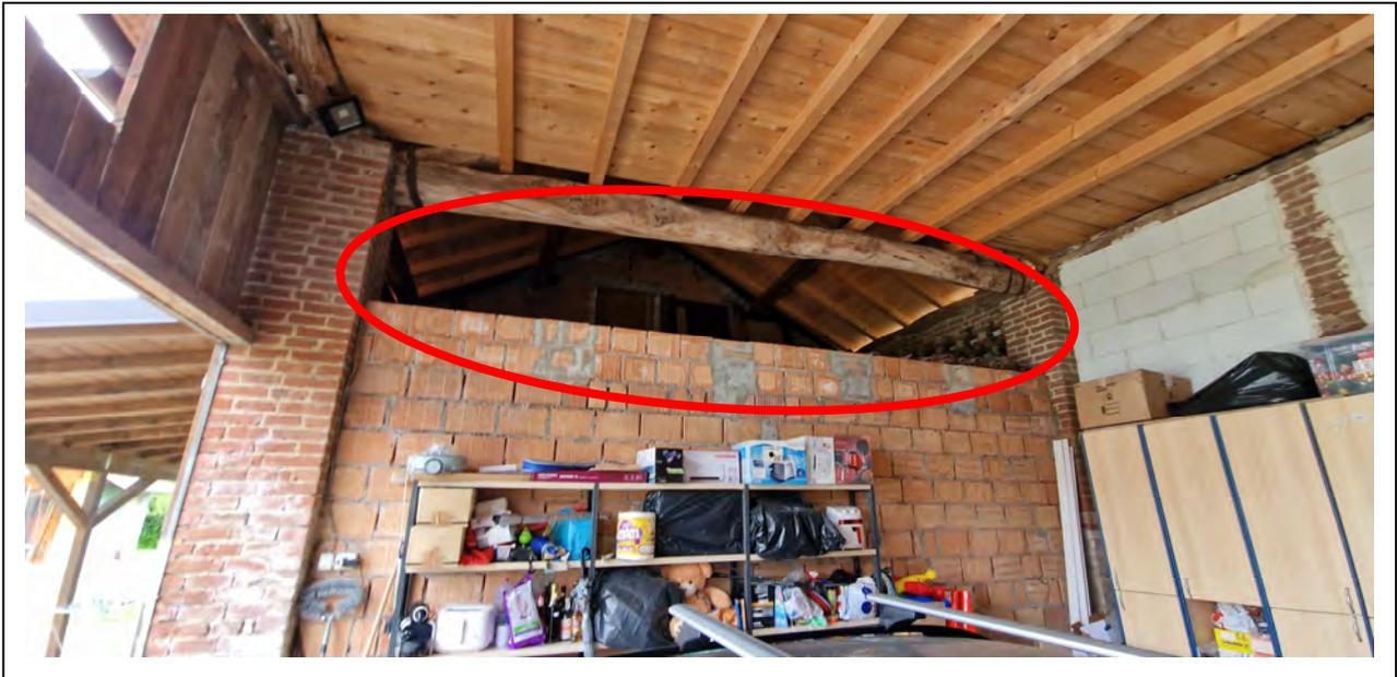
Piano Terra. Vista dal portico. Parete del soggiorno. È visibile il vuoto sul portico e l'assenza del solaio strutturale sopra al soggiorno.
